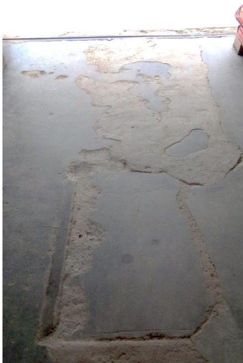
Figura 3 Piso de almacén - área de recepción
