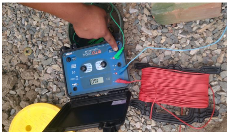
Figura 15: Medición con el Teluro metro.
