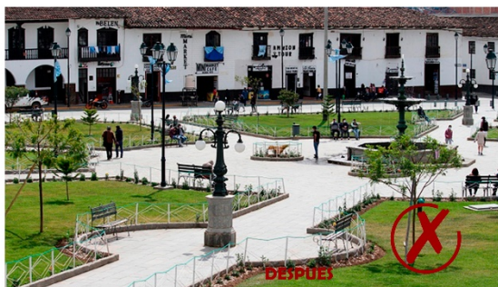
ELIMINACION DEL CARACTER PRINCIPAL DEL ESPACIO, COMO SU CENTRO, ELEMENTOS NO CORRESPONDIENTES AL CONTEXTO, COMO BOLARDOS METALICOS, POCO DURADEROS, REDUCCION DE VEGETACION.
