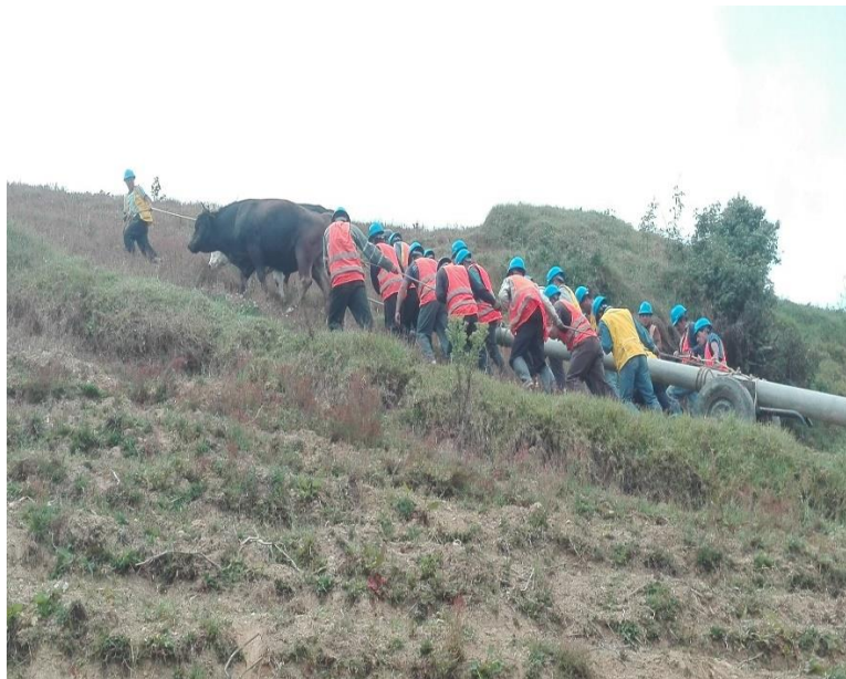
Figura 4. 21. Traslado de postes a su punto de izado. Fuente: Proyecto: Ampliación del servicio de energía rural en la comunidad de Chugur, distrito y provincia de Cutervo - Cajamarca.
