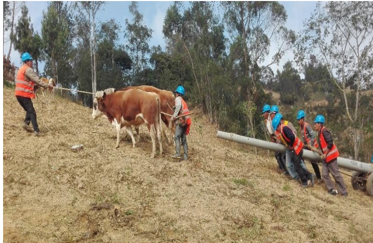
Figura 4. 20. Traslado de postes a su punto de izado. Uso de ganado para trabajos. Fuente: Proyecto: Ampliación del servicio de energía rural en la comunidad de Chugur, distrito y provincia de Cutervo - Cajamarca.
