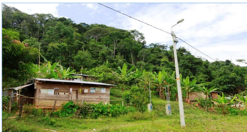
Figura 3. 7. Sistemas Eléctricos Rurales - Zona Selva Fuente: www.minem.gob.pe
