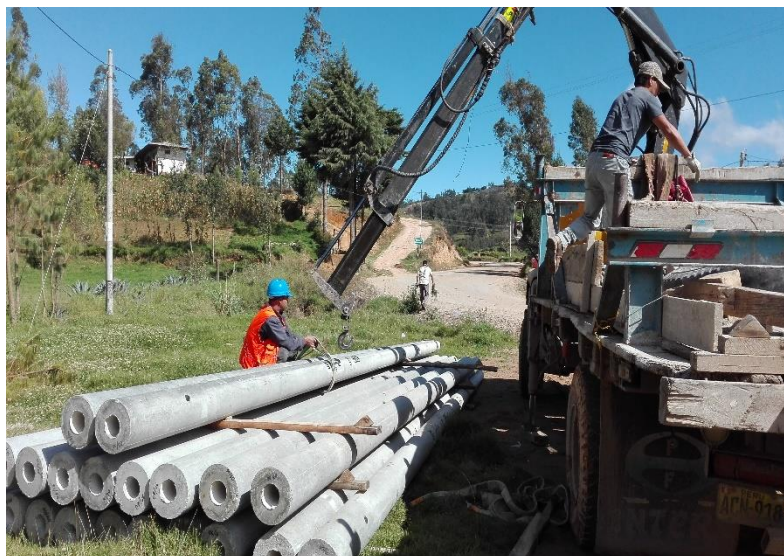
Figura 4. 11. Descarga de postes de concreto, 8m. Fuente: Proyecto Eléctrico - Instalación del sistema de energía eléctrica en el caserío Lirio Chico, distrito y provincia de Cutervo – Cajamarca.
