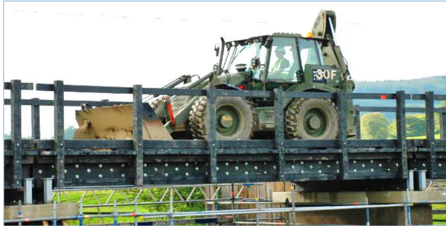
Figura 3. 36. Puente Construido con maderas plásticas. Fuente: www.noticias.masverdedigital.com (Construyen puente en Escocia).
