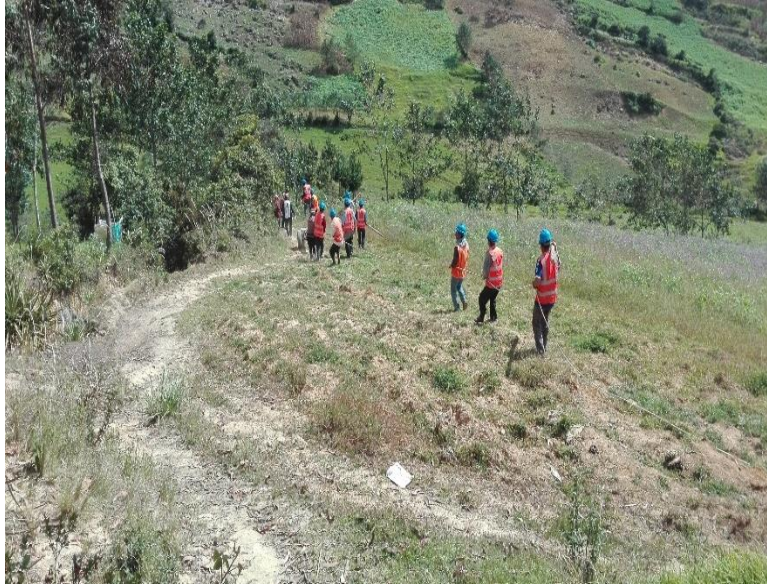
Figura 4. 14. Traslado de postes a su punto de izado. Fuente: Proyecto Eléctrico - Instalación del sistema de energía eléctrica en el caserío Lirio Chico, distrito y provincia de Cutervo – Cajamarca.
