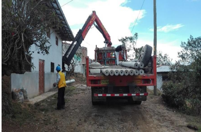
Figura 4. 16. Recepción de postes de CAC 8m. Fuente: Proyecto: Ampliación del servicio de energía rural en la comunidad de Chugur, distrito y provincia de Cutervo - Cajamarca.
