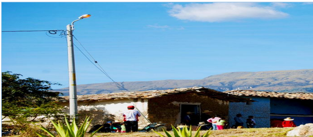
Figura 3. 19. Poste de Hormigón con retenida, luminaria y acometida.
