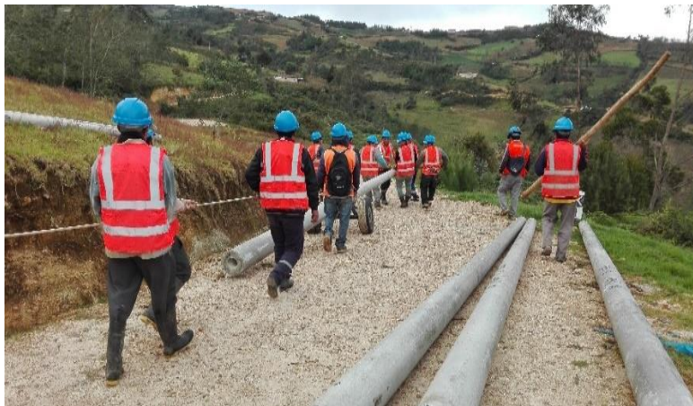
Figura 4. 12. Traslado de postes a su punto de izado. Fuente: Proyecto Eléctrico - Instalación del sistema de energía eléctrica en el caserío Lirio Chico, distrito y provincia de Cutervo – Cajamarca.
