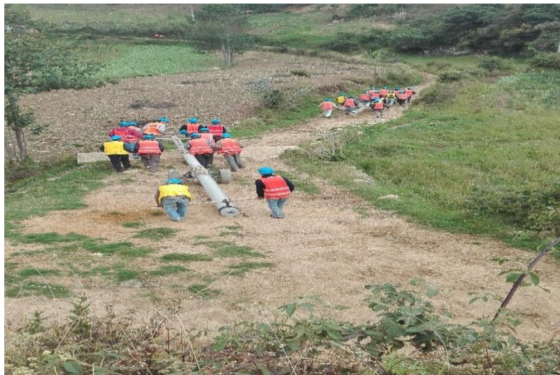
Figura 4. 17. Traslado de postes a su punto de izado. Fuente: Proyecto: Ampliación del servicio de energía rural en la comunidad de Chugur, distrito y provincia de Cutervo - Cajamarca.
