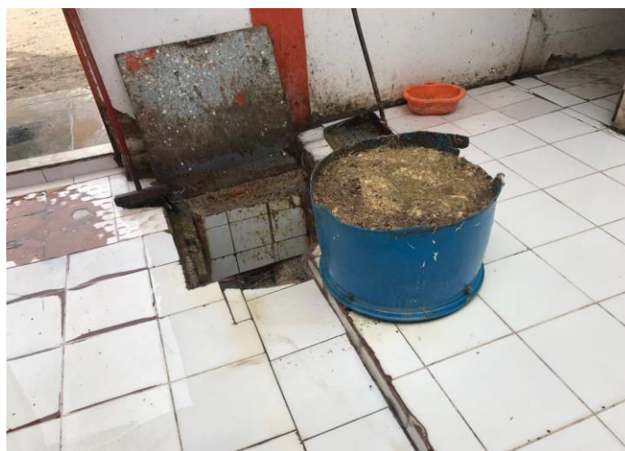
Figura 5- Aguas residuales de la Avícola La Granja C&D S.A.C.
