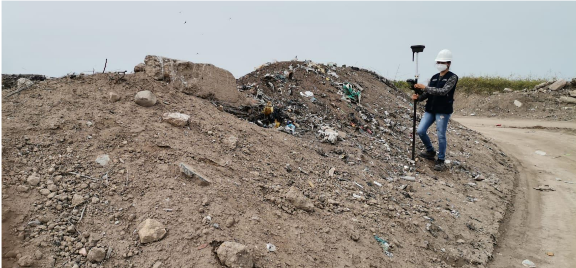
Fotografía 3. Día 2 levantamiento topográfico.
