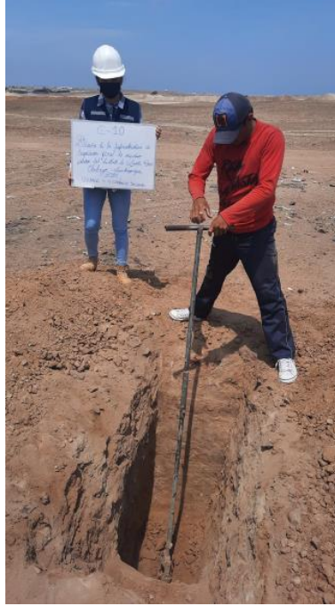
Fotografía 3. Calicata 10. Área proyectada para el relleno sanitario.
