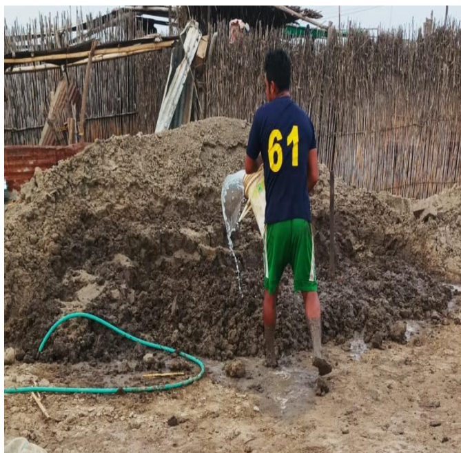
Figura 29. Mezclado de los compuestos en las dosificaciones especificadas
