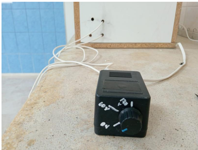
Figura 6 Fuente de voltaje alterno en placa caliente.
