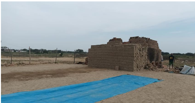
Figura 32. Espacio donde se proceden a secar los bloques de arcilla artesanales por un promedio de 7 días.
