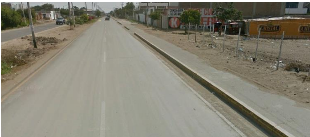
Ilustración 95 - Ciclovía preexistente en Pimentel sin una adecuada señalización (Fuente Google earth)
