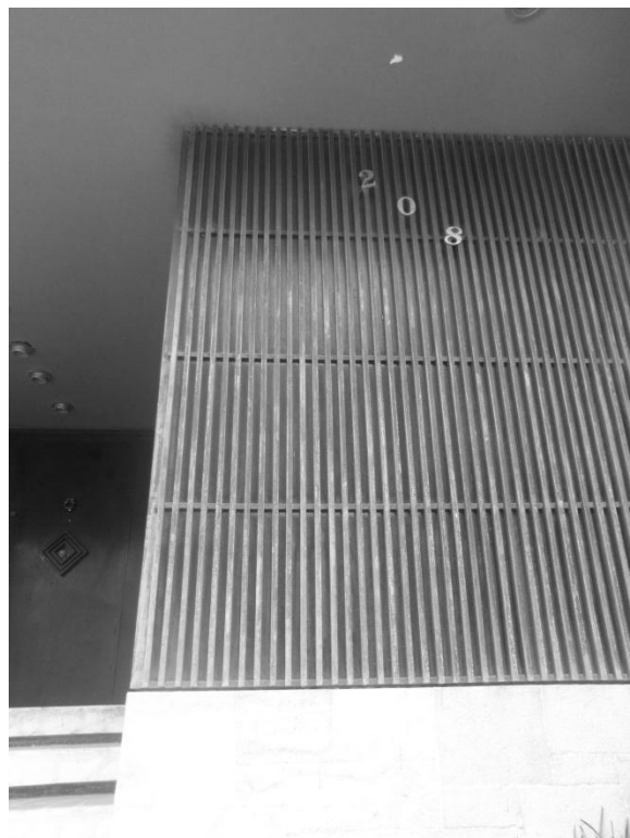
Imagen N° 586. Celosía de madera. Fuente: Propia.
