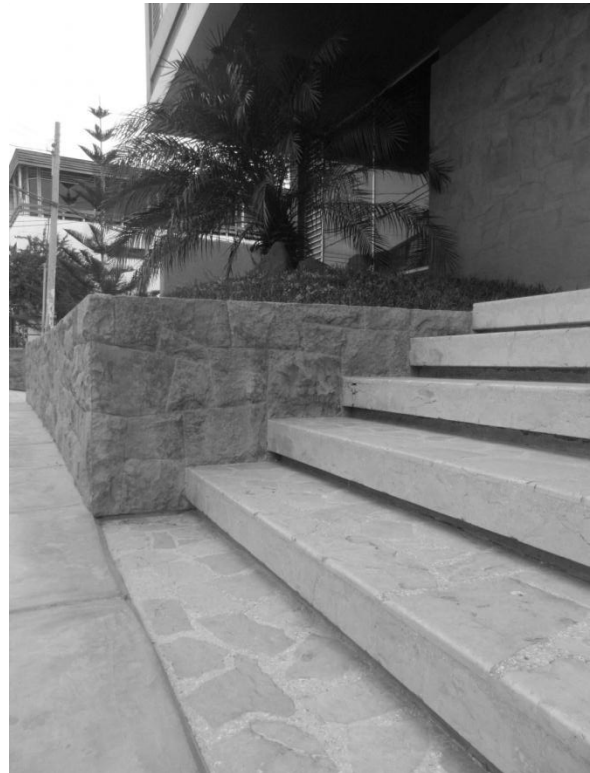
Imagen N° 553. Vista escaleras Fuente: Propia.
