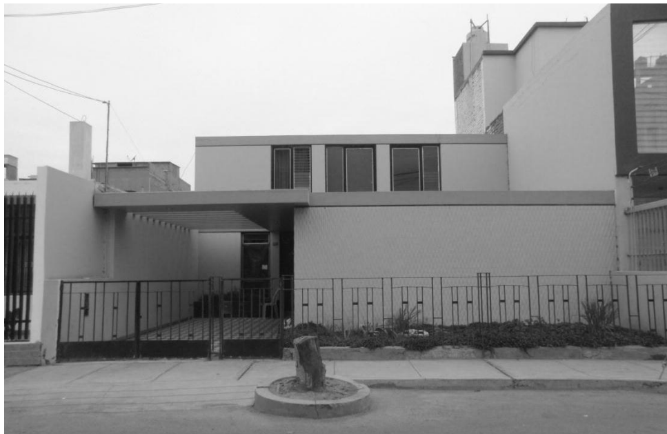
Imagen N° 514. Vista fachada principal. Fuente: Propia.
