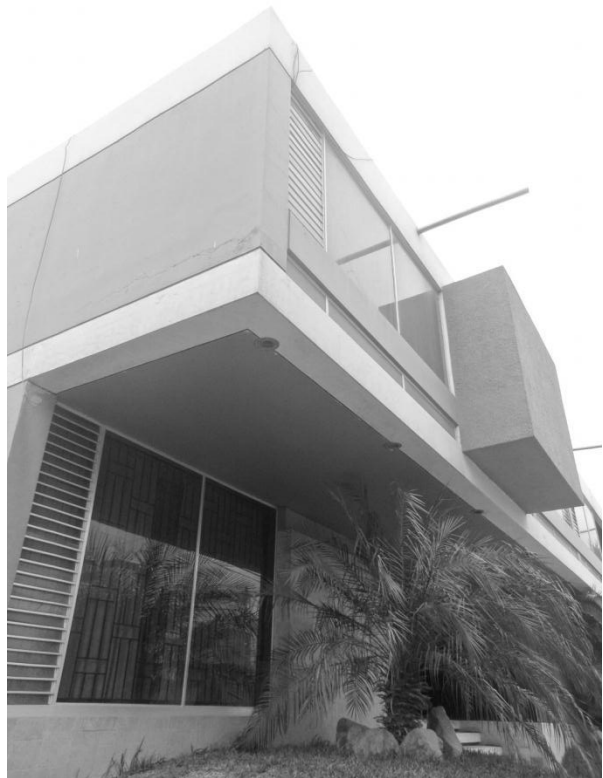
Imagen N° 552. Vista cerramientos. Fuente: Propia.
