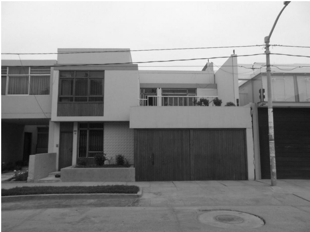
Imagen N° 593. Vista fachada principal. Fuente: Propia.
