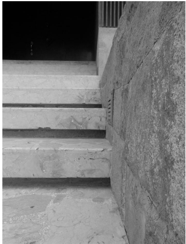
Imagen N° 590. Detalle de gradas de acceso. Fuente: Propia.
