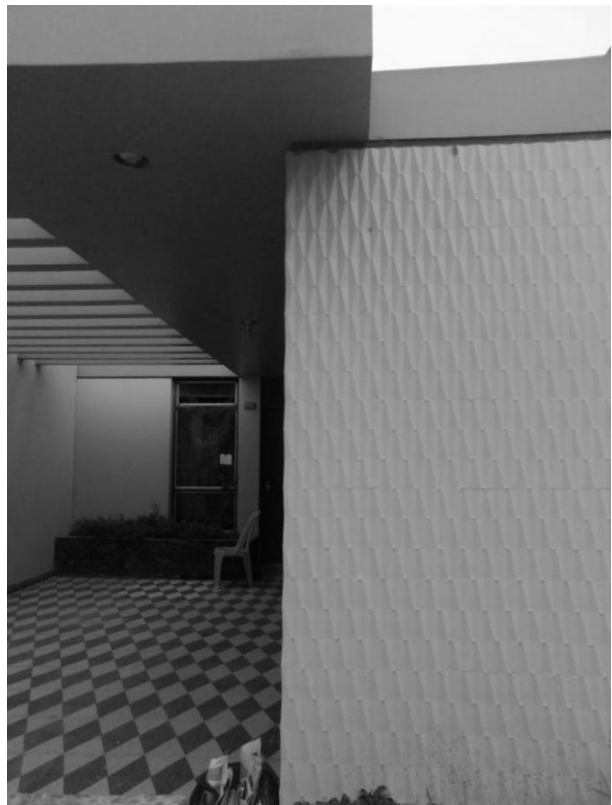
Imagen N° 516. Vista cochera. Fuente: Propia.
