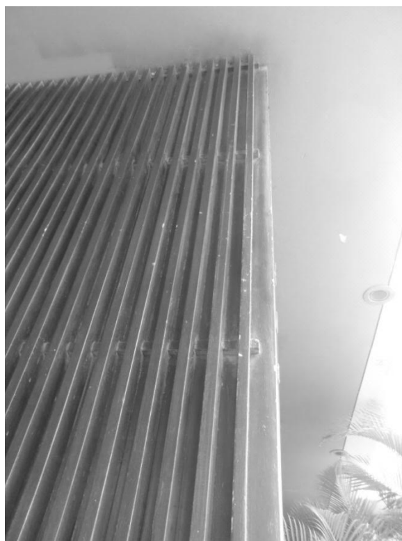
Imagen N° 587. Celosía de madera. Fuente: Propia.
