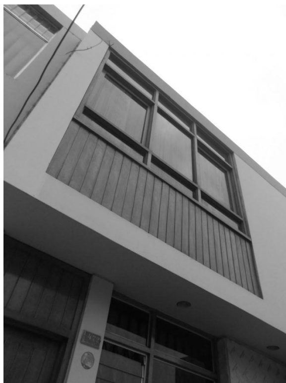
Imagen N° 594. Vista detalle carpintería de fachada. Fuente: Propia.
