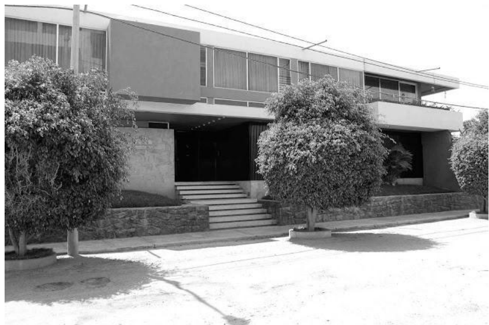
Imagen N° 551. Vista fachada principal. Fuente: La forma moderna en Latinoamérica.
