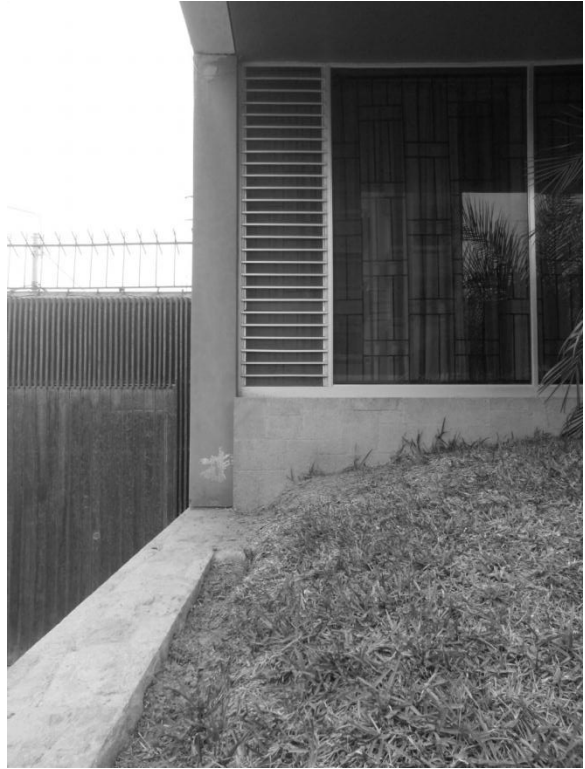
Imagen N° 554. Vista escaleras Fuente: Propia.
