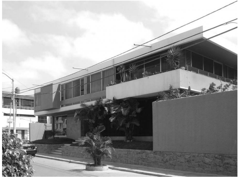
Imagen N° 550. Vista fachada principal. Fuente: La forma moderna en Latinoamérica.
