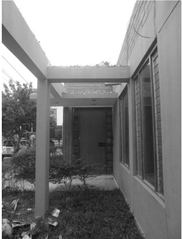
Imagen N° 638. Acceso, vigas. Fuente: Propia.
