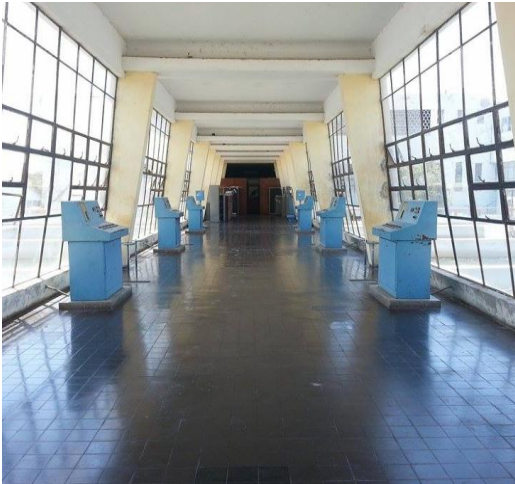
Figura N° 66. Sala de mando PTAP N°1 Fuente: Gerencia operacional EPSEL S.A.
