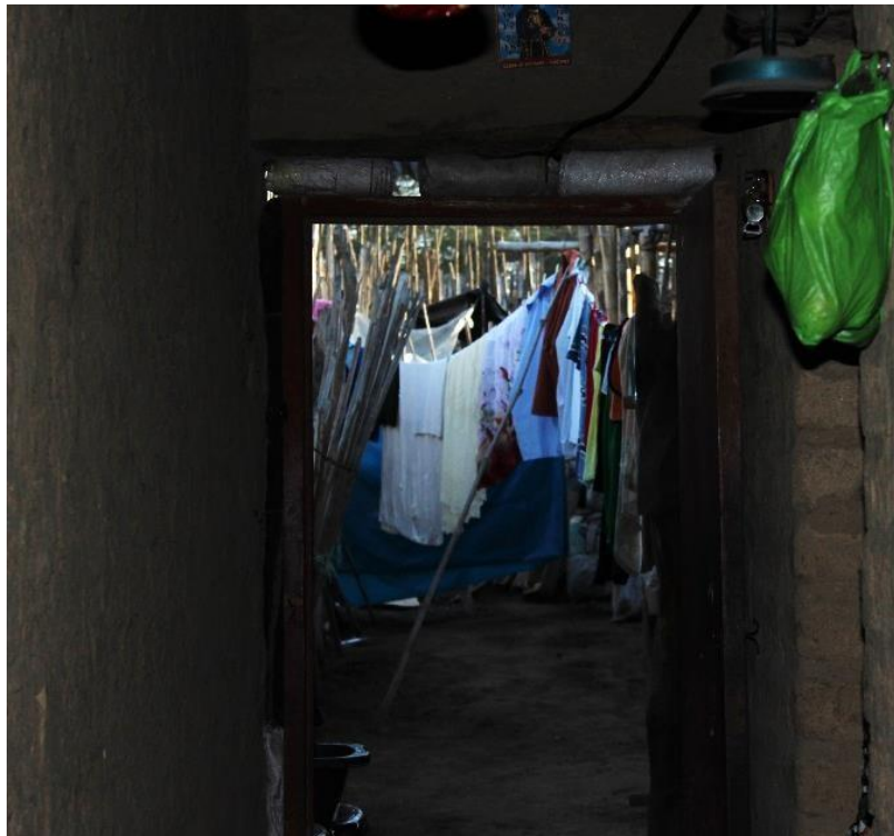
Ilustración 47 Corredor tipología vivienda en esquina. Túcume Viejo.Fuente:Propia
