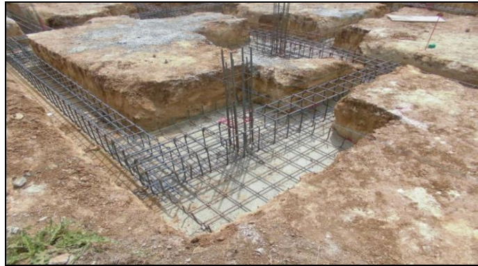
Figura 28: Cimientos y sobre cimientos
