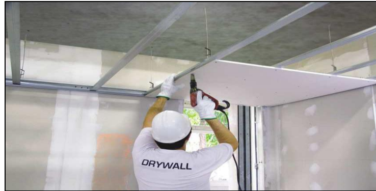
Figura 30: Muros de drywall
