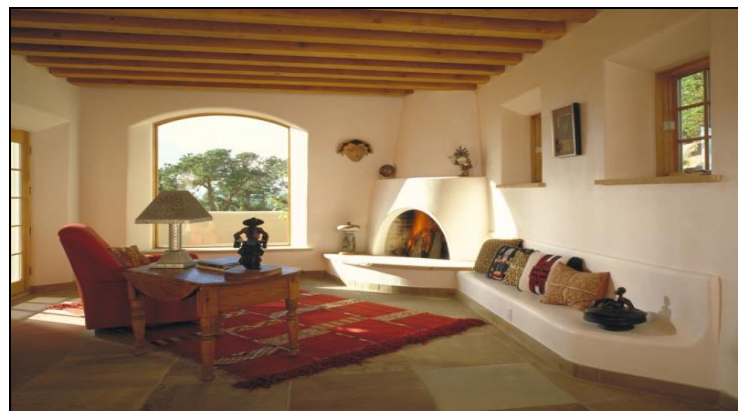
Figura 31: Muros de adobe revestido enlucido en quinua
