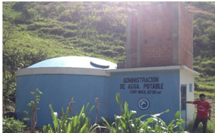
FOTOGRAFÍA N° 17: Reservorio Existente en el Sector Central (V=87 m 3 )
