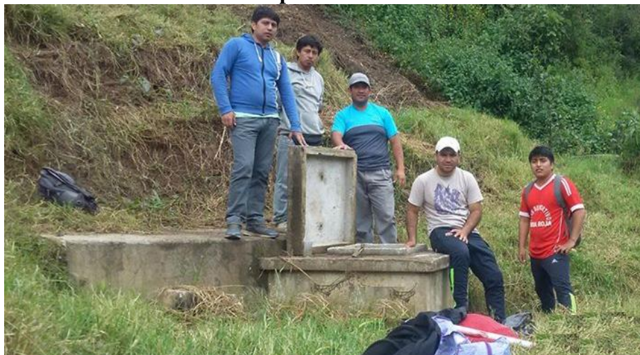
FOTOGRAFÍA N° 10: Captación de Ladera Existente - Minas
