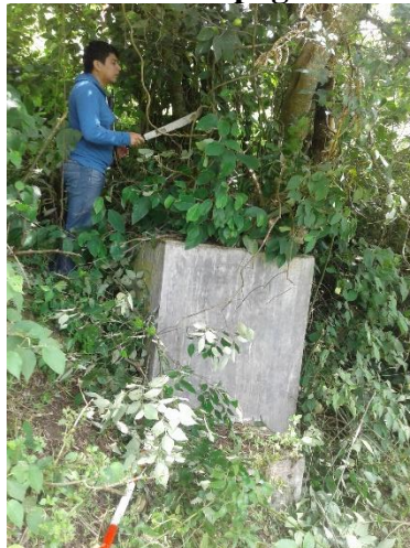
FOTOGRAFÍA N° 7: Levantamiento Topográfico de infraestructura existente
