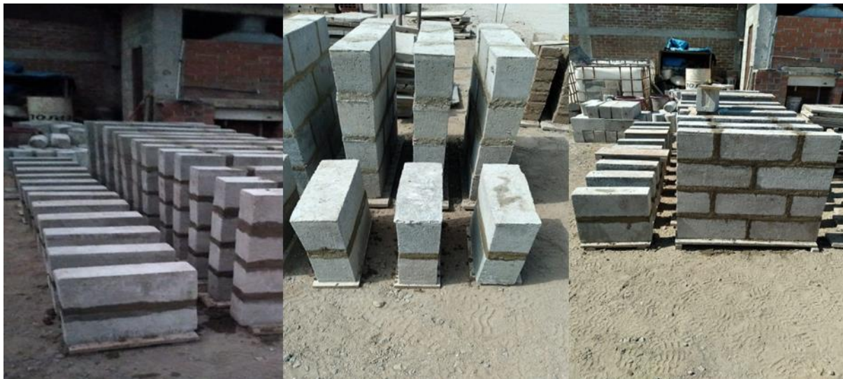
Ilustración 43: Preparación de prismas
