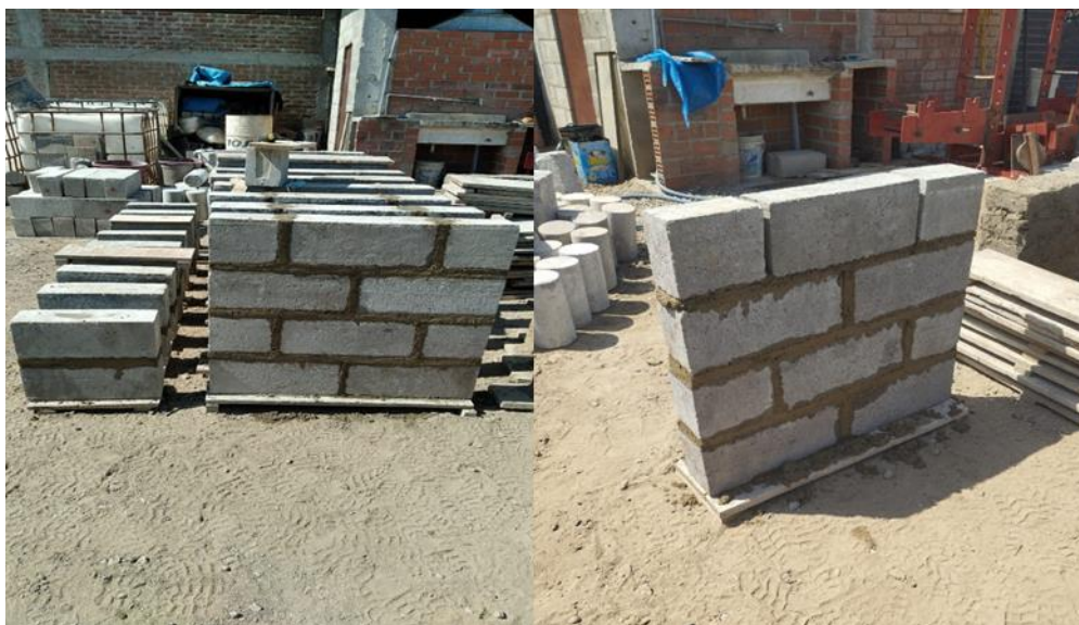
Ilustración 45: Construcción de muretes
