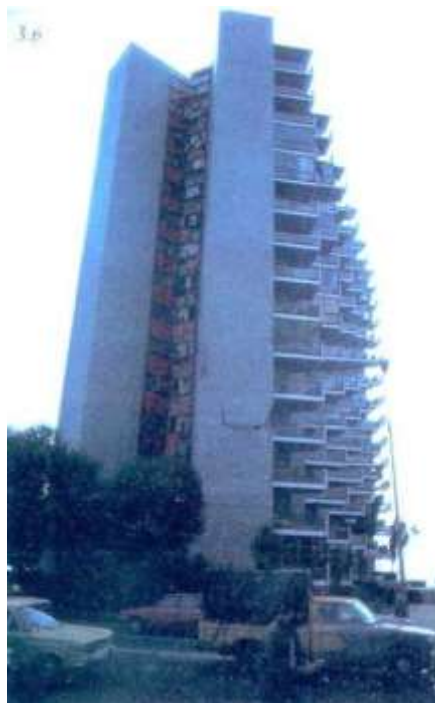
Ilustración 24 Edificio "Acapulco" después del terremoto en 1985 - Chile
