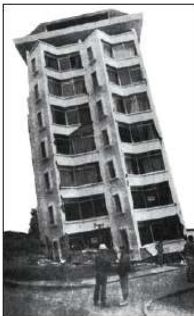
Ilustración 8 Edificio "El Faro" después del terremoto de Chile de 1985
