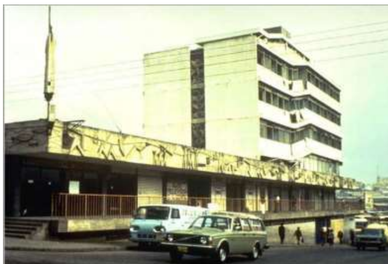
Ilustración 35 Hotel "Terminal" después del terremoto de Guatemala de 1967
