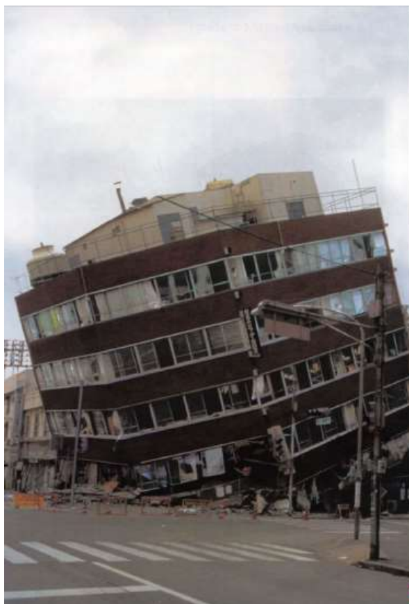
Ilustración 26 Edificio en esquina afectado por el terremoto en Kobe, Japón 1995
