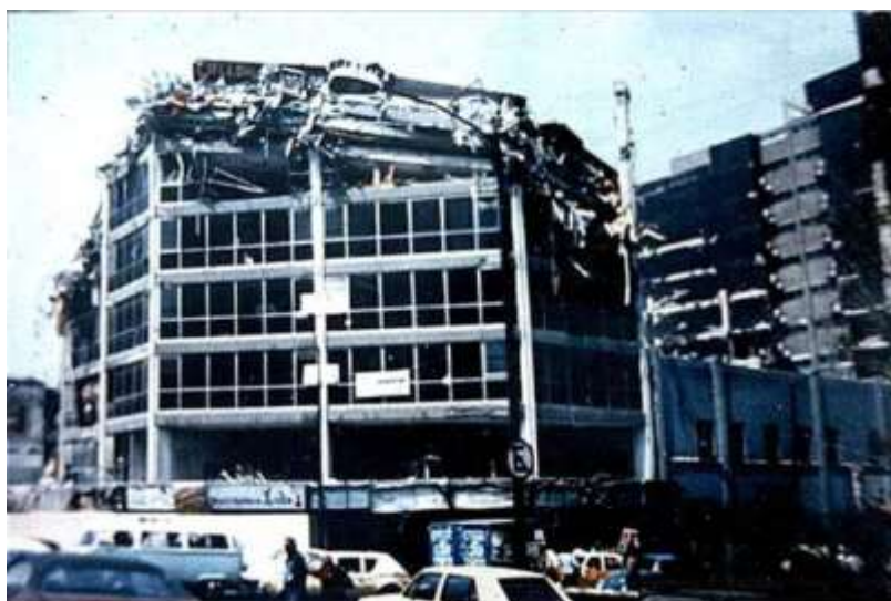
Ilustración 27 Edificio en esquina afectado por el terremoto en México en 1985
