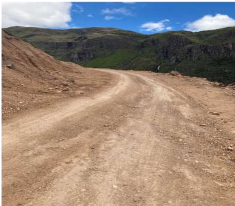
Ilustración 6: Estado actual de la carretera tramo Marampampa - Culdén.
