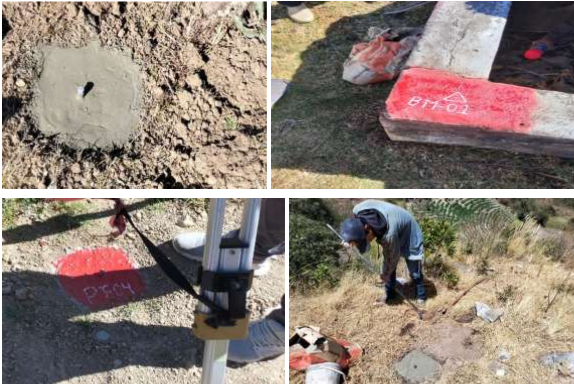
Ilustración 20: Colocación de BM's.
