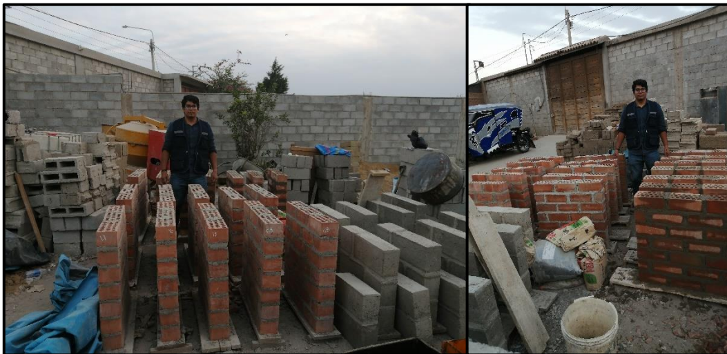
Imagen 42. Muestras terminadas de los muretes de albañilería.
