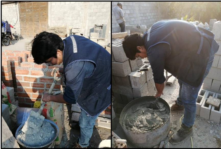
Imagen 41. Procedimiento de la elaboración de muretes de albañilería.
