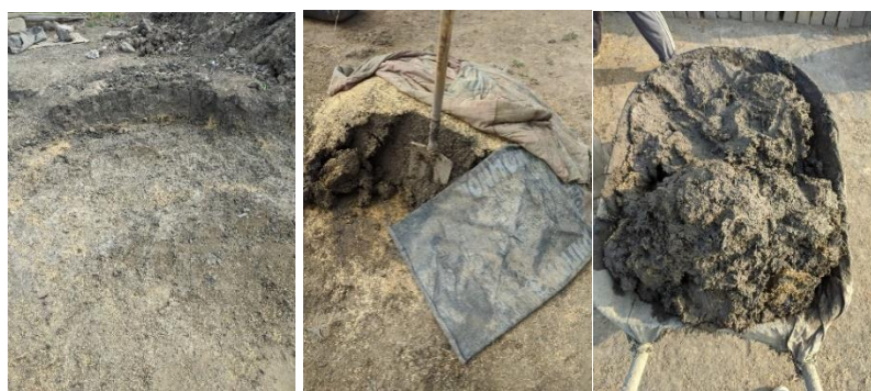
Ilustración 44: (a), (b) y (c) Proceso para hacer la masa.
