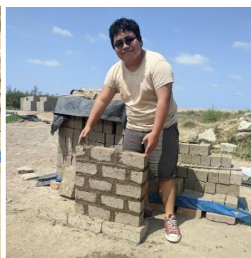
Ilustración 64: (a) y (b) Fabricación del murete de tierra reforzada.
