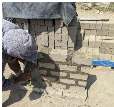
Ilustración 64: (a) y (b) Fabricación del murete de tierra reforzada.
