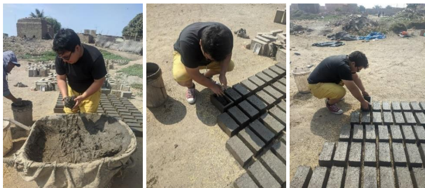
Ilustración 46: (a), (b) y (c) Proceso de fabricación de las unidades de tierra reforzada.
