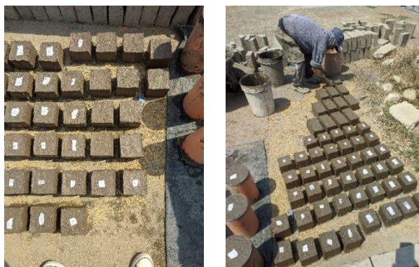
Ilustración 54: Moldeado de las unidades de tierra reforzada.
