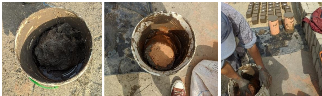
Ilustración 53: (a), (b) y (c) Adición del ladrillo triturado a la mezcla.
