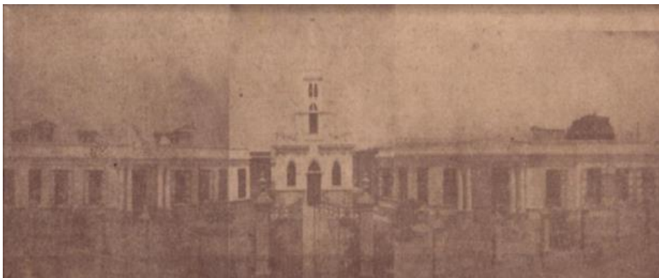
Imagen 11. Vista principal del hospital las Mercedes, término de construcción de la capilla
