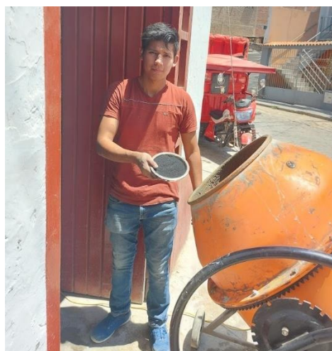
Figura 77: Agregando porcentaje de biocarbón a la mezcla de concreto
