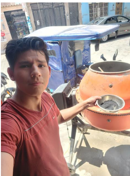
Figura 91: Tesista agregando biocarbón a la mezcladora de concreto
