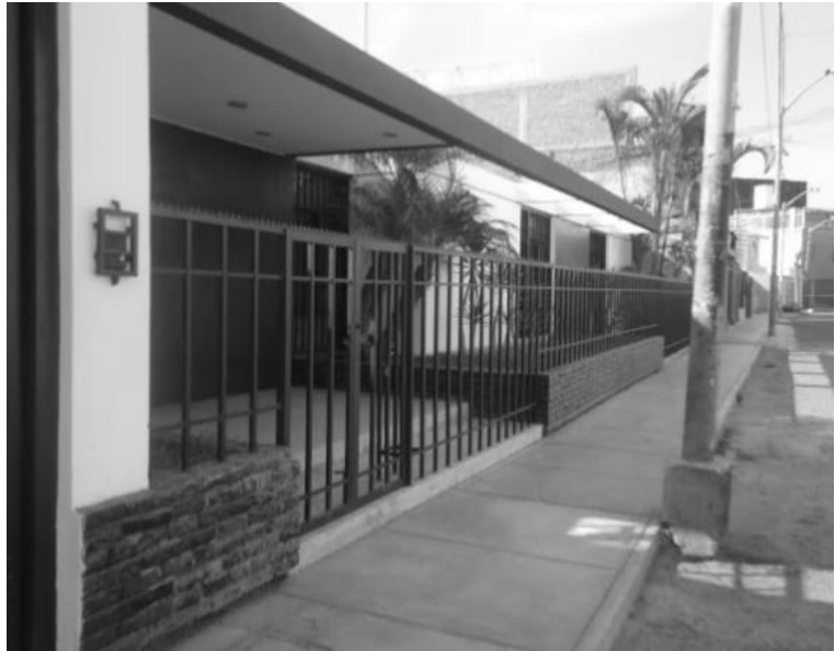
Imagen N° 317. Aproximación a la vivienda. Fuente: Elaboración propia.
