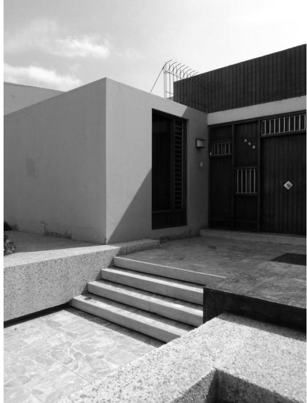
Imagen N° 151. Acceso peatonal. Fuente: Pool Porta.
