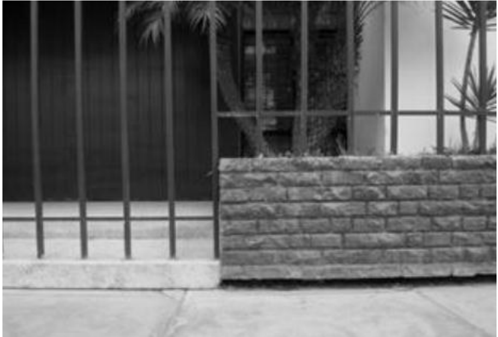
Imagen N° 351. Detalle jardinera. Fuente: Marcia Kong, Paola Torres.
