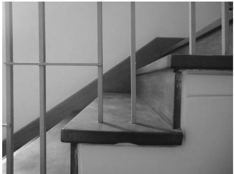
Imagen N° 310. Detalle escaleras. Fuente: Propia.
