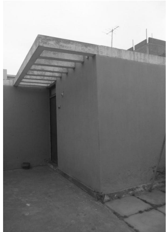
Imagen N° 362. Acceso principal. Vigas. Fuente: Propia
