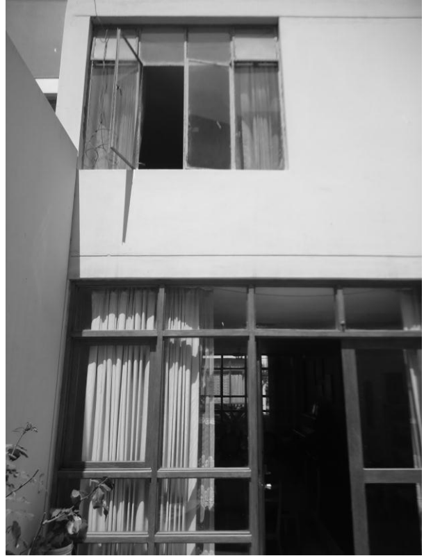
Imagen N° 291. Vista de carpintería s. Fuente: Propia.
