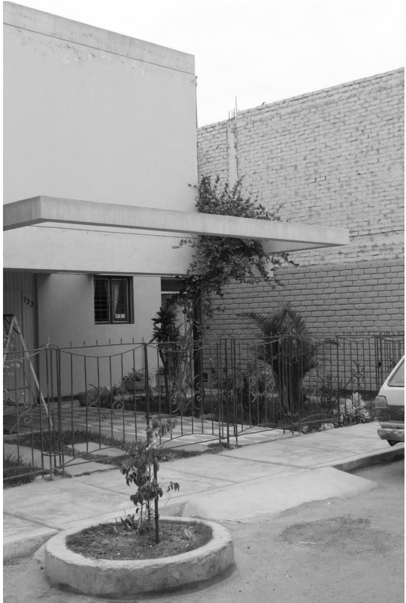
Imagen N° 443. Vista viga exterior. Fuente: Propia.
