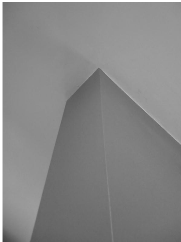
Imagen N°289. Detalle de encuentro de muro con losa. Fuente: Propia.
