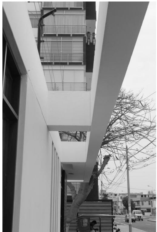
Imagen N° 429. Detalle de vigas. Fuente: Propia.
