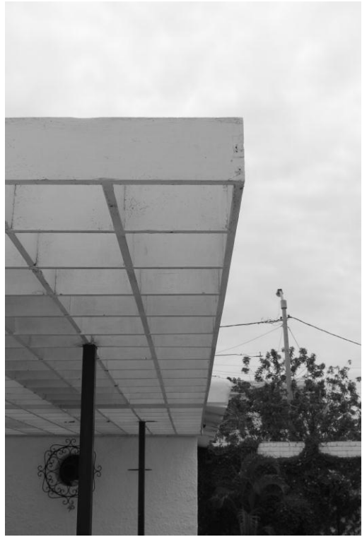
Imagen N° 432. Cubierta - exteriores. Fuente: Propia.
