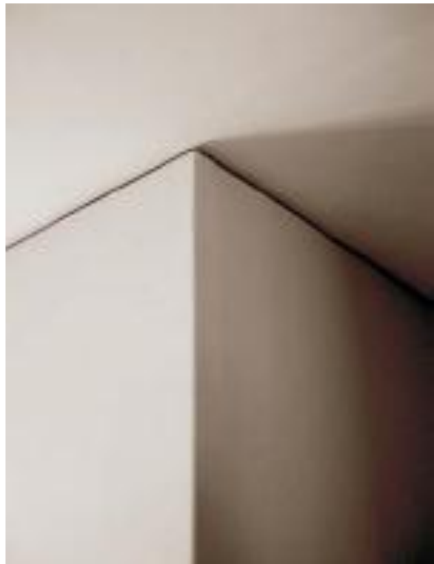
Imagen N° 175. Encuentro muro con losa. Fuente: Davis Soza.
