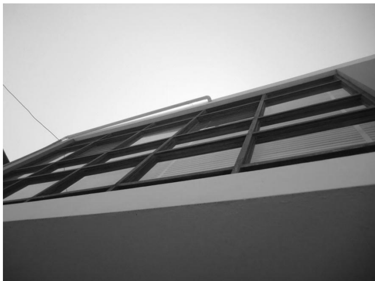
Imagen 266. Carpintería de fachada. Fuente: Elaboración propia.
