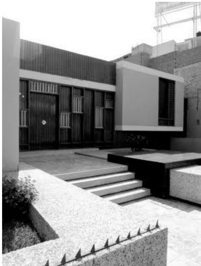
Imagen N° 150. Acceso peatonal. Fuente: Pool Porta.
