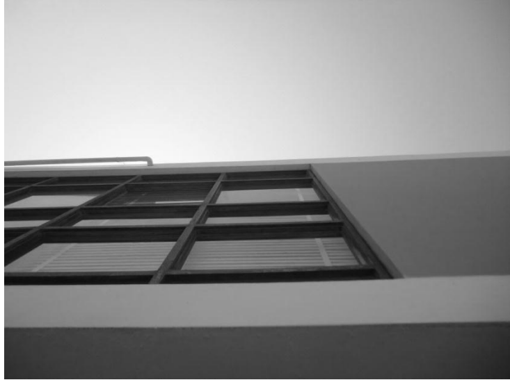
Imagen N° 294. Carpintería de madera – fachada principal. Fuente: Propia
