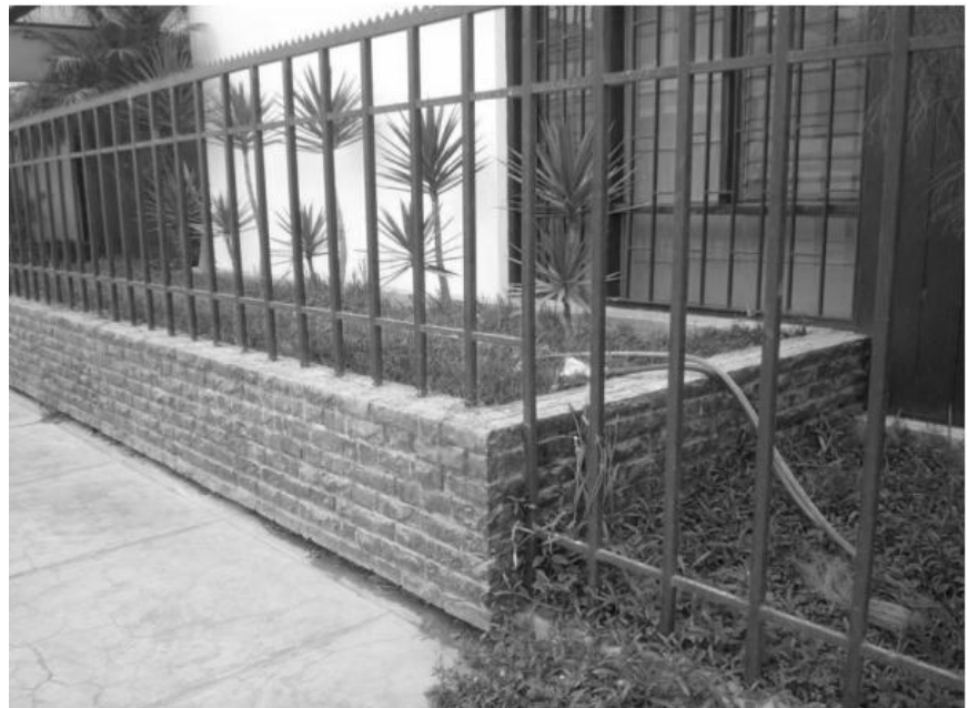
Imagen N° 352. Detalle jardinera. Fuente: Marcia Kong, Paola Torres.
