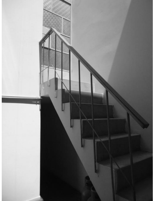
Imagen N° 311. Escaleras de servicio. Fuente: Propia.
