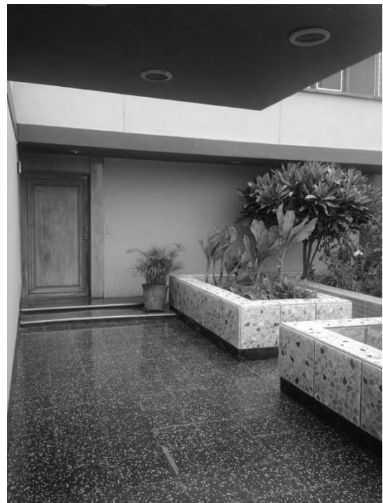
Imagen N° 194. Vista acceso principal. Fuente: Elaboración propia.
