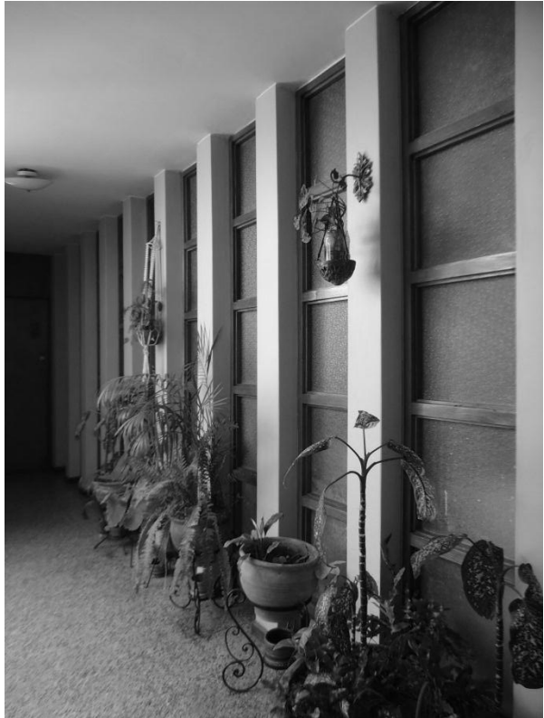
Imagen 267. Carpintería de fachada. Fuente: Elaboración propia.
