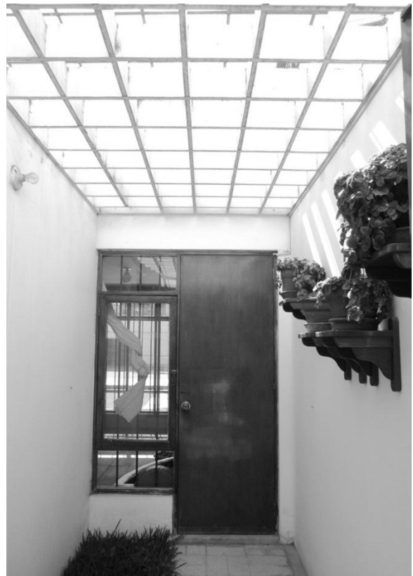
Imagen N° 436. Vista patio - dormitorios. Fuente: Propia.
