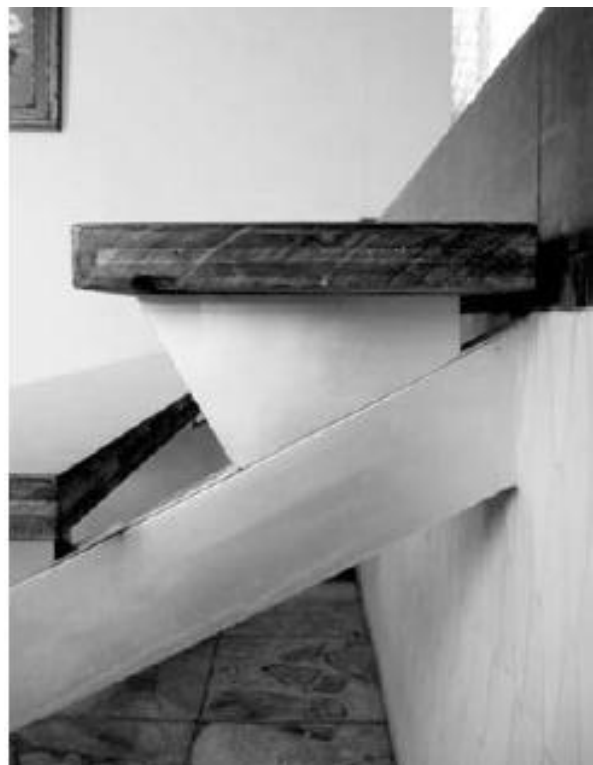
Imagen N° 190. Detalle escaleras. Fuente: David Soza.
