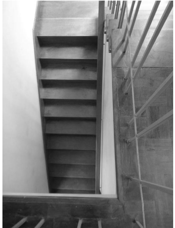
Imagen N° 309. Escaleras principales. Fuente: Propia.
