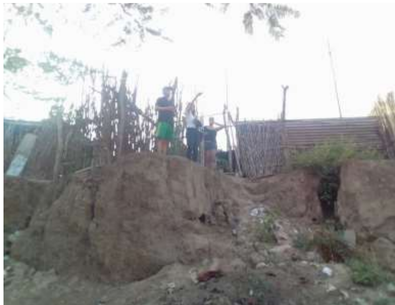
IMAGEN 4. Margen derecho KM 0+980
