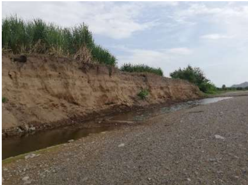
IMAGEN 6. Margen Izquierda Km 3+020
