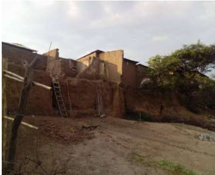
Imagen 3. Margen derecho KM 0+960
