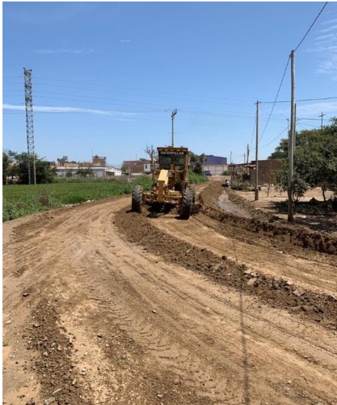
Ilustración 88: Perfilado del ancho de la vía con Motoniveladora
