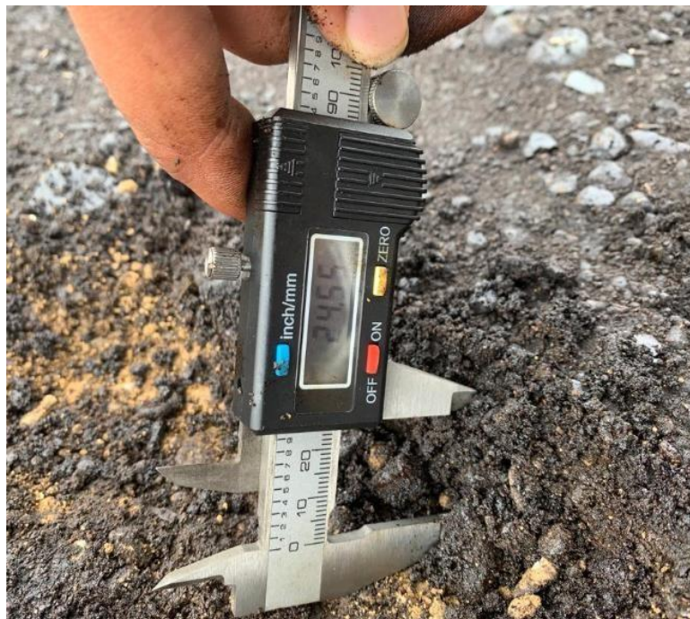
Anexo N°02.148: Penetración 24.55mm, progresiva 0+090km
