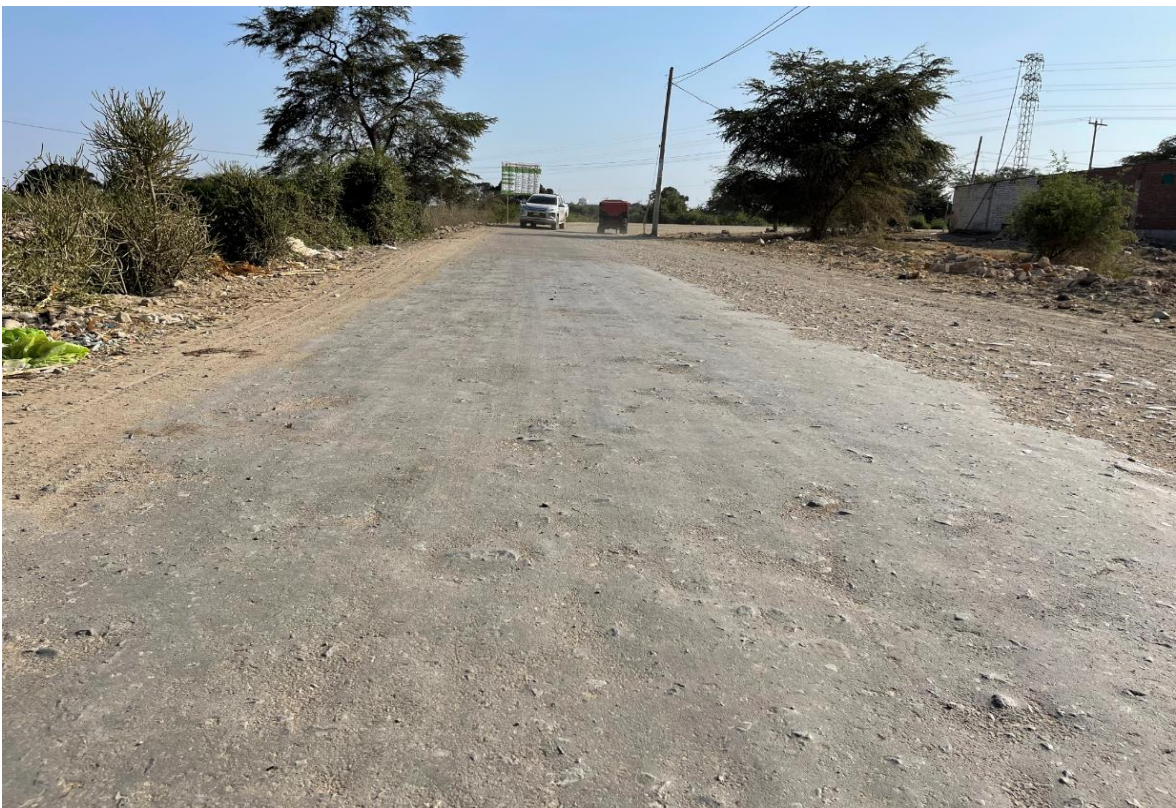
Ilustración 160: Presencia del agregado grueso del afirmado en la superficie de la imprimación reforzada con MC-30
