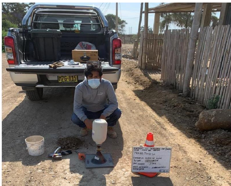
Anexo N°02.86: Ensayo de densidad de campo, progresiva 0+050km
