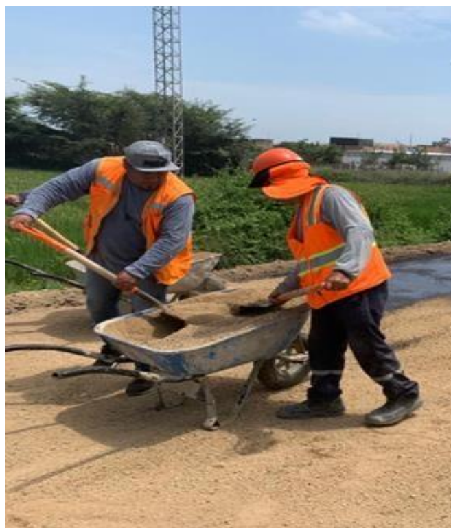
Ilustración 111: Transporte y colocación de arena menor a 5mm
