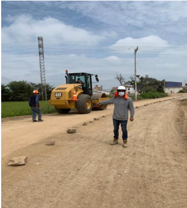
Ilustración 112: Compactación final mediante rodillo liso de 0+000km a 0+070km
