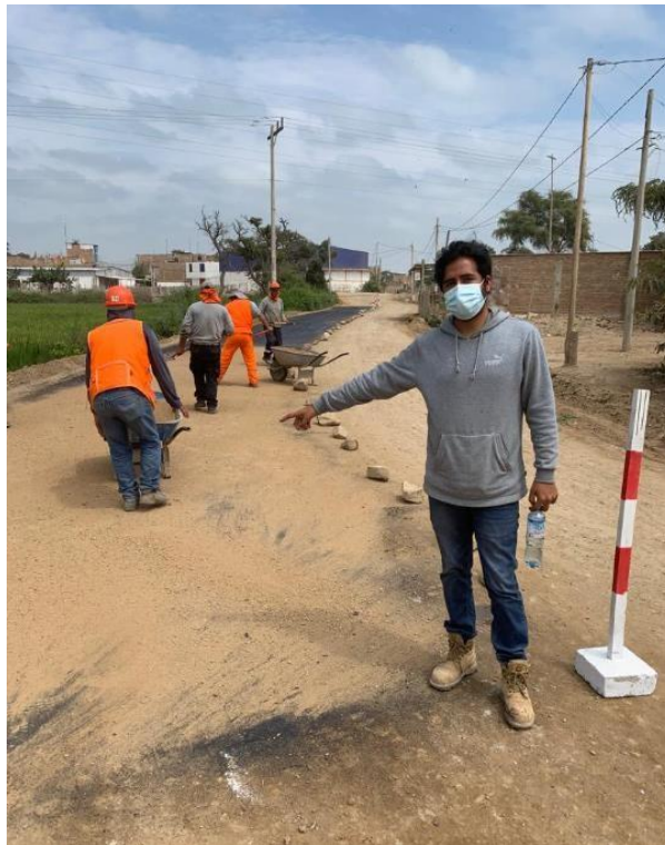
Ilustración 106: Transporte y colocación de la arena
