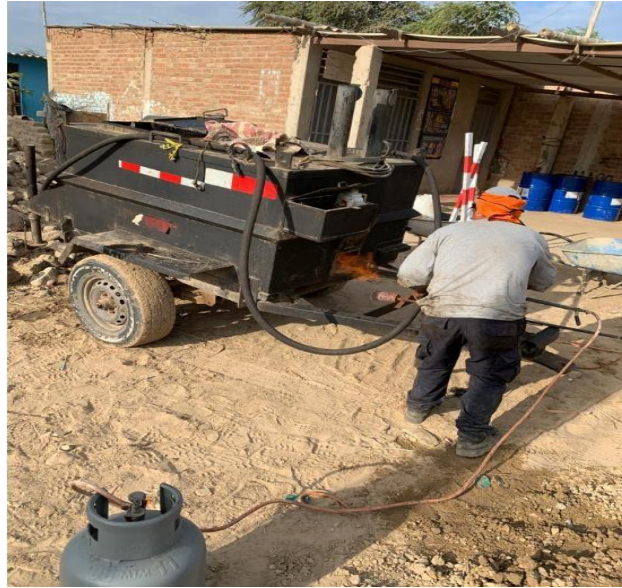
Anexo N°02.90: Calentado de la cocina asfáltica y la emulsión mediante 2 balones de gas
