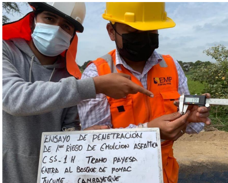
Anexo N°02.105: Penetración de 1.79mm, progresiva 0+070km
