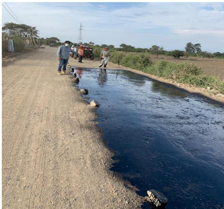
Ilustración 129: Imprimación con MC-30
