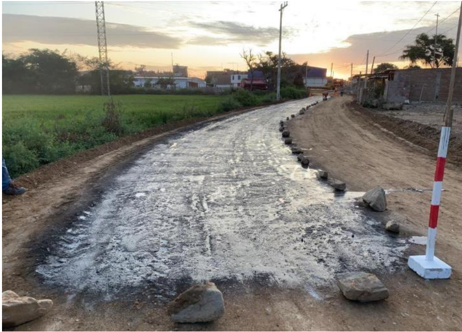
Anexo N°02.94: Imprimación con emulsión CSS-1h en los primeros 70 metros lineales
