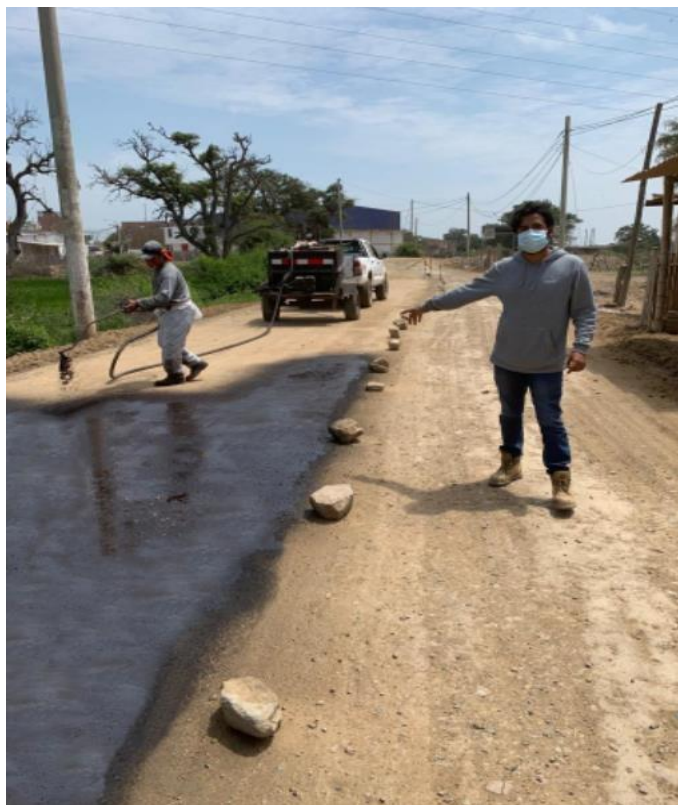
Ilustración 109: Segundo riego de emulsión asfáltica CSS-1h
