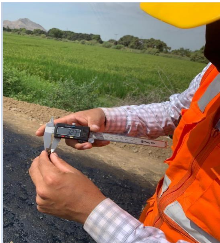
Anexo N°02.100: Penetración de 3.23mm, progresiva 0+030km
