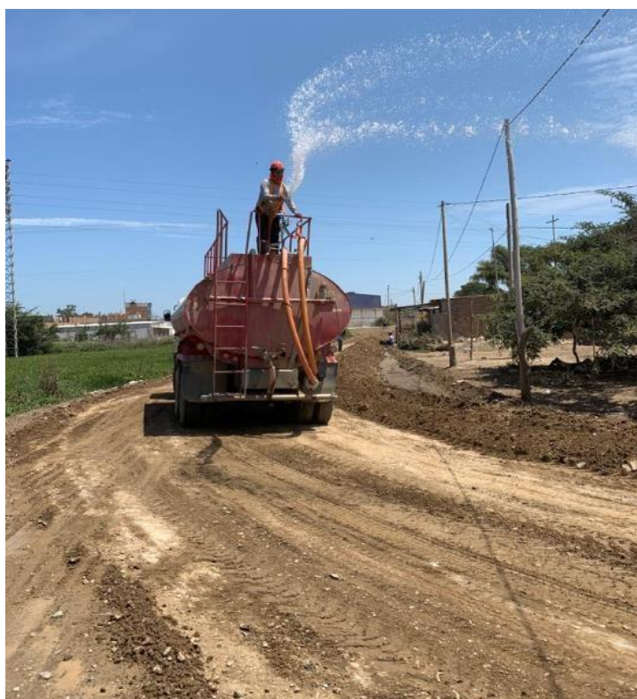
Anexo N°02.130: Riego con cisterna de 2500gln
