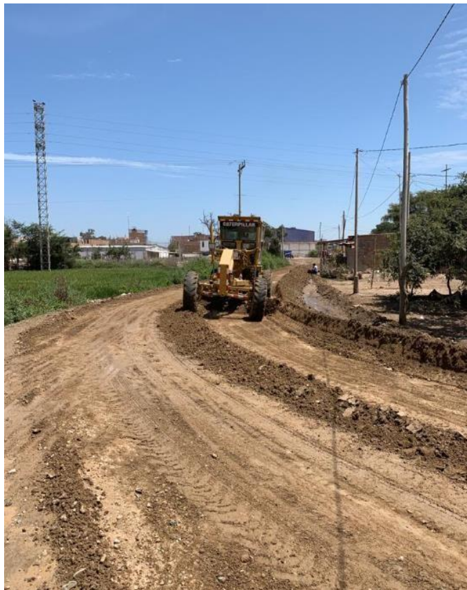
Anexo N°02.73: Perfilado del ancho de la vía con Motoniveladora
