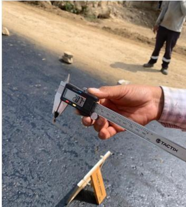
Anexo N°02.104: Penetración de 2.07mm, progresiva 0+060km
