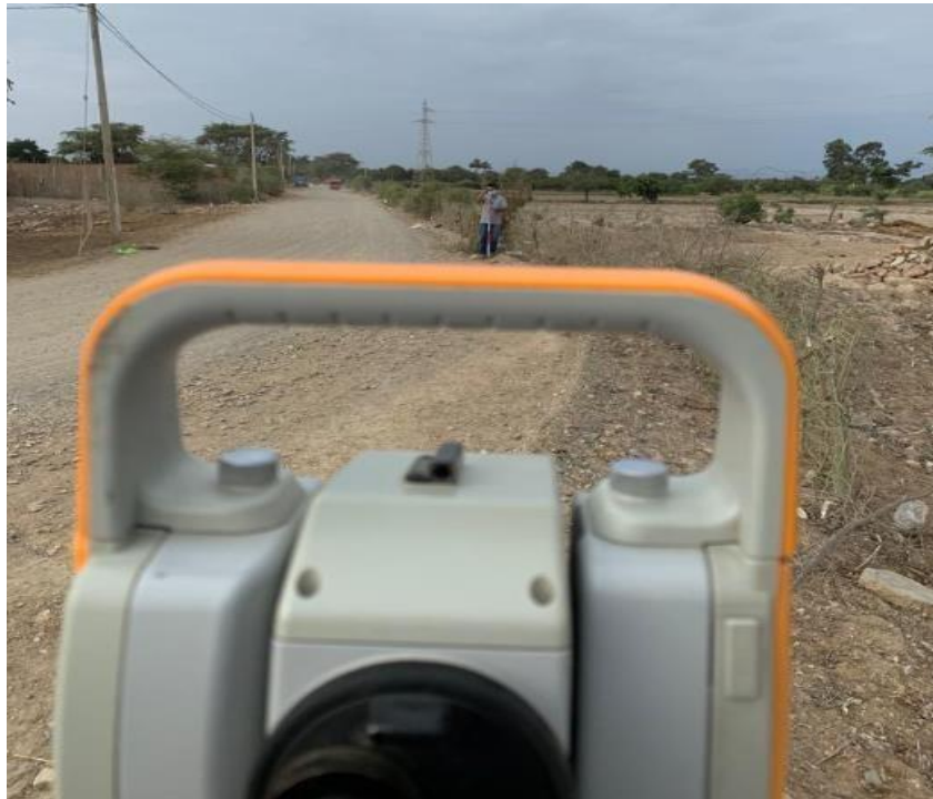
Ilustración 116: Levantamiento topográfico con estación total y prismas
