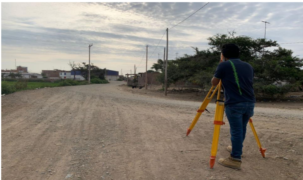
Ilustración 83: Levantamiento topográfico con estación total y prisma
