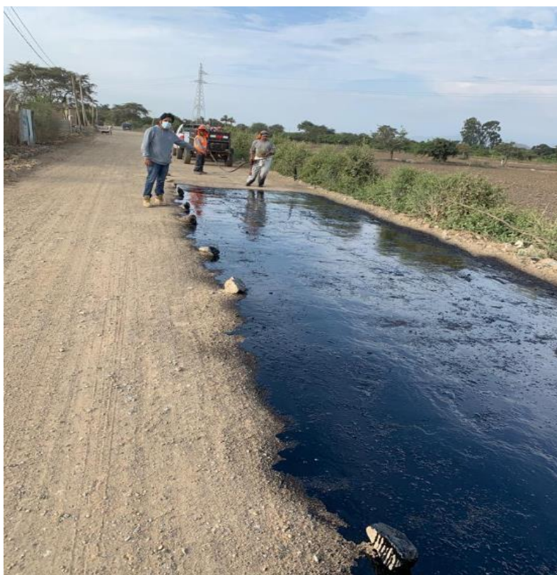
Anexo N°02.146: Imprimación con MC-30
