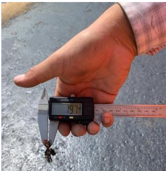
Anexo N°02.97: Penetración de 1.97mm, progresiva 0+010km
