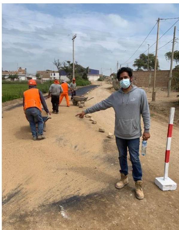
Anexo N°02.107: Transporte y colocación de la arena
