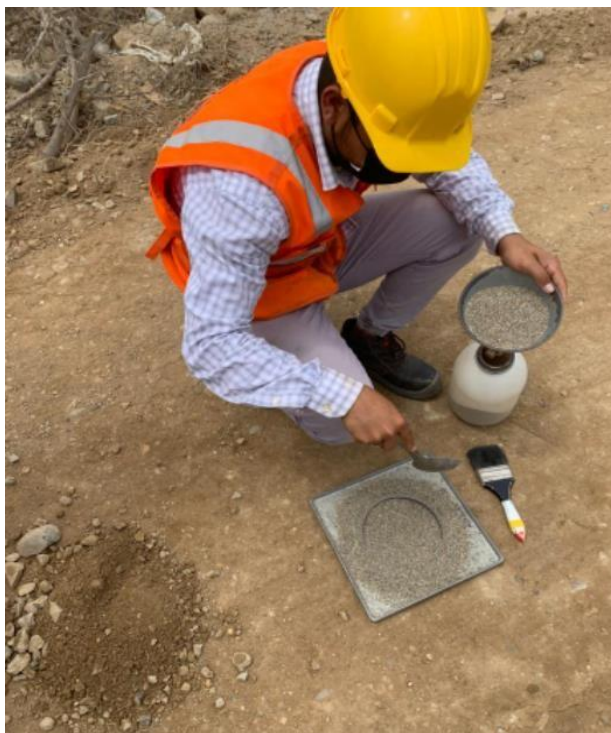
Anexo N°02.141: Ensayo de densidad de campo, progresiva 0+130km
