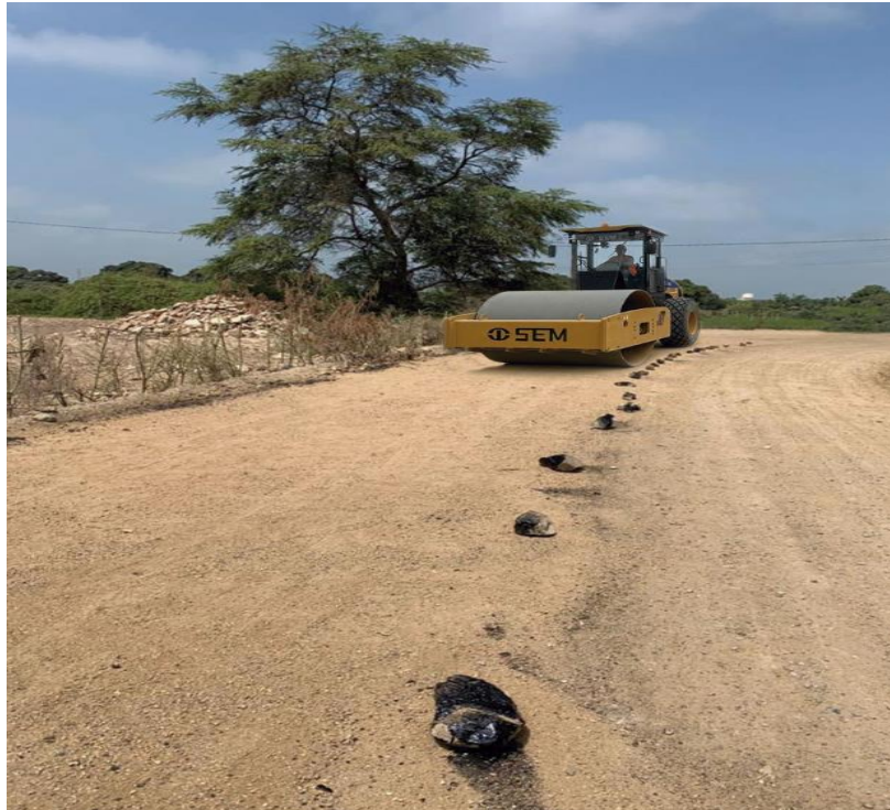
Anexo N°02.159: Compactación final con rodillo liso vibratorio
