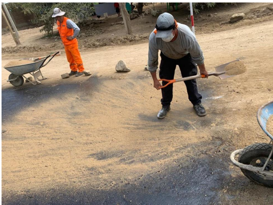
Anexo N°02.106: Colocación de arena triturada menor a 5mm
