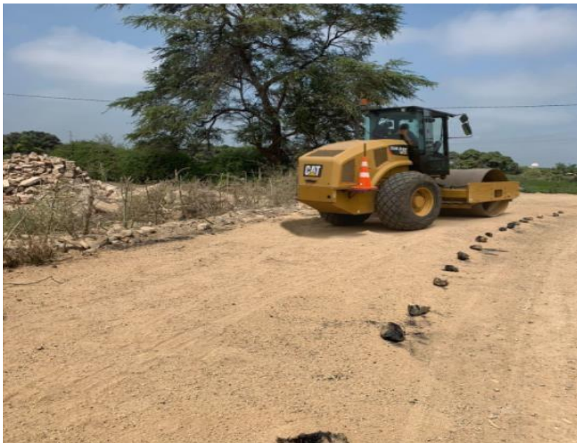
Ilustración 139: Compactación mediante rodillo liso
