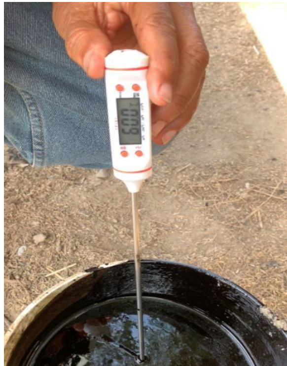
Anexo N°02.157: Medición de la temperatura tras ser calentada en la cocina asfáltica(60.0°C)
