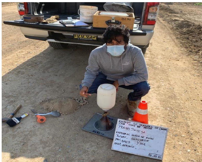
Anexo N°02.82: Ensayo de densidad de campo, progresiva 0+010km
