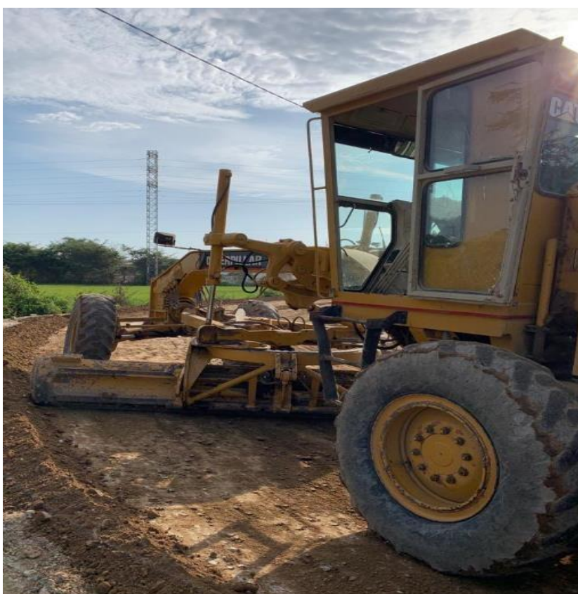
Anexo N°02.134: Perfilado conforme a la pendiente y bombeo
