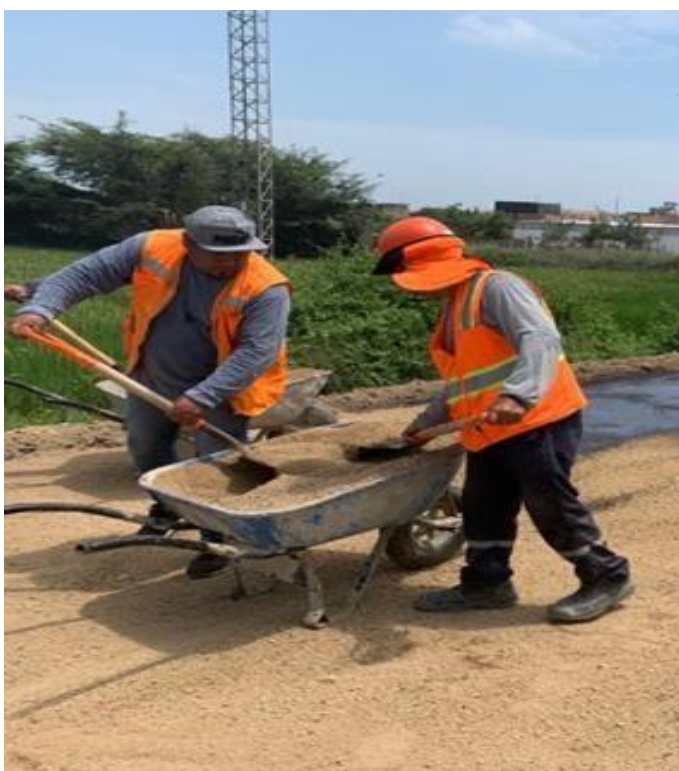
Anexo N°02.113: Transporte y colocación de arena menor a 5mm
