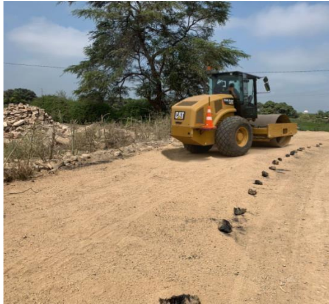
Anexo N°02.156: Compactación mediante rodillo liso
