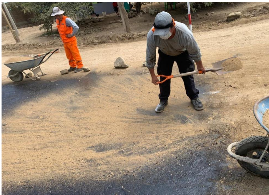
Ilustración 105: Colocación de arena triturada menor a 5mm
