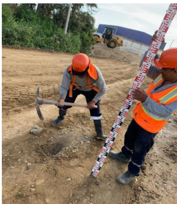
Ilustración 91: Colocación de plantillas
