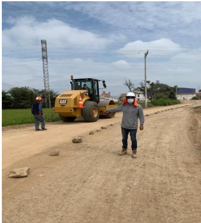
Anexo N°02.114: Compactación final mediante rodillo liso desde progresiva 0+000 hasta 0+07km
