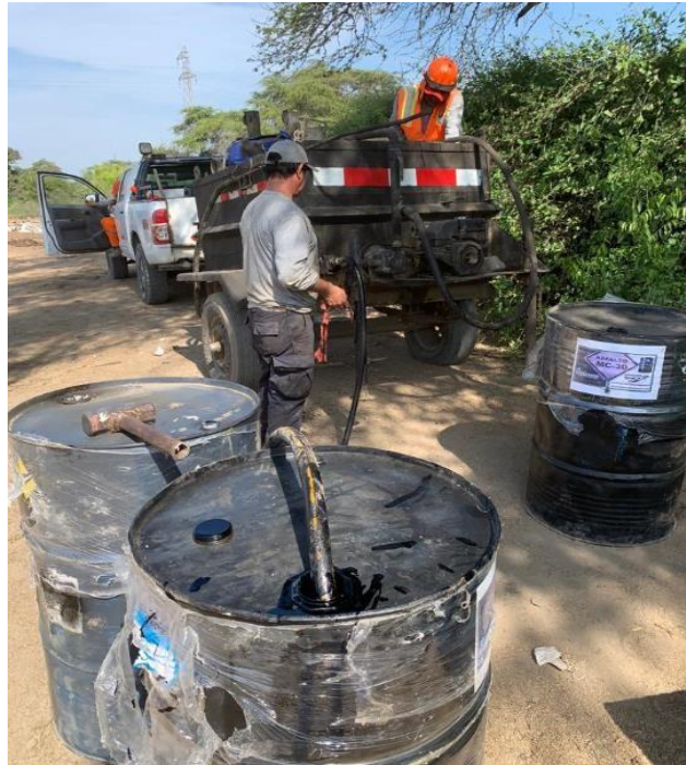
Anexo N°02.143: Colocación del MC-30 a la cocina asfáltica
