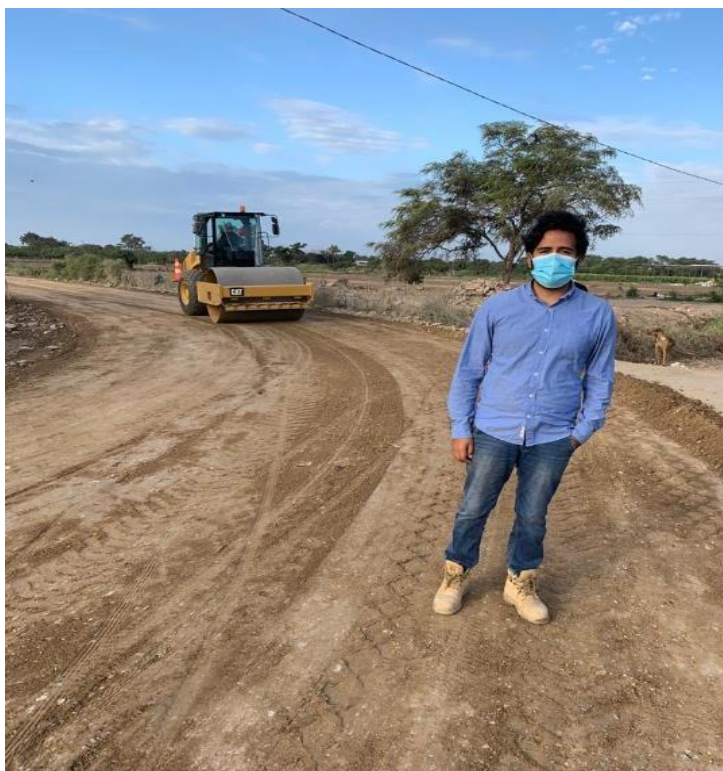
Ilustración 125: Compactación final (95% MDS) del afirmado
