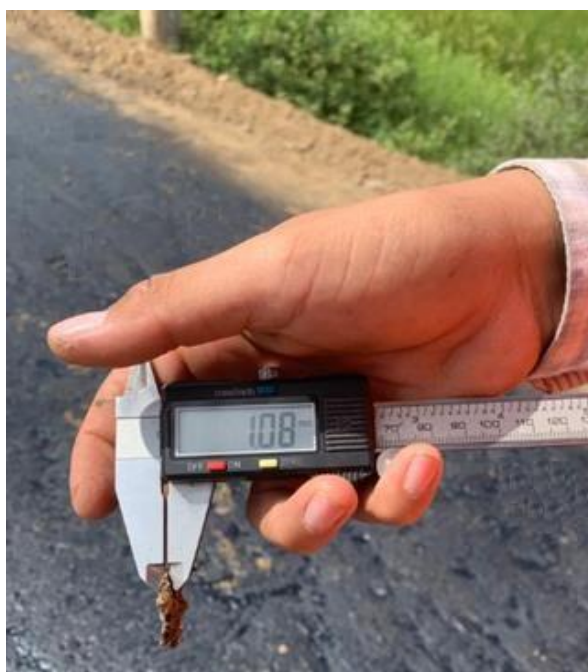
Anexo N°02.101: Penetración de 1.08mm, progresiva 0+040km
