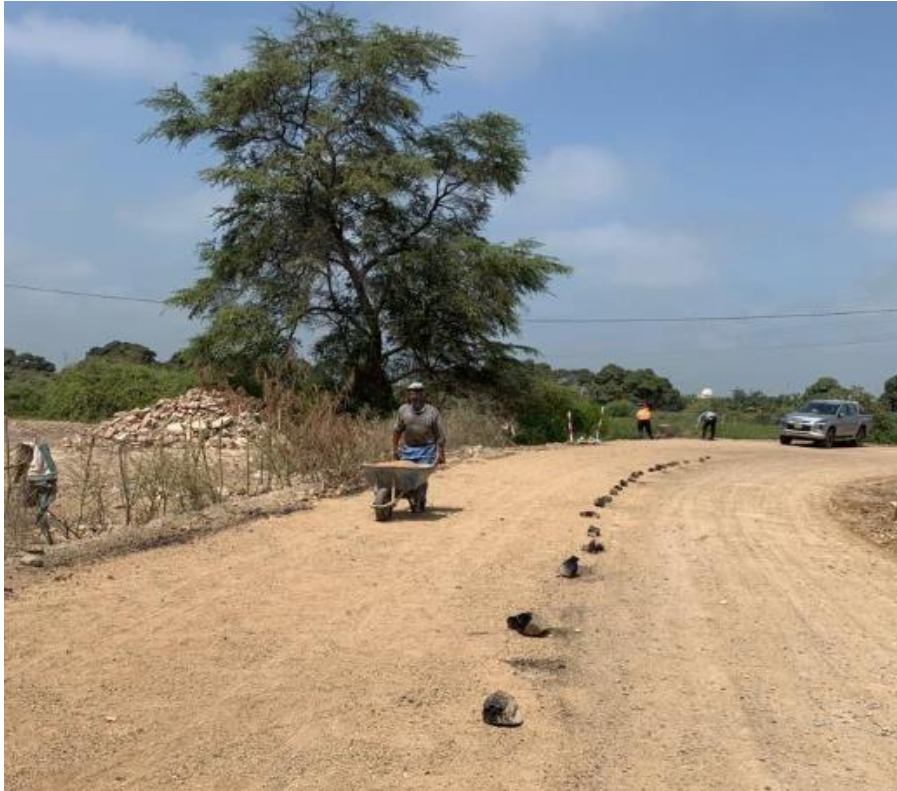
Ilustración 142: Transporte y colocación de arena menor a 5mm
