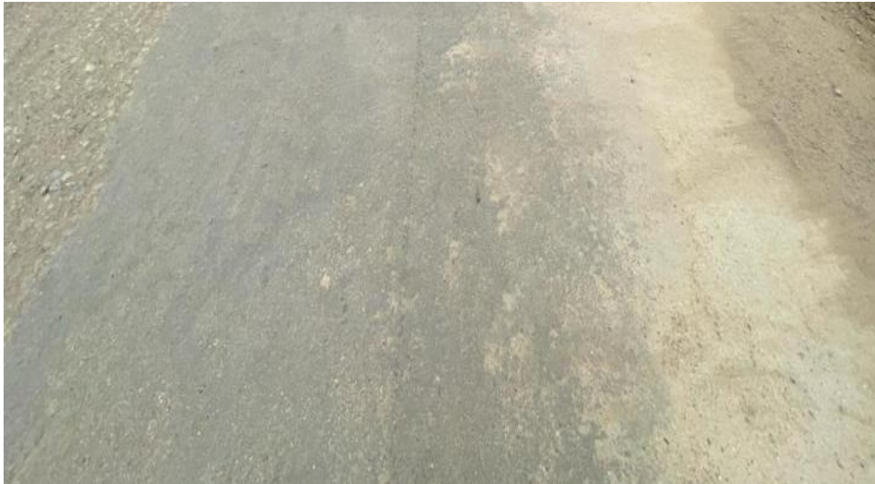
Ilustración 148: Peladuras y pérdida del revestimiento asfáltico.
