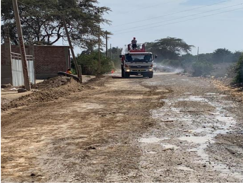
Ilustración 120: Riego de todo el ancho de la vía desde 0+070km hasta 0+0180km
