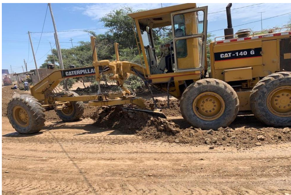
Anexo N°02.129: Perfilado del ancho de la vía con Motoniveladora
