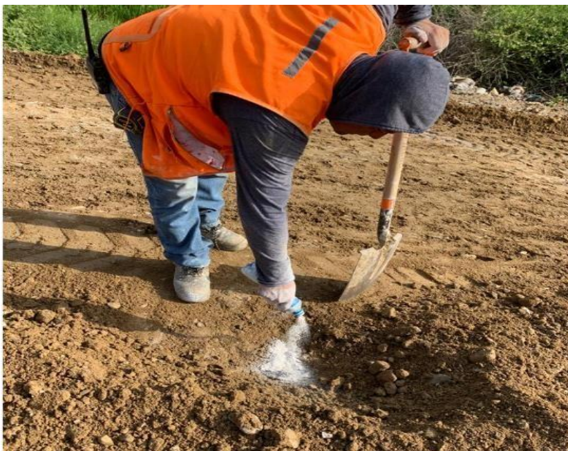
Anexo N°02.133: Señalización de plantilla con yeso
