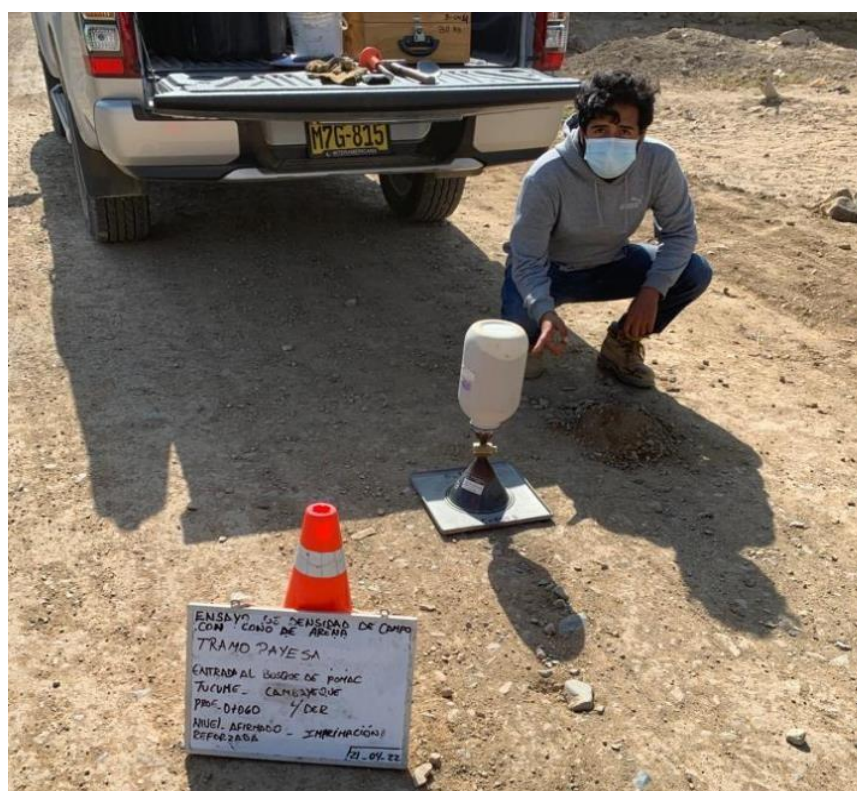
Anexo N°02.87: Ensayo de densidad de campo, progresiva 0+060km
