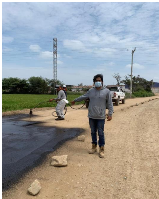
Anexo N°02.110: Segundo riego de emulsión asfáltica CSS-1h
