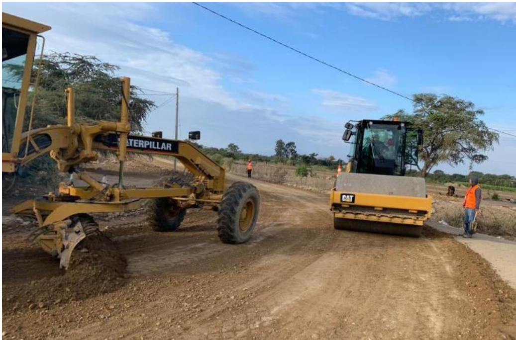
Anexo N°02.131: Perfilado y compactado de la plataforma
