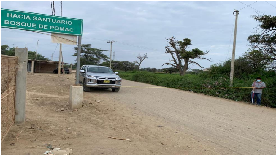
Anexo N°02.58: Medición del ancho de la vía de los primeros 70 ml
