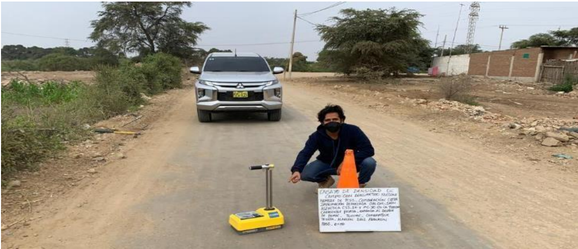
Anexo N°02.160: Ensayo de densidad de campo con densímetro nuclear, progresiva 0+140 Km
