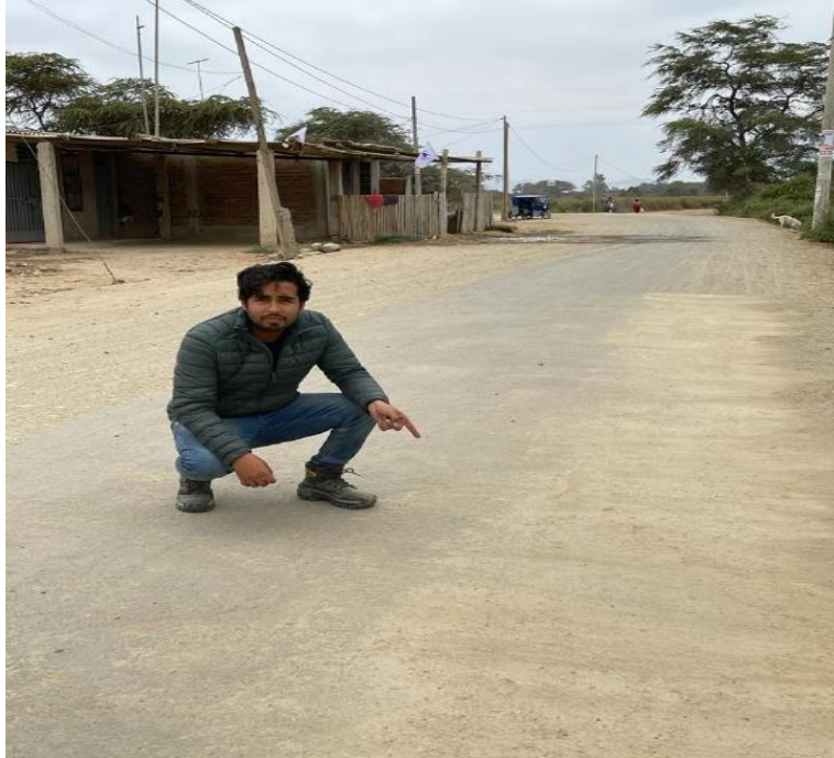
Ilustración 146: Pérdida del revestimiento asfáltico, generación de polución
