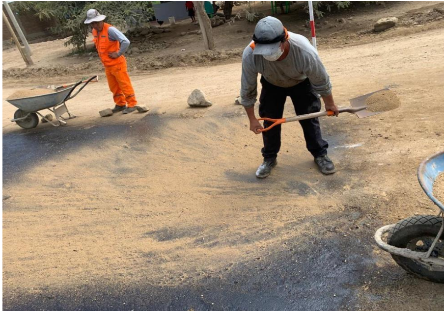
Ilustración 110: Colocación de arena menor a 5mm
