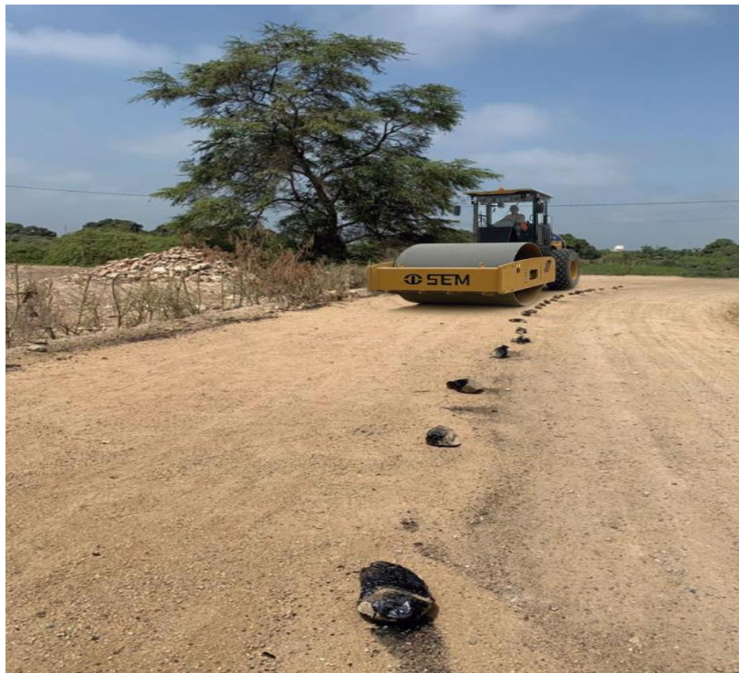
Ilustración 143: Compactación con rodillo liso SEM de 12 toneladas
