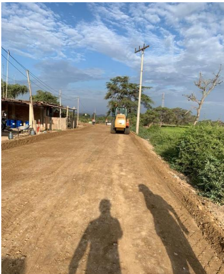
Ilustración 92: Compactación final (95% MDS) del afirmado
