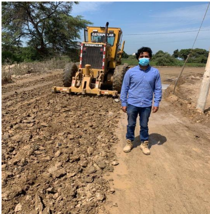
Ilustración 121: Escarificado con una Motoniveladora CAT 140G
