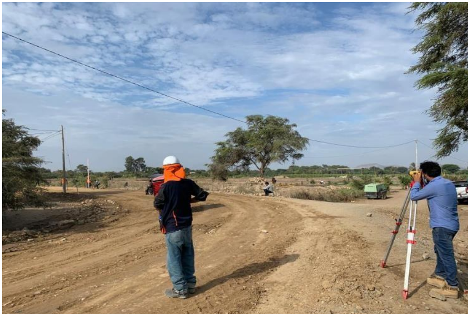
Ilustración 123: Nivelación haciendo uso de nivel y mira para colocación de plantillas
