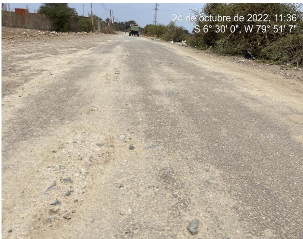
Ilustración 164: Presencia de agregado grueso en la superficie del pavimento
