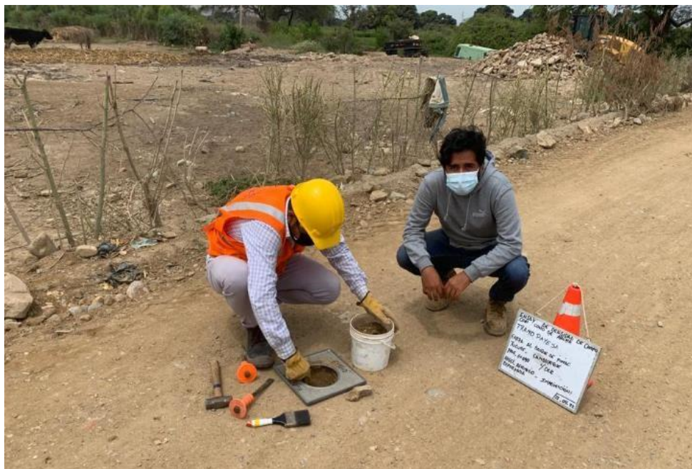
Anexo N°02.137: Ensayo de densidad de campo, progresiva 0+090km
