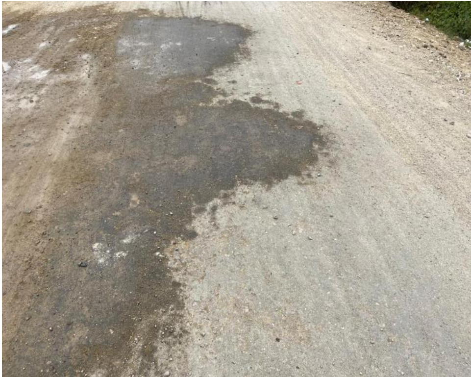
Ilustración 148: Peladuras y pérdida del revestimiento asfáltico.
