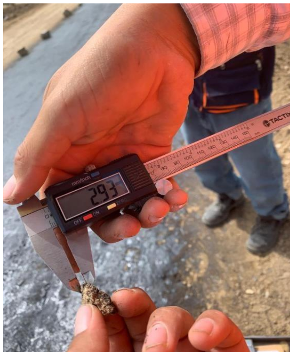
Anexo N°02.102: Penetración de 2.93mm, progresiva 0+050km
