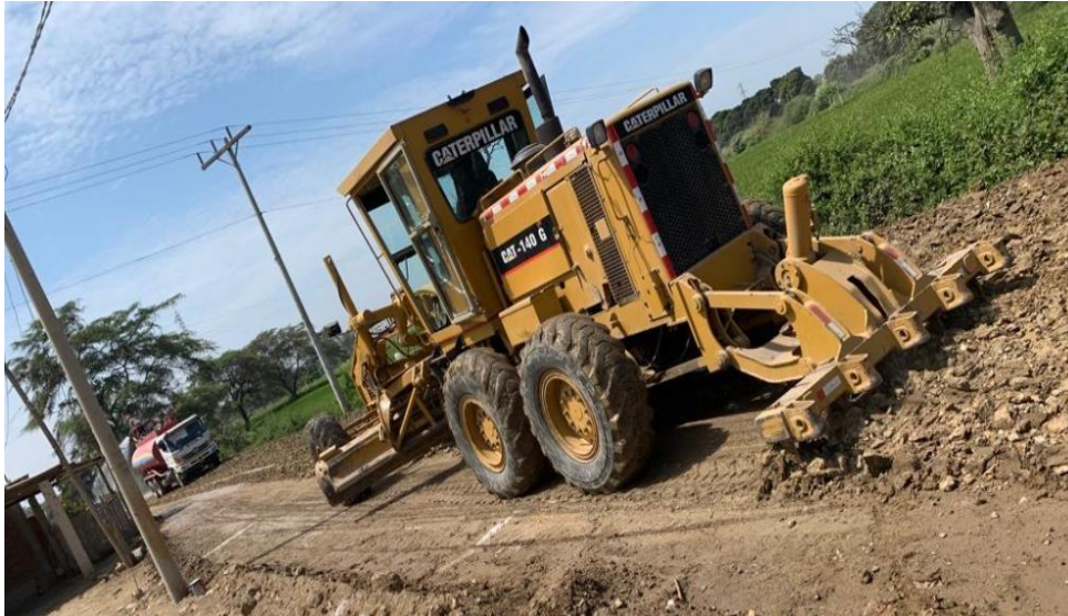
Anexo N°02.72: Escarificado de todo el ancho de la vía
