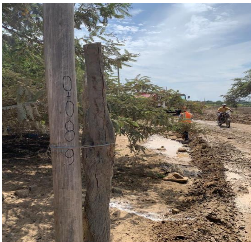
Anexo N°02.119: Colocación de progresivas
