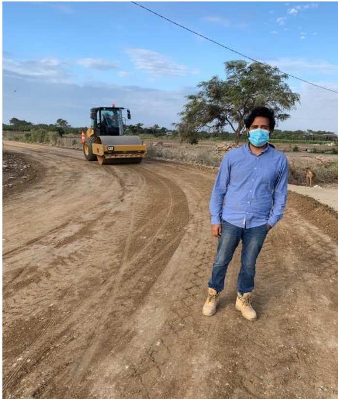
Anexo N°02.135: Compactación final (95% MDS) del afirmado
