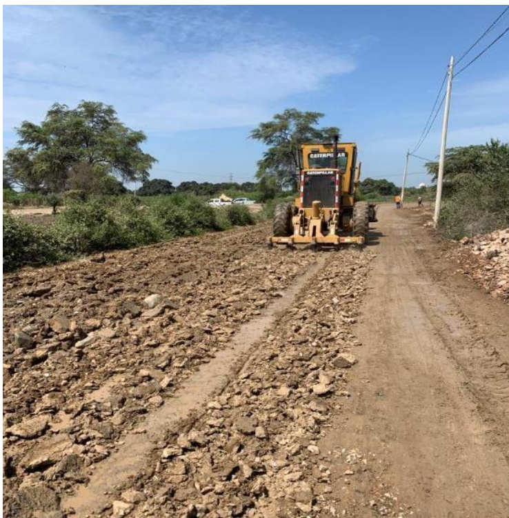
Anexo N°02.127: Escarificado de todo el ancho de la vía
