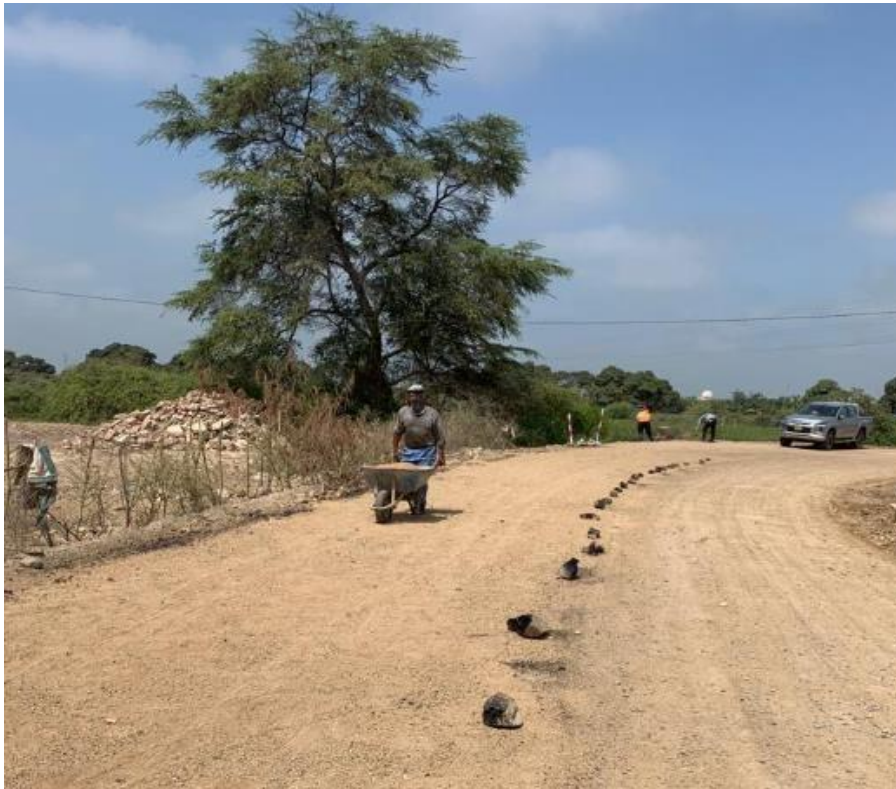
Anexo N°02.158: Transporte y colocación de arena menor a 5mm
