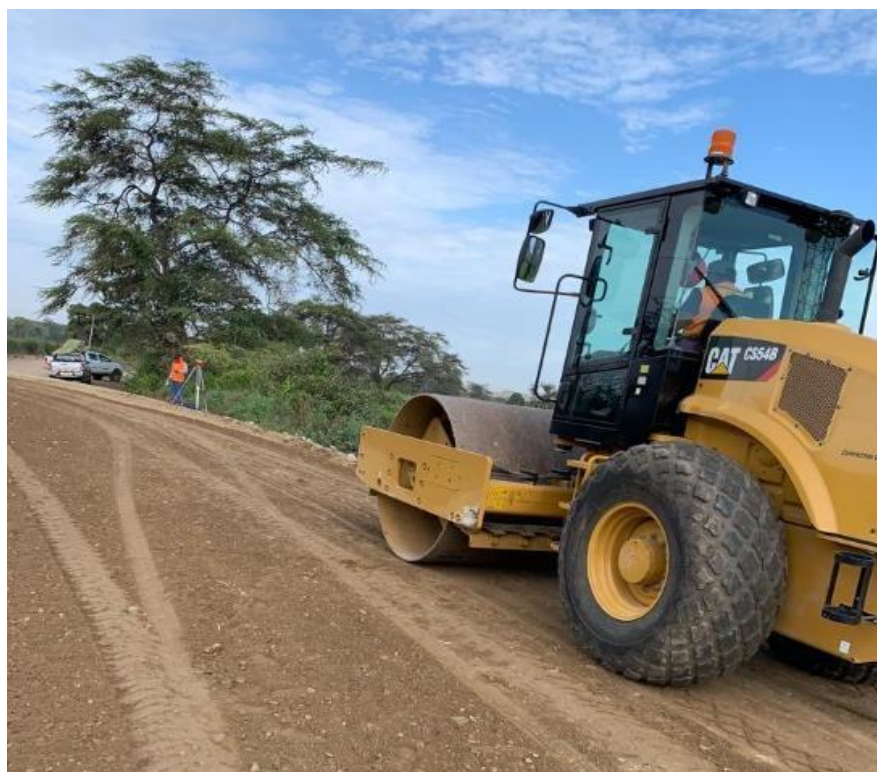
Anexo N°02.75: Compactación mediante un rodillo CAT, ModeloCS54B
