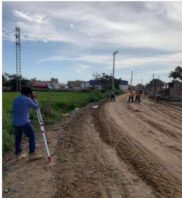
Anexo N°02.77: Nivelación con nivel y mira para colocación de plantillas
