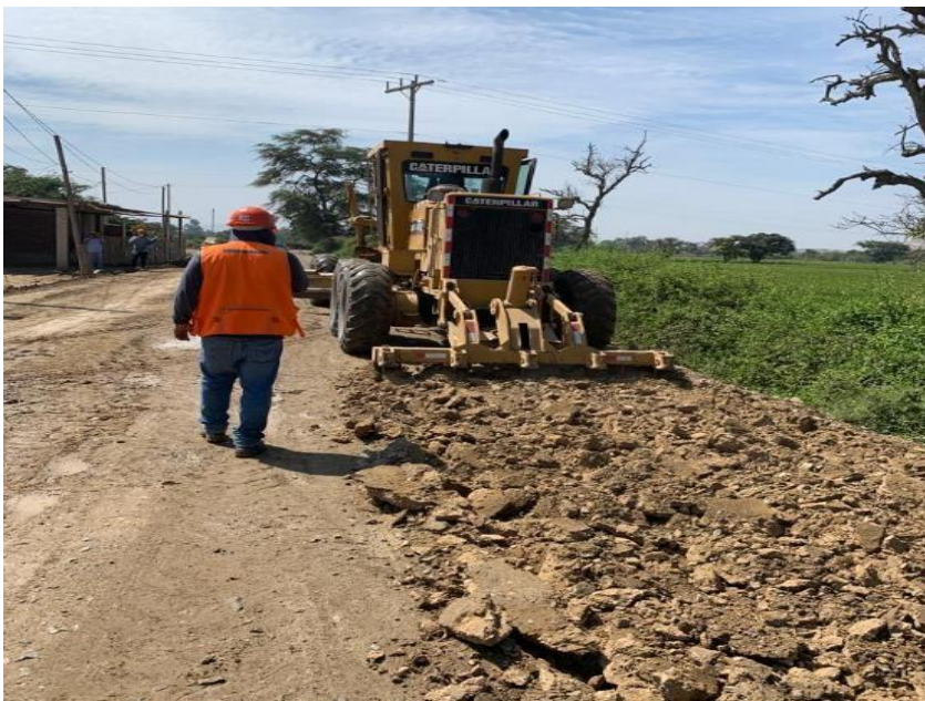
Ilustración 87: Escarificado con una Motoniveladora CAT 140G
