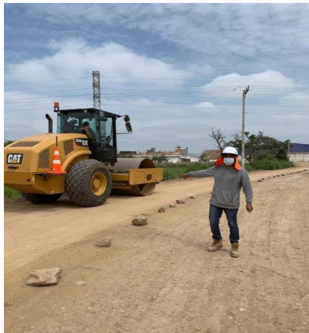
Ilustración 107: Compactación mediante rodillo liso de 0+000km a 0+070km
