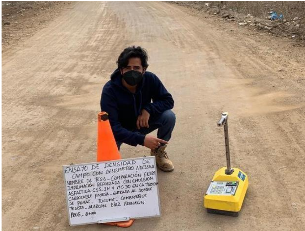
Anexo N°02.160: Ensayo de densidad de campo con densímetro nuclear, progresiva 0+100 Km
