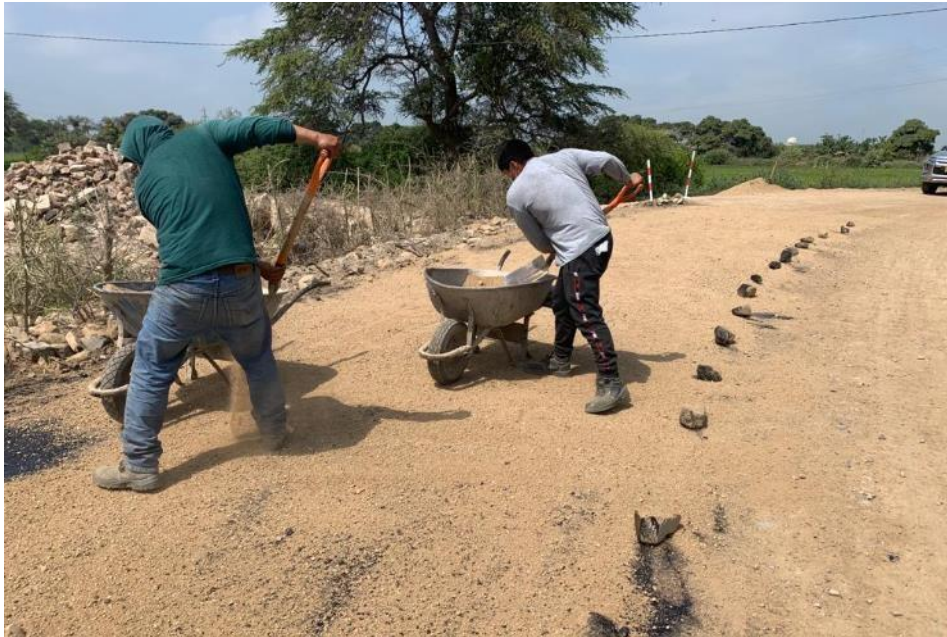
Ilustración 138: Transporte y colocación de arena triturada menor a 5mm
