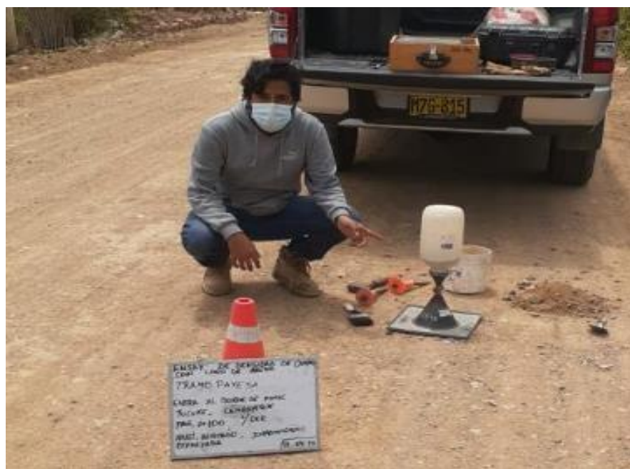
Anexo N°02.138: Ensayo de densidad de campo, progresiva 0+100km
