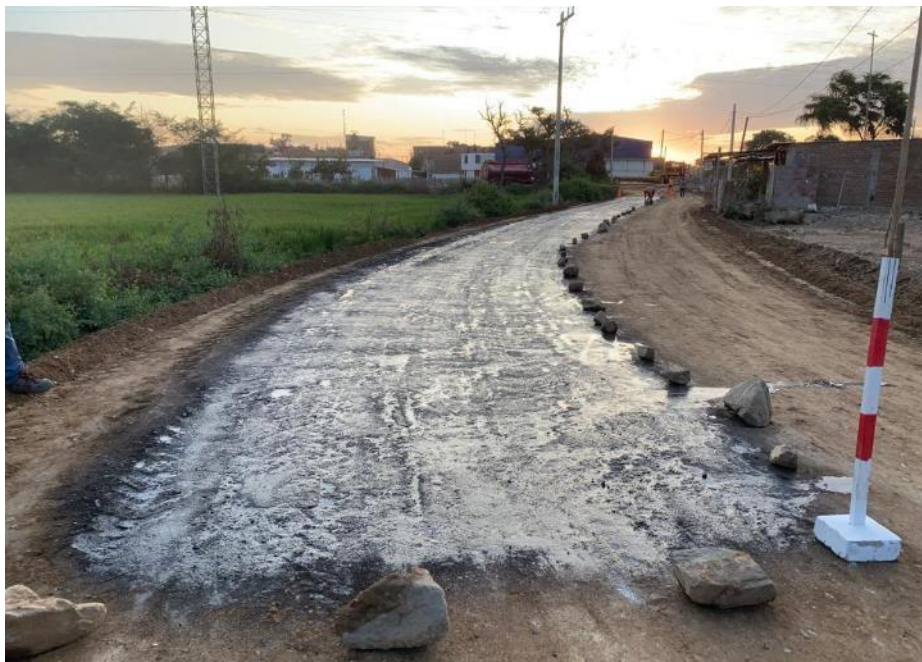
Ilustración 96: Imprimación con emulsión CSS-1h en los primeros 70 metros lineales
