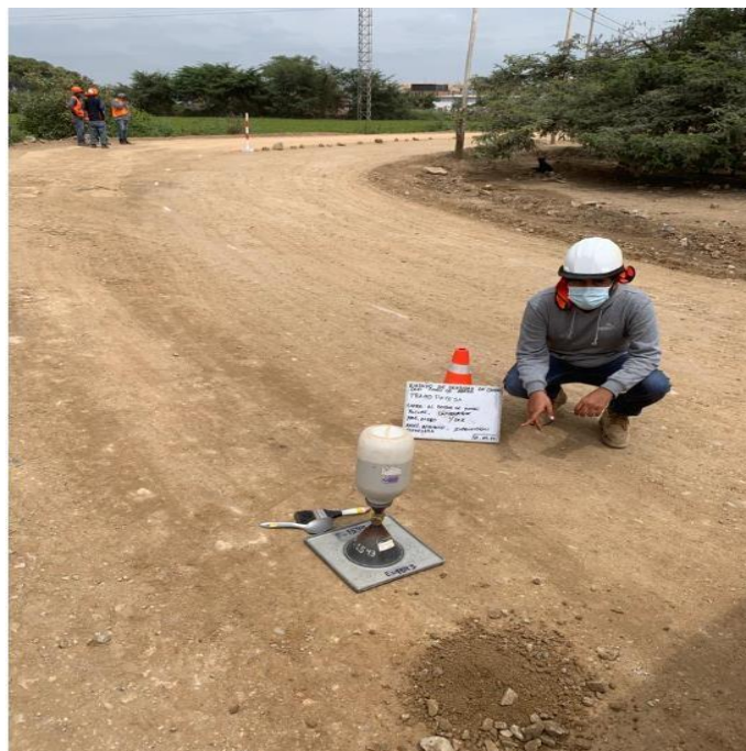
Anexo N°02.136: Ensayo de densidad de campo, progresiva 0+080km
