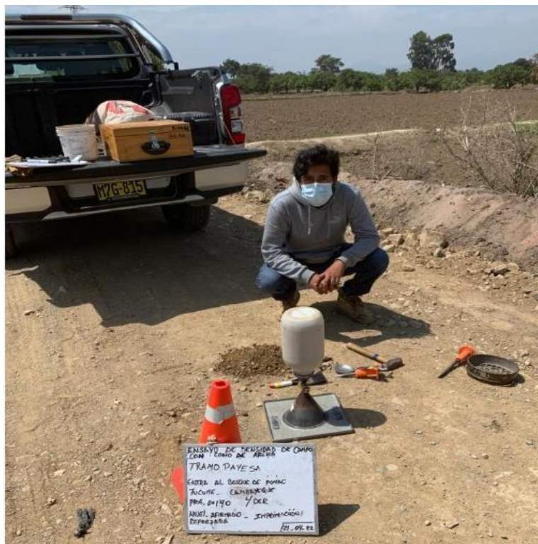
Ilustración 127: Ensayo de densidad de campo, progresiva 0+140km
