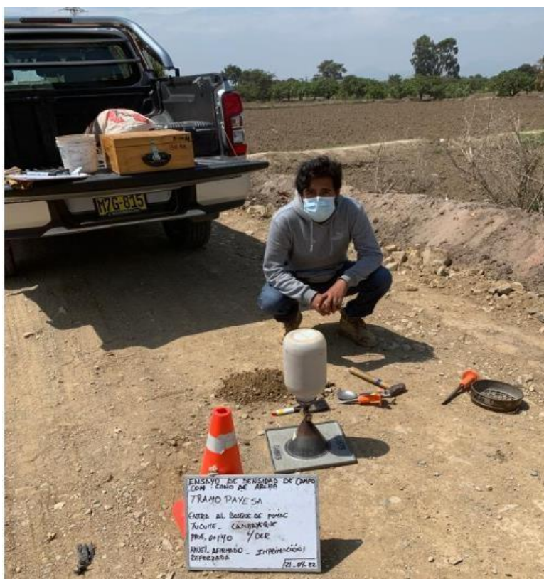
Anexo N°02.142: Ensayo de densidad de campo, progresiva 0+140km
