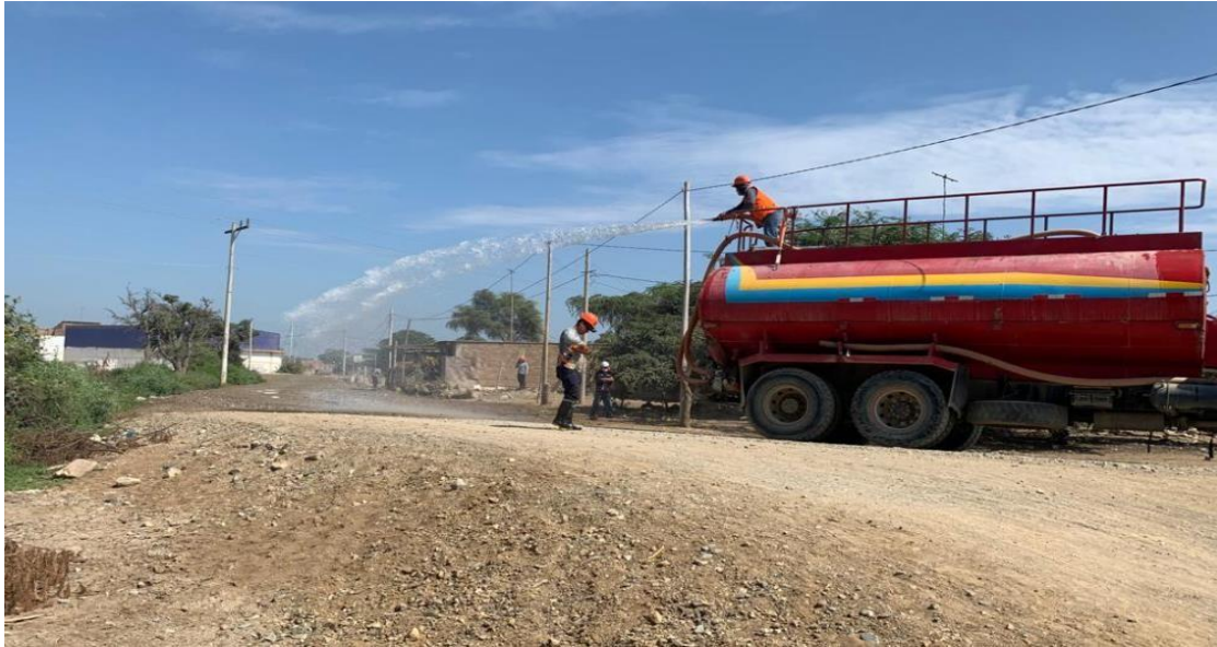
Anexo N°02.70: Riego de todo el ancho de la vía del Primer Tramo de 70ml
