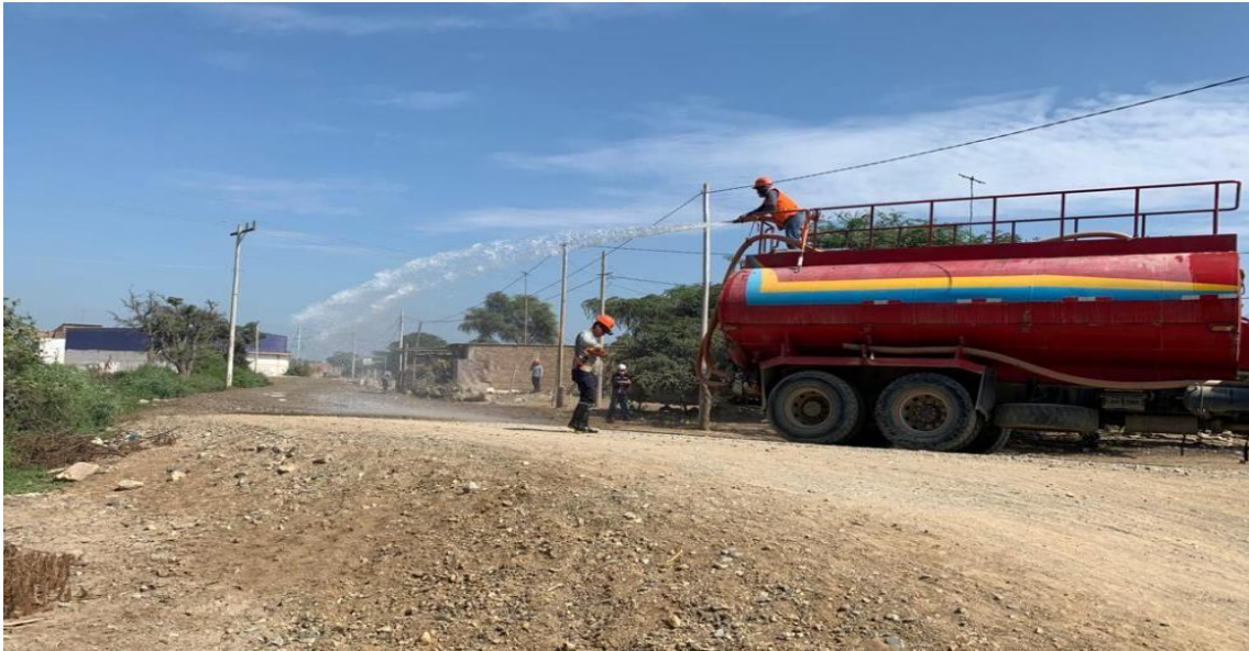
Ilustración 86: Riego de todo el ancho de la vía del Primer Tramo de 70ml
