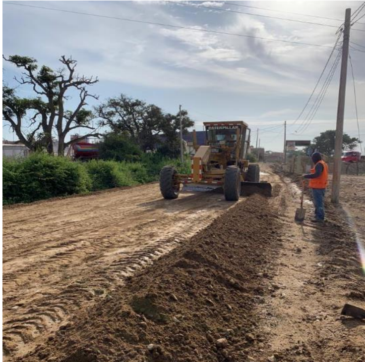
Anexo N°02.80: Búsqueda y colocación de yeso tras el paso de motoniveladora
