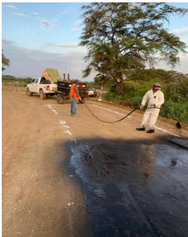
Anexo N°02.93: Imprimación con emulsión CSS-1h en el afirmado
