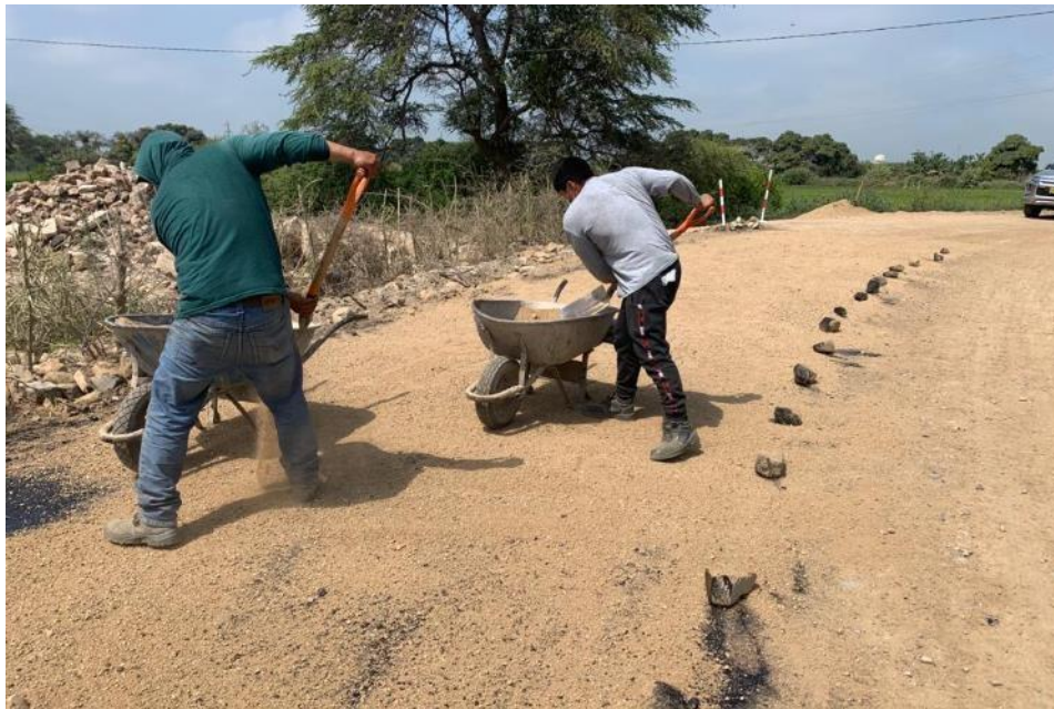
Anexo N°02.155: Transporte y colocación de arena triturada menor a 5mm
