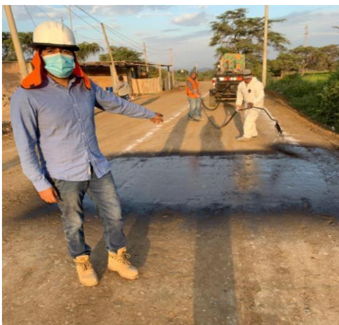
Ilustración 95: Imprimación de la emulsión asfáltica CSS-1h con una tasa de aplicación de 1.85 lt/m 2
