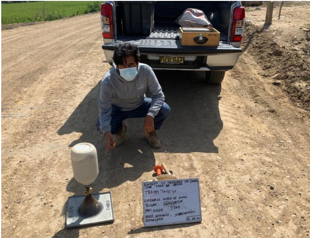
Anexo N°02.88: Ensayo de densidad de campo, progresiva 0+070km
