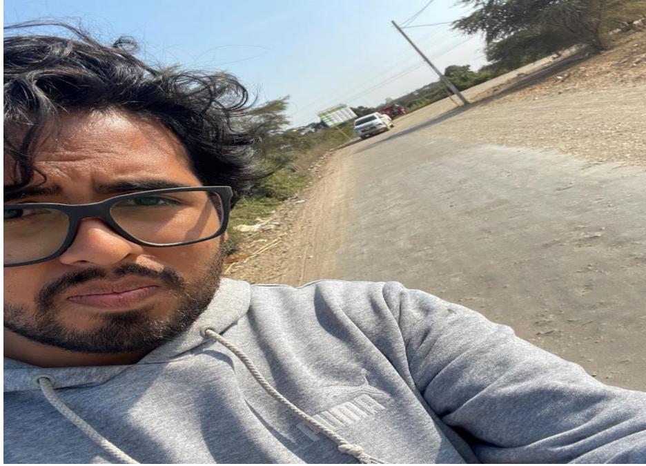
Ilustración 161: Presencia de baches con severidad baja
