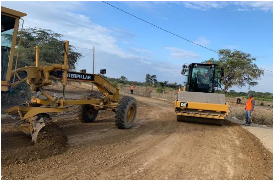
Ilustración 122: Perfilado y compactado de la plataforma
