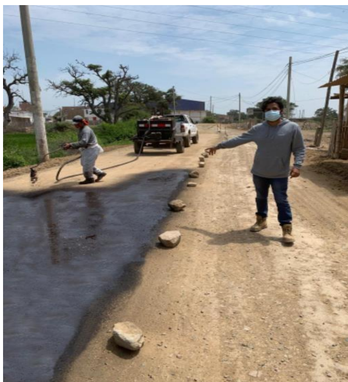
Anexo N°02.111: Segundo riego de emulsión asfáltica CSS-1h
