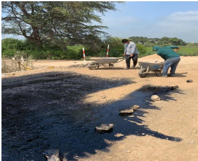
Ilustración 141: Segundo riego de MC-30 para imprimación reforzada
