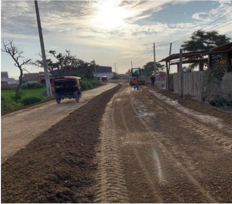
Anexo N°02.76: Compactación de todo el ancho de la vía
