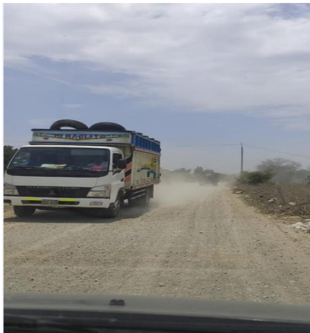
Anexo N°01.2: Emisión de polvo producto de la abrasión de los neumáticos con la carpeta de rodadura del camino vecinal Payesa, entrada al Bosque de Pómac
