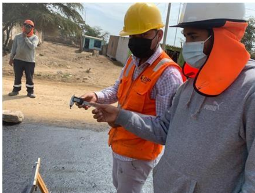
Anexo N°02.103: Penetración de 2.07mm, progresiva 0+060km
