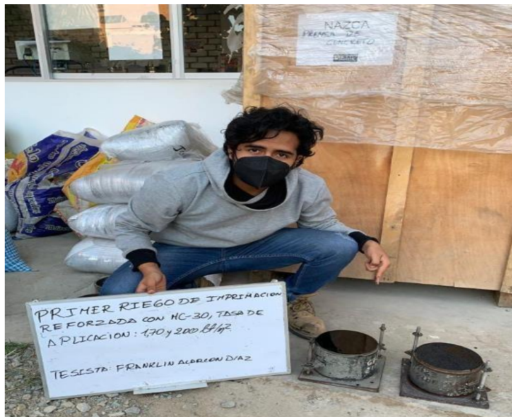
Anexo N°02.50: Primer Riego de imprimación con MC-30 con tasas de 1.70, 1.85 y 2.00 lt/m 2
