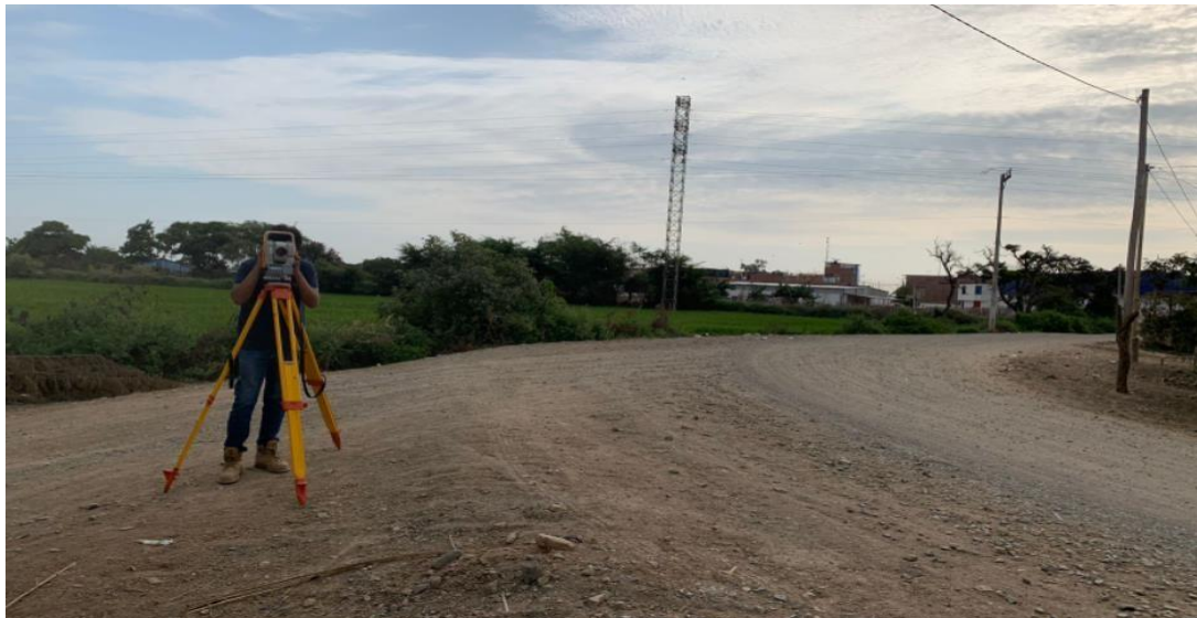
Ilustración 115: Levantamiento topográfico con estación total y prismas
