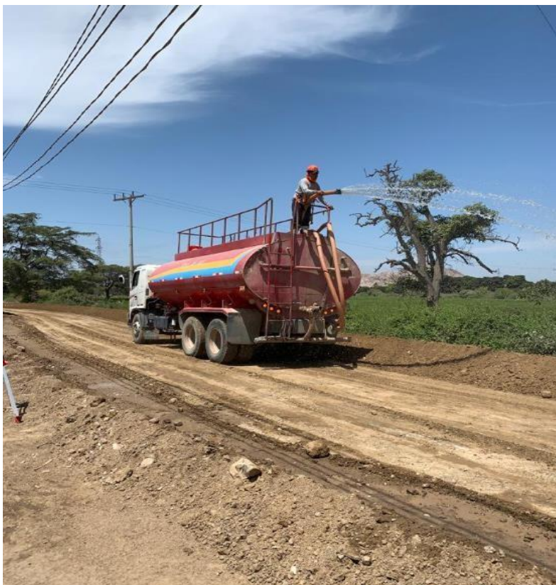
Anexo N°02.74: Riego con cisterna de 2500gln
