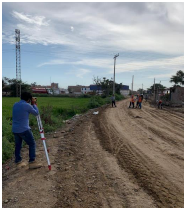
Ilustración 90: Nivelación con nivel y mira para colocación de plantillas
