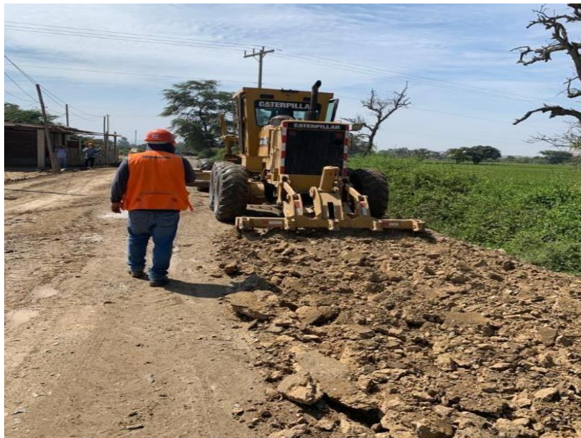
Anexo N°02.71: Escarificado con una Motoniveladora CAT 140G
