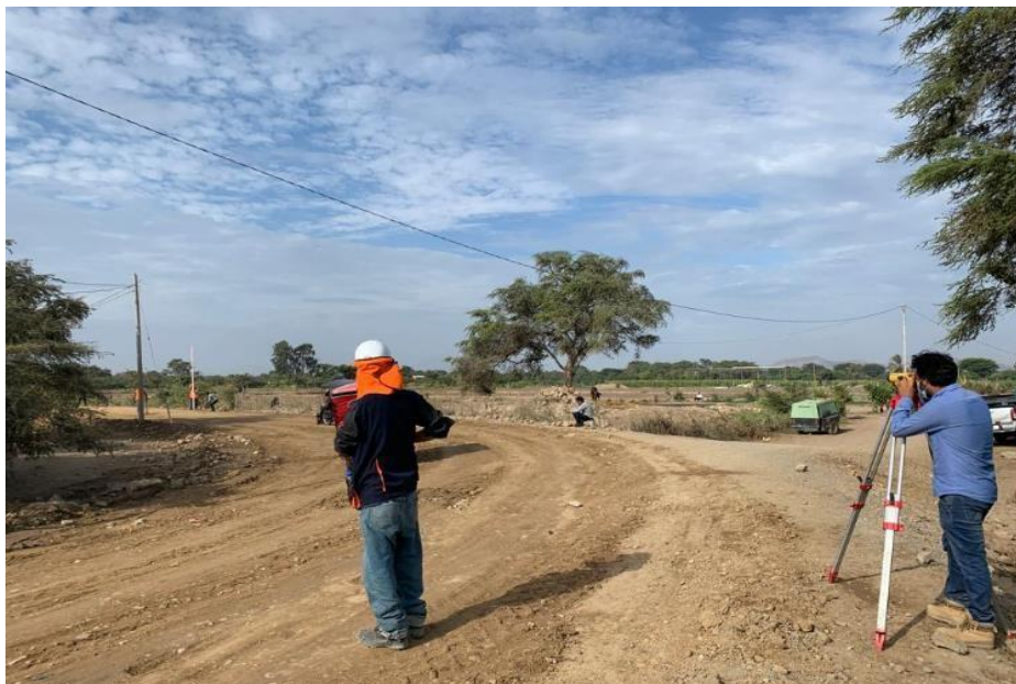
Anexo N°02.132: Nivelación haciendo uso de nivel y mira para colocación de plantillas
