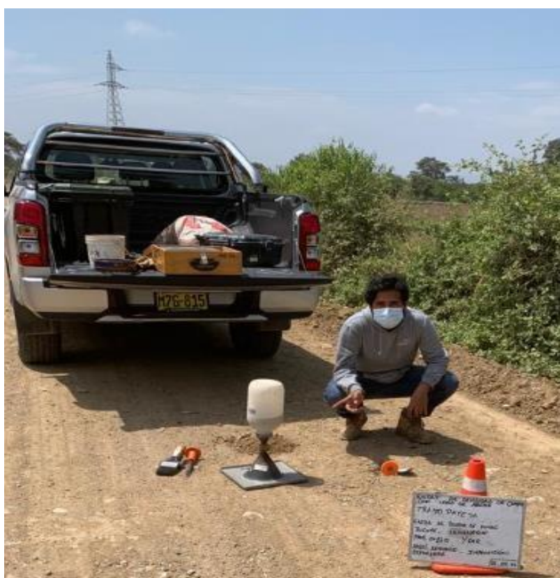
Anexo N°02.140: Ensayo de densidad de campo, progresiva 0+120km
