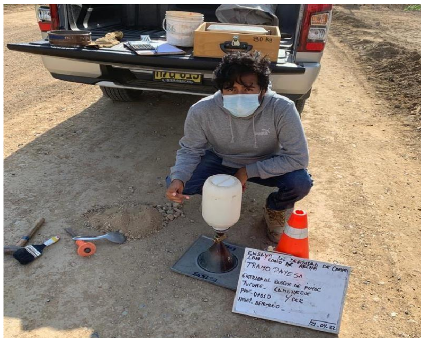
Ilustración 93: Ensayo de densidad de campo, progresiva 0+010km
