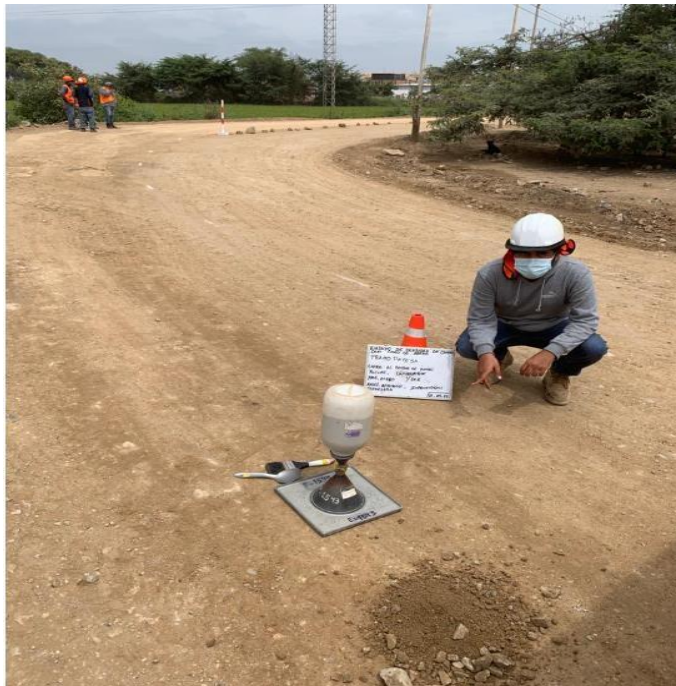
Ilustración 126: Ensayo de densidad de campo, progresiva 0+080km
