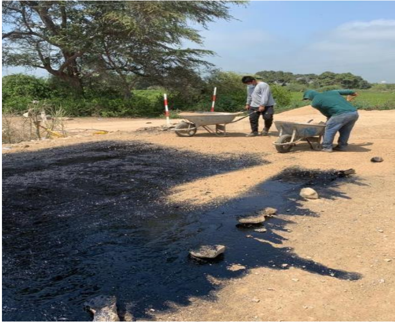
Anexo N°02.157: Segundo riego de MC-30 para imprimación reforzada
