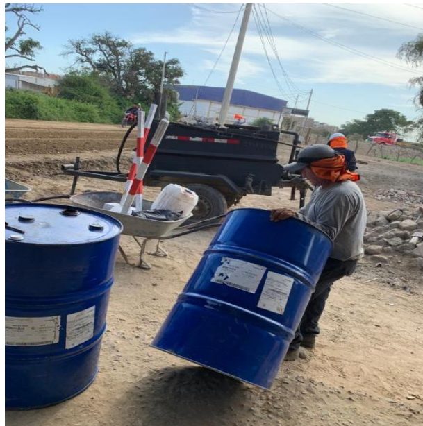
Anexo N°02.89: Colocación de la emulsión asfáltica a la cocina asfáltica
