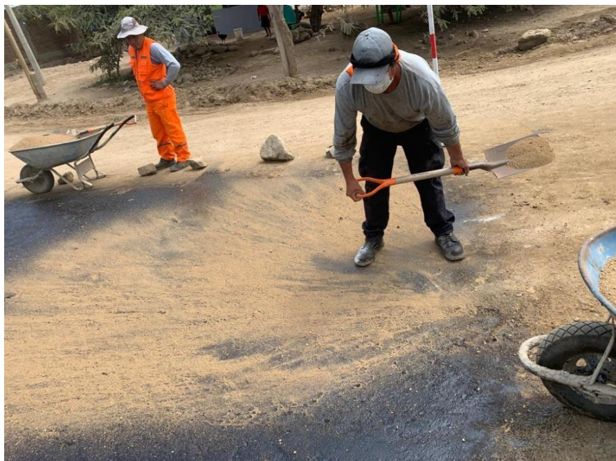
Anexo N°02.112: Colocación de arena menor a 5mm
