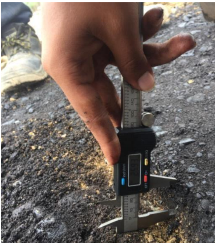
Anexo N°02.150: Penetración 25.93mm, progresiva 0+110km
