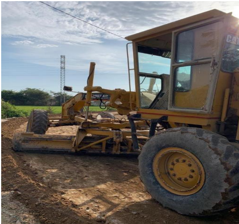
Ilustración 124: Perfilado conforme a la pendiente y bombeo
