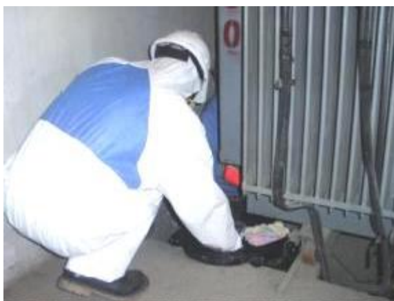
Figura 12. Toma de muestra en transformador de potencia de subestación 61. Centro de Chiclayo.
