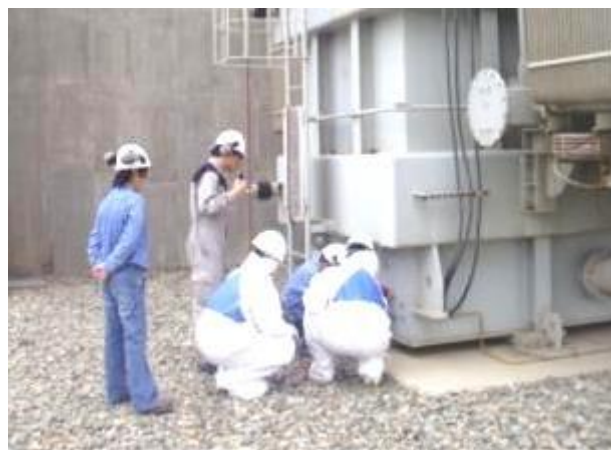
Figura 11. Toma de muestra en transformador de potencia SEP Chiclayo OESTE.
