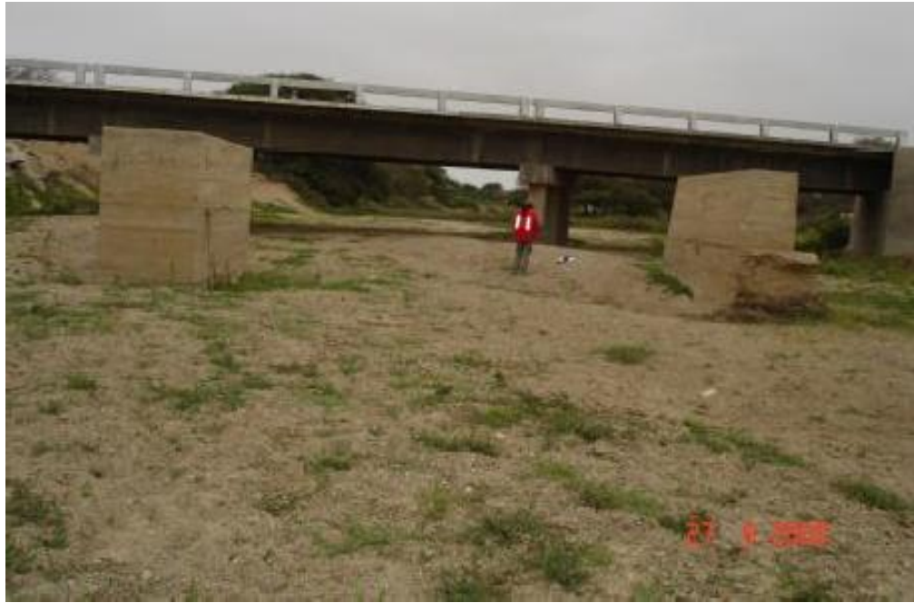
Foto N° 17. Zona crítica N° 55. Flujo de detritos y lodo. Puente Motupe II y III, El Angolo II; y Pte.Inche.
