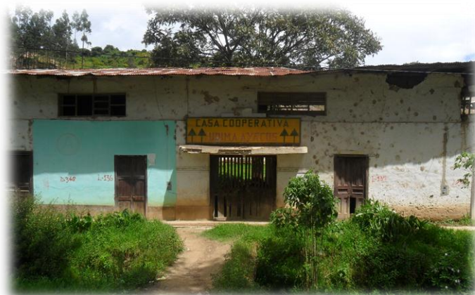
Figura N° 27. Ex cooperativa de Udima. Fuente: Propia
