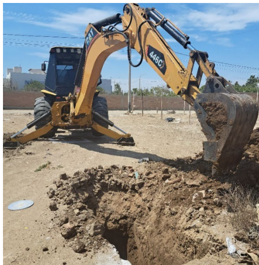
Figura 13: Excavación para la obtención del suelo arcilloso
