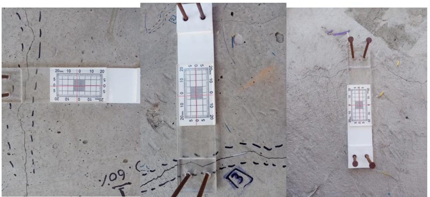
Ilustración 43: Medición de fisuras en concreto con adición 0.60 PEAD
