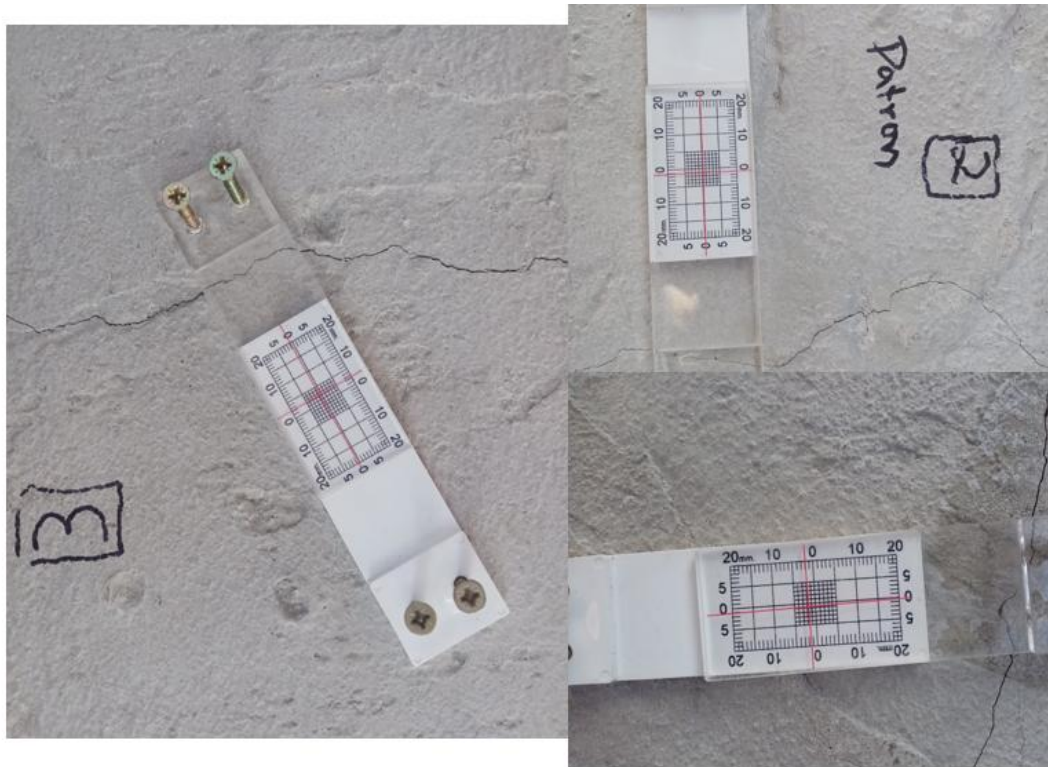
Ilustración 42: Medición de fisuras en concreto patrón
