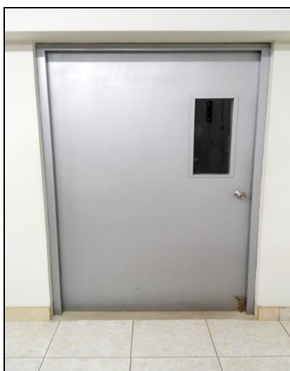
Figura N° 41: Puerta de madera – aulas edificio Antiguo
