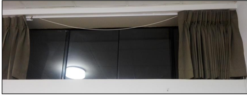
Figura N° 42: Ventanas pequeñas – aulas edificio Antiguo Fuente: Elaboración propia.
