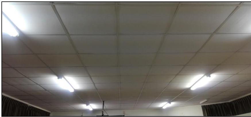
Figura N° 46: Cielo raso de baldosas de fibra mineral cuarto piso edificio Antiguo
