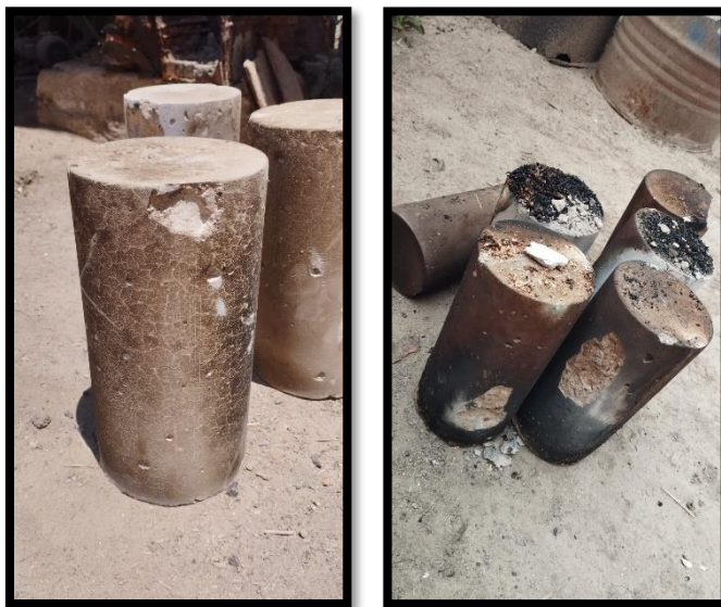
Figura 69 y 70: Fisuras y grietas.
