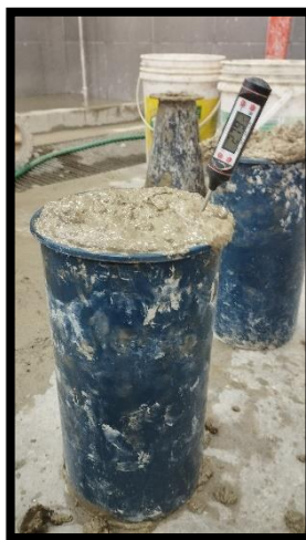
Figura N°38: Temperatura del concreto.
