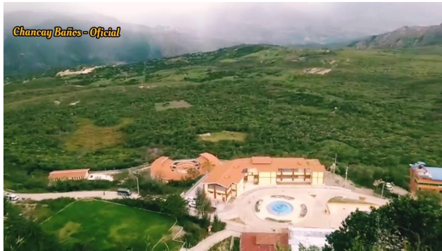
Figura 1: Vista panorámica de infraestructura pre. existente
