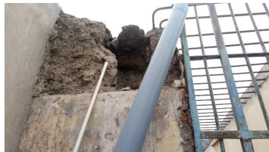
Imagen 32: Exterior de Celdas individuales
