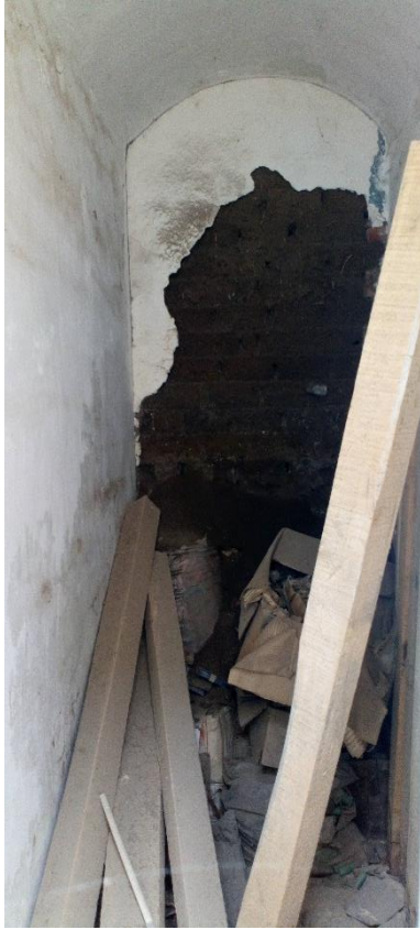
Imagen 28: Interior de celda individual
