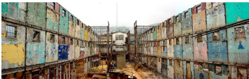
Imagen 41: Demolición de galería, cárcel de Valparaíso. Fuente: Archdaily
