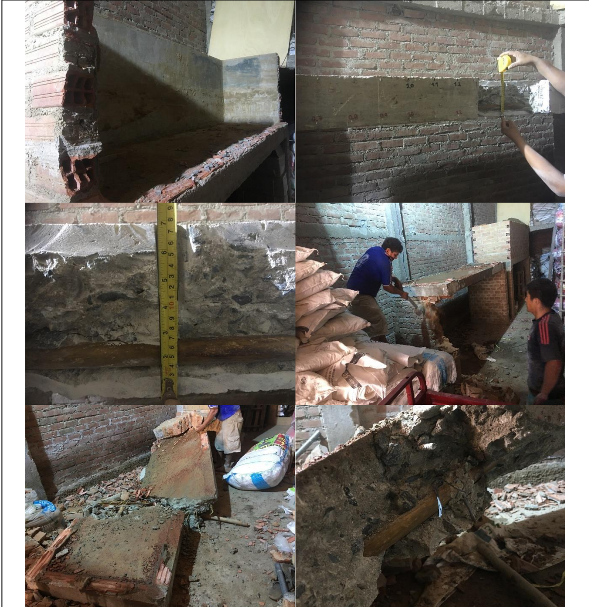
Figura 31. Panel fotográfico de la demolición de la propuesta de losa.
