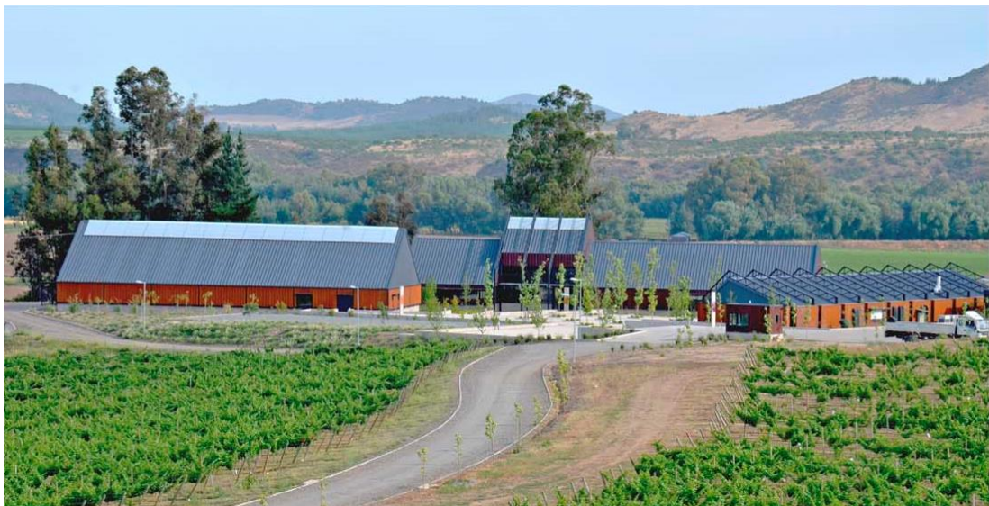
Imagen 47: Vista de la aproximación al proyecto. Fuente: conchaytoro.com (2015)
