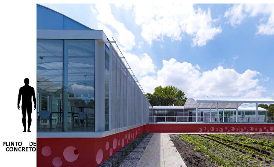
Esquema 6: Plinto de hormigón que eleva el edificio. Fuente: archdaily.pe (2013). Editado: edición propia.
