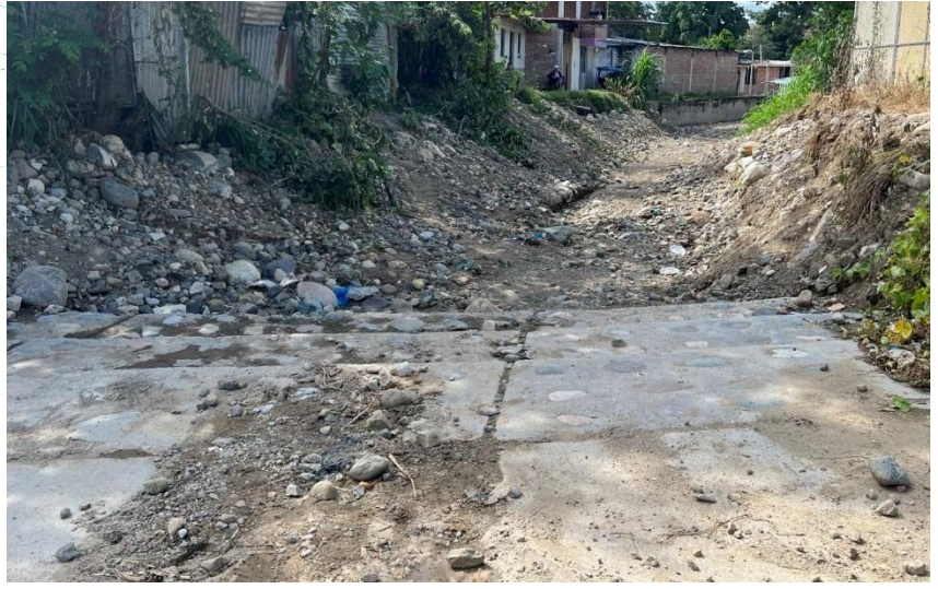
Ilustración 45 Segunda parte de la estructura de emboquillado de piedra para la evacuación de agua pluvial intersección de la calle Diego Ferré y Jr. Víctor Andrés Belaunde. Fuente: Elaboración propia.
