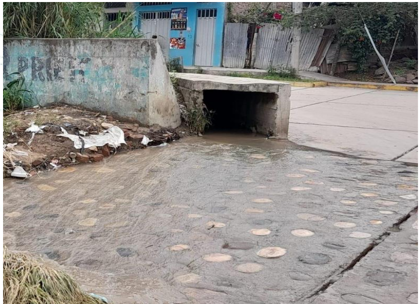
Ilustración 48 Cara anterior de emboquillado de piedra y desembocadura de sumidero en intersección Elías Aguirre con Víctor Raúl Haya de la Torre, Fila Alta. Fuente: Elaboración propia.
