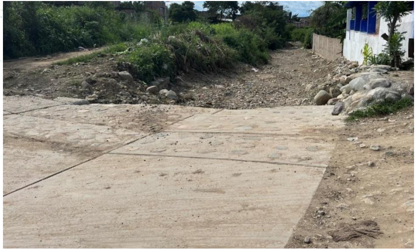
Ilustración 43 Primera parte de la estructura de emboquillado de piedra para la evacuación de agua pluvial intersección de la calle Leoncio Prado y Jr. César Vallejo. Fuente: Elaboración propia.
