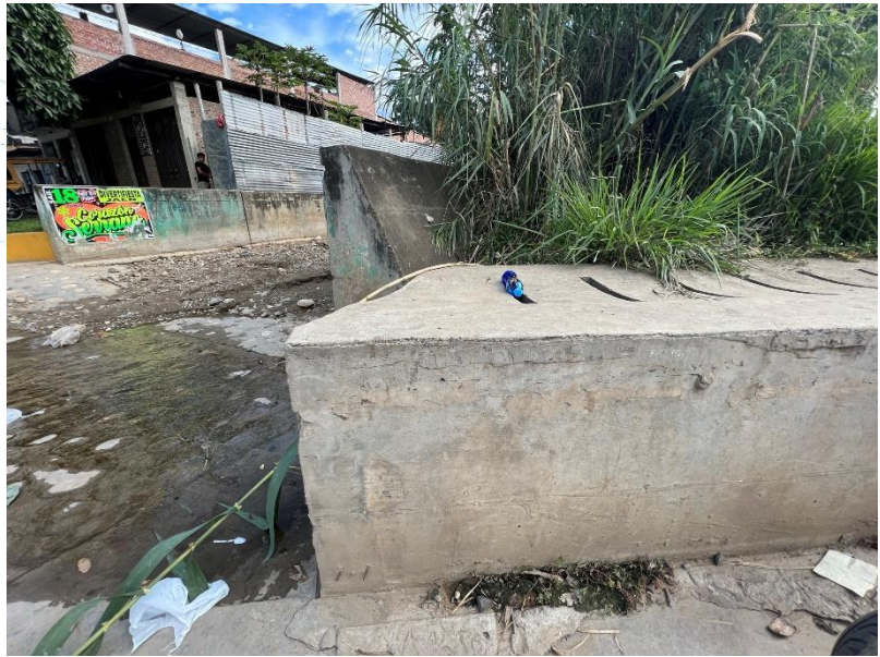
Ilustración 49 Cara lateral de emboquillado de piedra y desembocadura de sumidero en intersección Elías Aguirre con Víctor Raúl Haya de la Torre, Fila Alta. Fuente: Elaboración propia.
