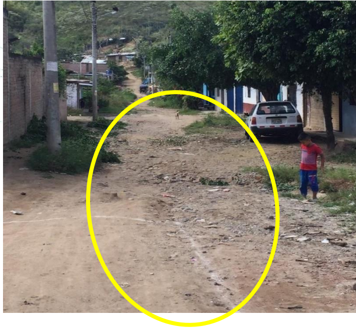
Ilustración 57 Presencia de erosión y vegetación a lo largo de la calle Diego Ferré. Fuente: Elaboración propia.
