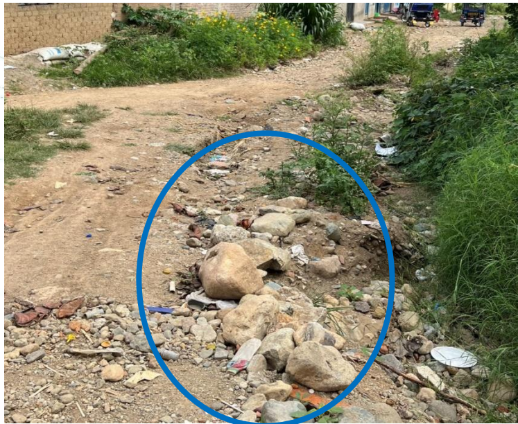
Ilustración 56 Erosión de la capa de terreno y presencia de contaminación en la intersección de Elías Aguirre con Juan Pablo Vizcardo y Guzmán. Fuente: Elaboración propia.
