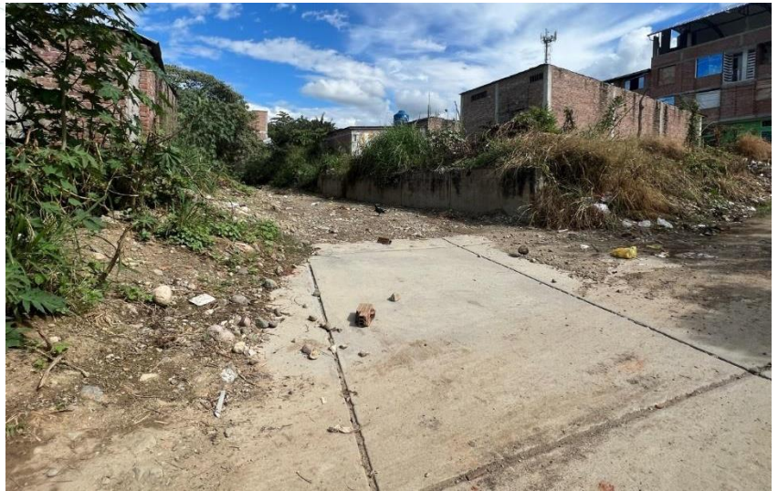
Ilustración 44 Segunda parte de la estructura de emboquillado de piedra para la evacuación de agua pluvial intersección de la calle Diego Ferré y Jr. Víctor Andrés Belaunde. Fuente: Elaboración propia.
