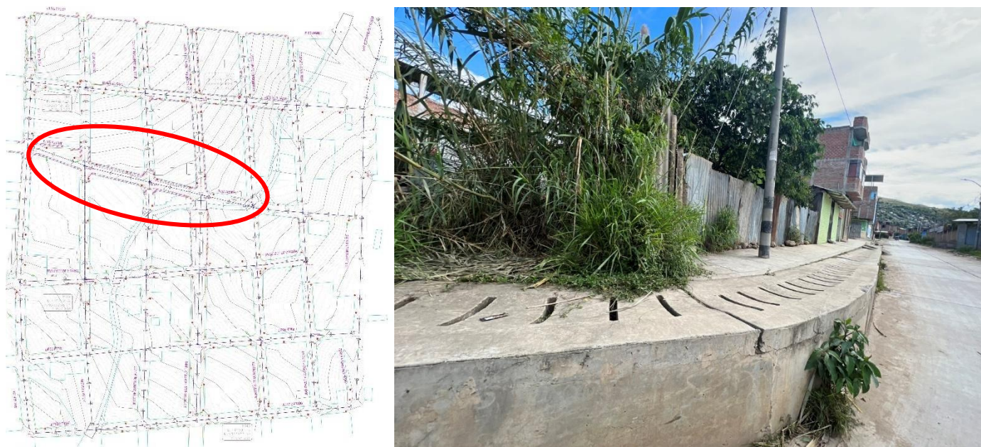
Ilustración 59 Presencia de sardinel a lo largo de la calle Elías Aguirre. Fuente: Elaboración propia.
