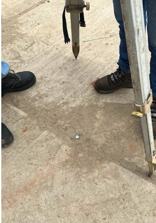
Ilustración 117 Toma de puntos para Topografía en la etapa I del sector Fila Alta.
