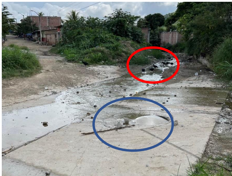
Ilustración 51 Colapso de buzón, intersección Elías Aguirre con Rodríguez de Mendoza, Fila Alta. Fuente: Elaboración propia.
