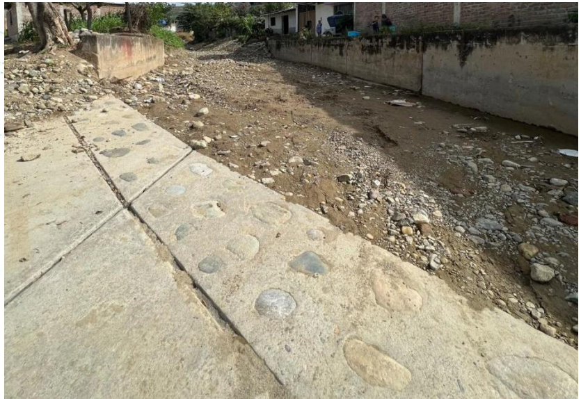
Ilustración 46 Tercera parte de la estructura de emboquillado de piedra para la evacuación de agua pluvial intersección de la calle Francisco de Miranda y Jr. Víctor Andrés Belaunde. Fuente: Elaboración propia.
