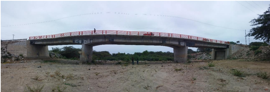
Fotografía N° 1: Vista lateral del Puente Motupe.
