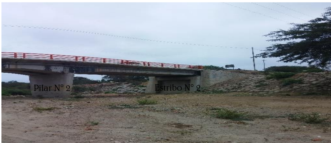
Fotografía N° 3: Vista del Pilar N° 2 y del Estribo N° 2.
