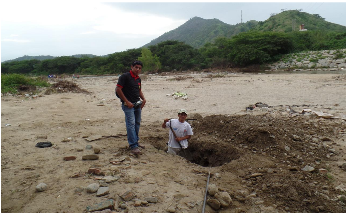
Fotografía N° 12: Excavación de calicatas.
