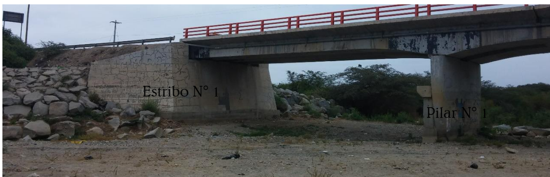
Fotografía N° 2: Vista del Estribo N° 1 y del Pilar N° 1.
