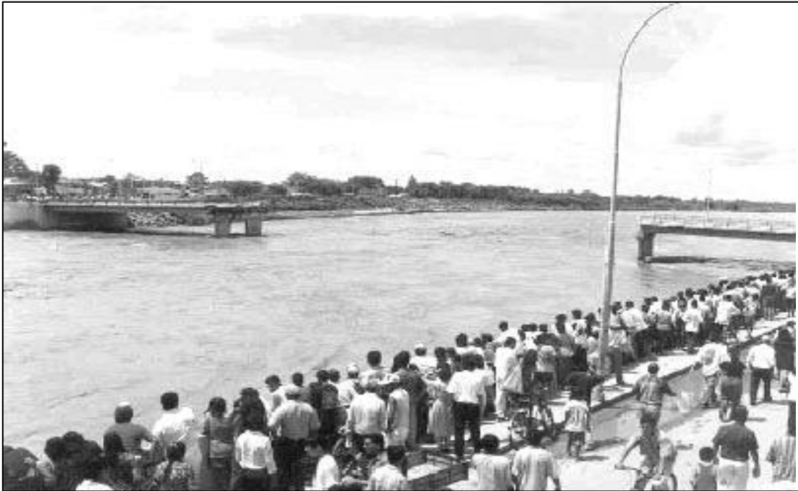
Figura N° 2. 5: Vista del colapsado Puente Bolognesi.
