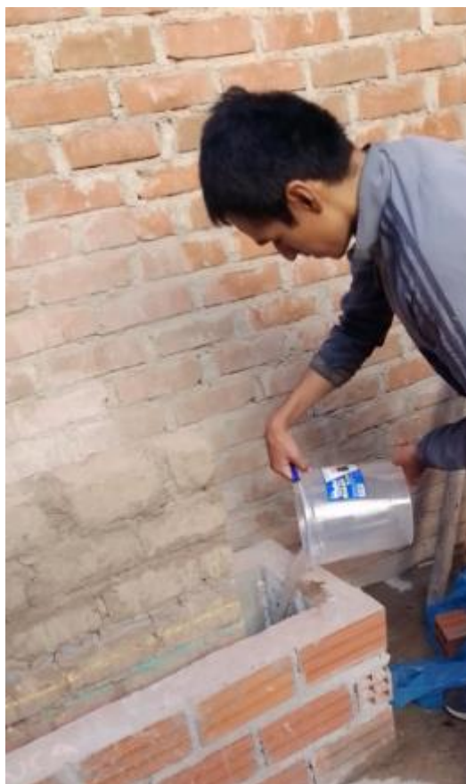
Anexo 116 Proceso de vertido de agua (con balde de 6.5L) dentro de la poza de albañilería
