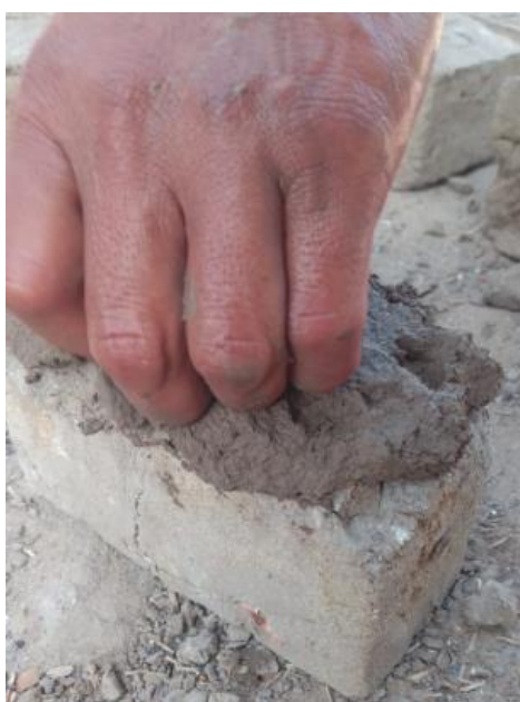
Ilustración 125 Colocación del mortero sobre la unidad de adobe después de una semana
