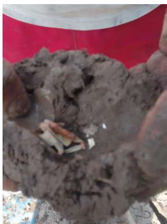
Ilustración 127 Colocación de la fibra de cáscara de yuca en el núcleo de la mezcla del barro y cal
