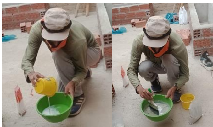
Anexo 97 Preparación de la mezcla del impermeabilizante Chema Seal (Según especificaciones del producto)
