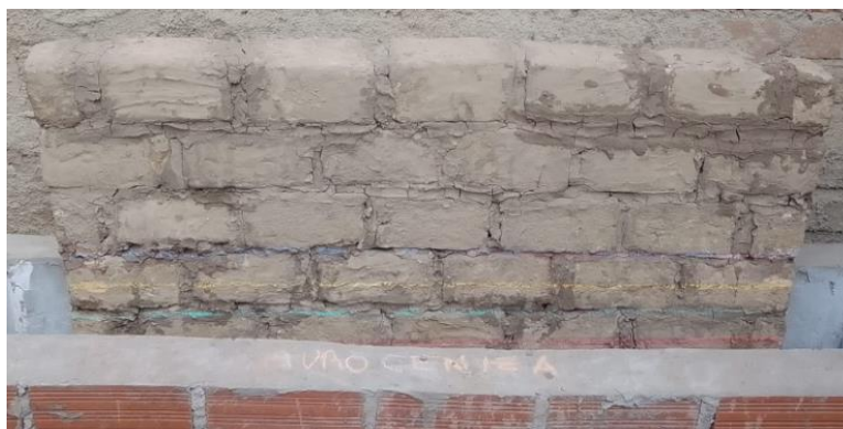
Ilustración 160 Muro Ceniza asentado en su respectiva poza de albañilería
