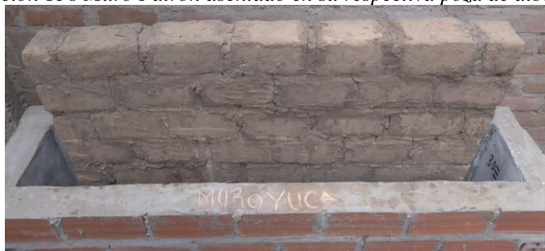
Ilustración 159 Muro Yuca asentado en su respectiva poza de albañilería
