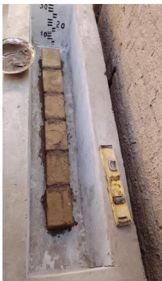
Anexo 107 Primera hilada del muro ceniza
