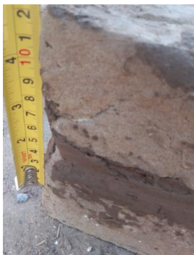
Ilustración 126 Comprobación de la junta de 1.5 cm
