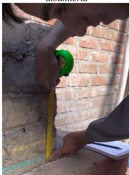
Anexo 117 Medición de la altura de capilaridad dado en el muro yuca (Uso de las líneas hecho con tira líneas y tizas de diferentes colores cada 5 centímetros)
