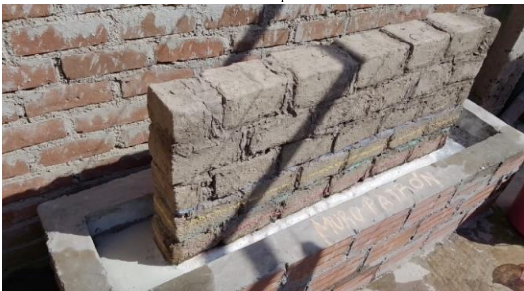
Ilustración 161 Muro Patrón sometido a inundación (se puede observar gran cantidad de espuma)
