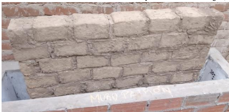
Ilustración 158 Muro Patrón asentado en su respectiva poza de albañilería
