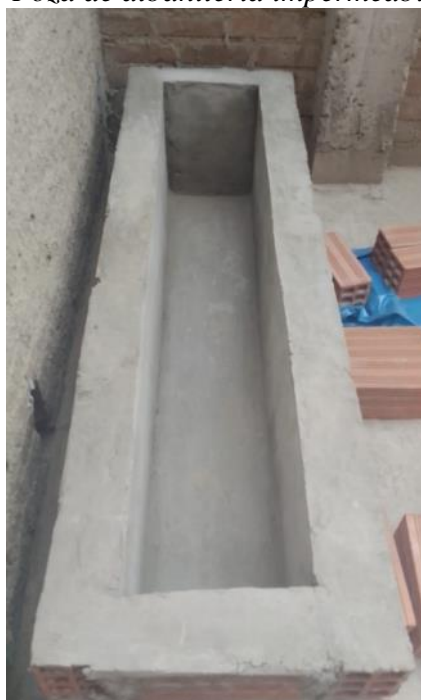
Ilustración 156 Poza de albañilería impermeabilizada para MC
