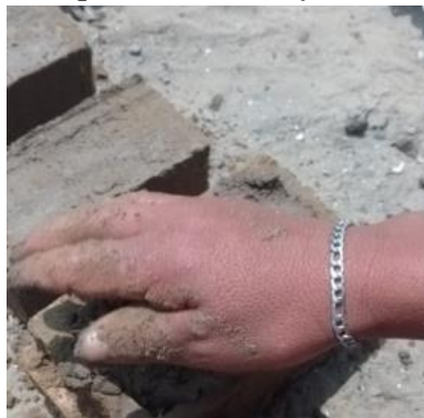
Ilustración 102 Alisado manual de las unidades de adobe
