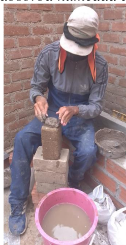
Anexo 103 Colocación del mortero lateral en una de las caras del adobe después de remojarlo
