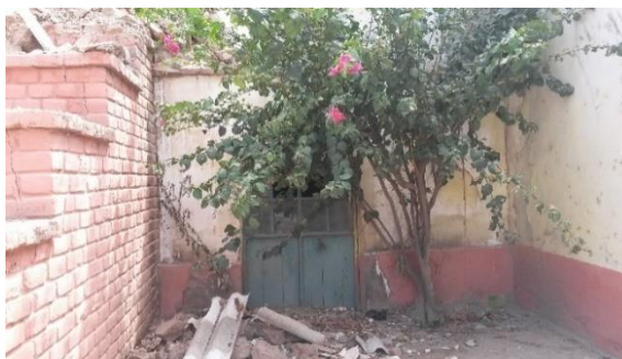
Figura 21. Ingreso a CEPO, desde el patio. Fuente: Elaboración propia.
