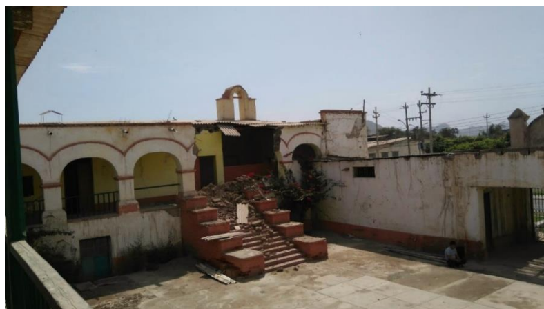
Figura 15. Vista desde el patio central de la casa hacienda Talambo. Fuente: Elaboración propia.
