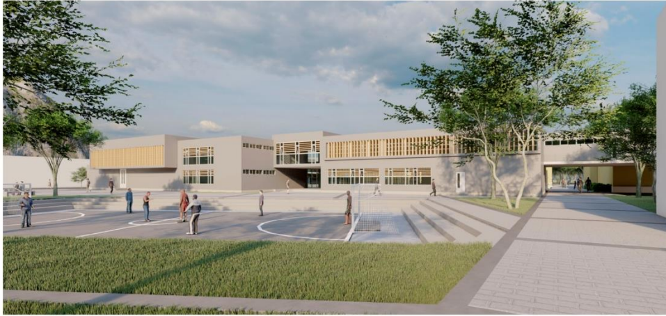
Figura 53. Vista de parte posterior, losa deportiva.
