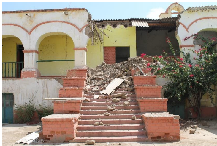
Figura 16. Escalinata central, punto de atracción de la casa. Fuente: Elaboración propia.
