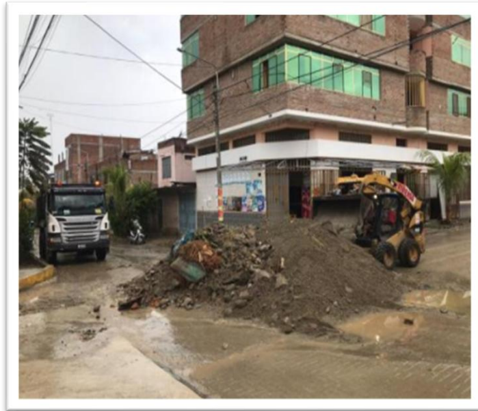
Ilustración 17: Restos de viviendas afectadas
