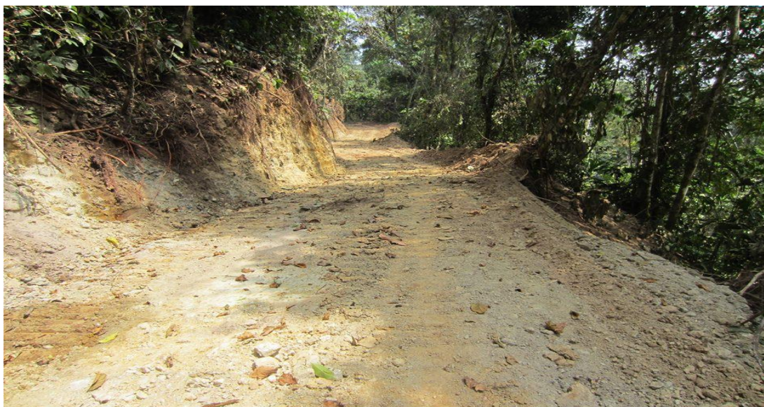
Inicios de la obra Carretera Alto San Pedro – Distrito Nuevo Progreso.
