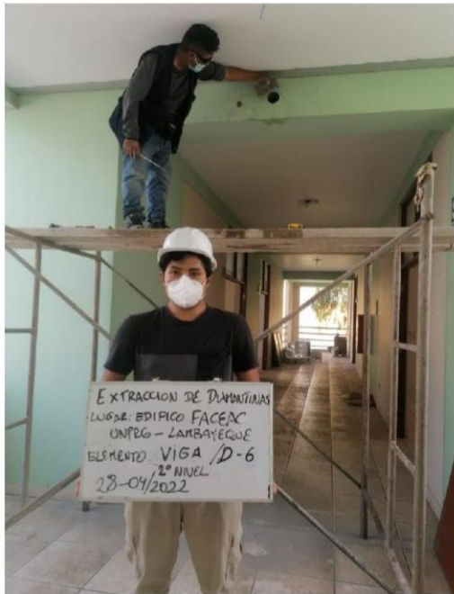
FOTO 09 Y 10: EXTRACCIÓN DE DIAMANTINA DE VIGA
