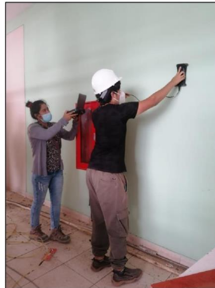
ANEXO 4- Escaneo en campo de ubicación de Aceros
