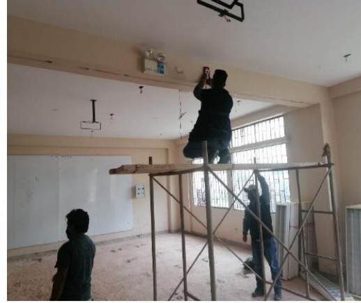
FOTO 01 Y 02: FIJACIÓN DEL EQUIPO SACATESTIGOS EN VIGA UTILIZANDO UN SISTEMA DE ANCLAJE, E IDENTIFICACIÓN DEL ACERO DE REFUERZO.
