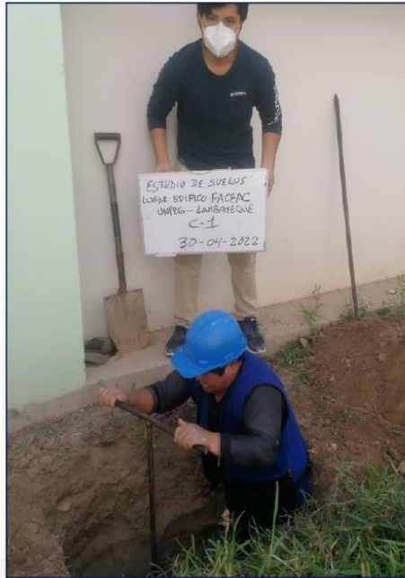
FOTO 01: CALICATA 01 (C-1) – USO DE POSTEADORA PARA EXTRACCIÓN DE
