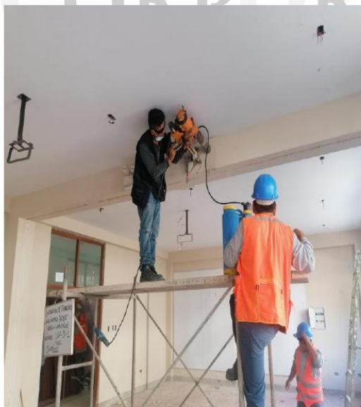
FOTO 03 Y 04: EXTRACCIÓN DE DIAMANTINA DE VIGA PARA LUEGO SER ENSAYADA EN LABORATORIO.
