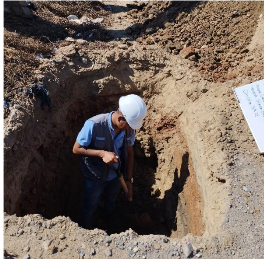
Ilustración 9: Calicata N°1 – extracción de muestra
