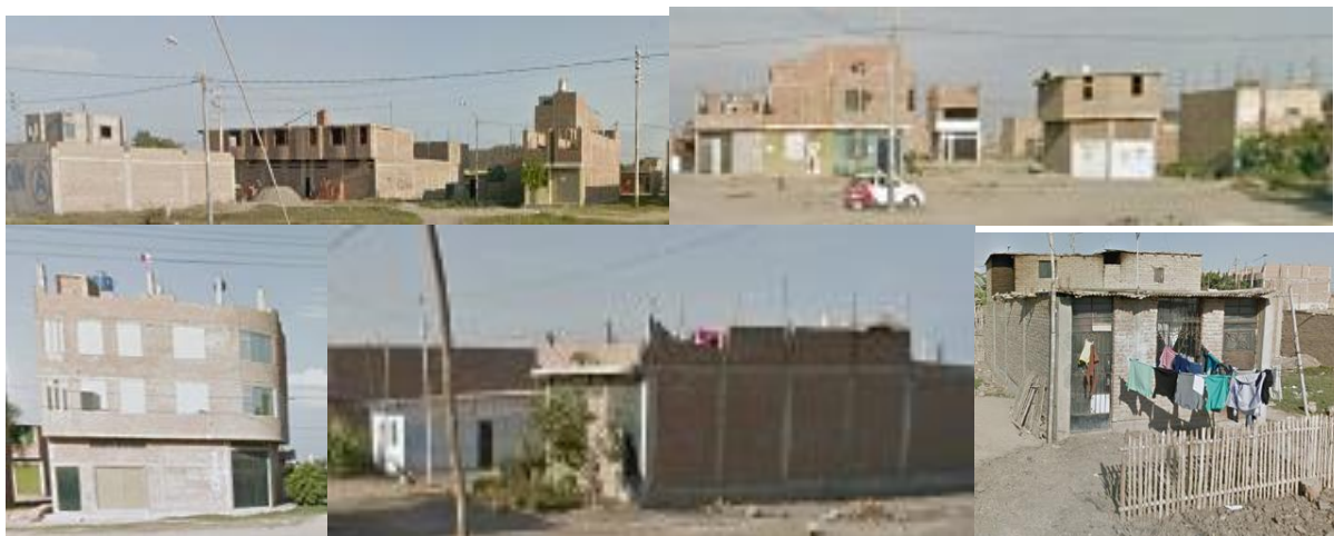
Figura 05. Registro fotográfico del estado actual de las viviendas del sector 4 de José Leonardo Ortiz
