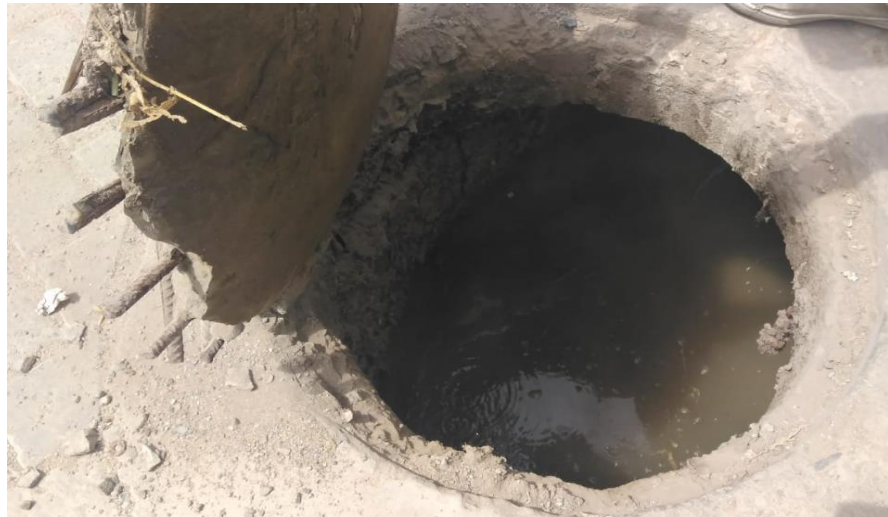
Fig. 7: Inspección de los Buzones (Semi Lleno); Fuente: Propia
