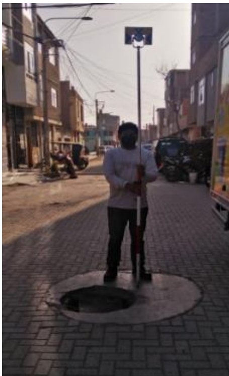
Foto 16:Toma de puntos en Buzones – Calle Atusparias; Fuente: Propia
