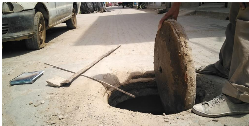
Fig. 6: El destape de buzón; Fuente: Propia
