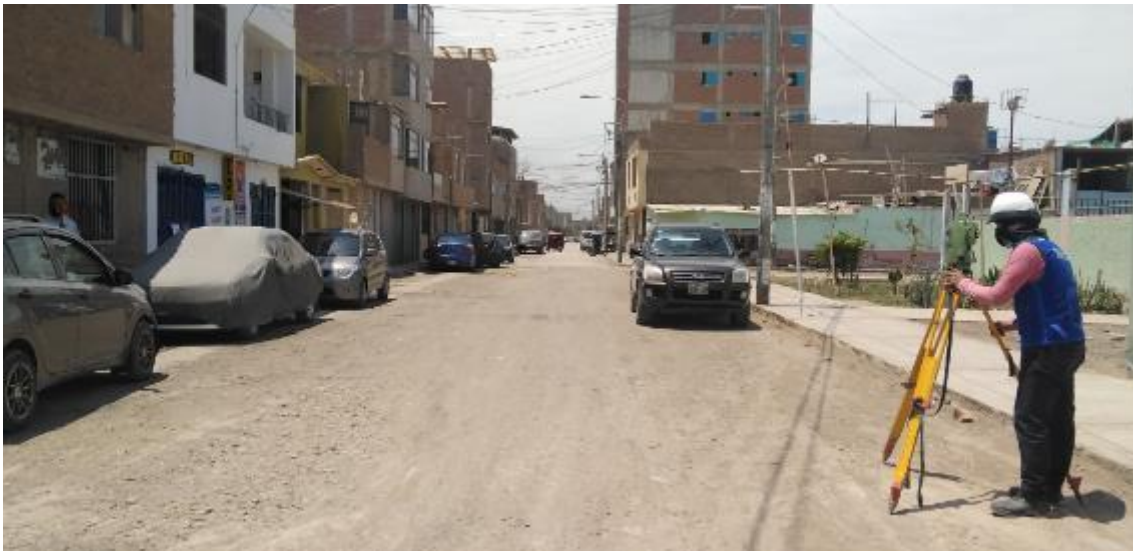
Foto 10:Toma de puntos en la Vereda – Calle Atusparias; Fuente: Propia
