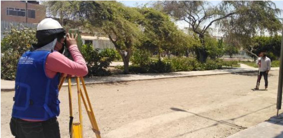
Foto 12:Toma de puntos en Asfalto deteriorado – Calle San Martin; Fuente: Propia
