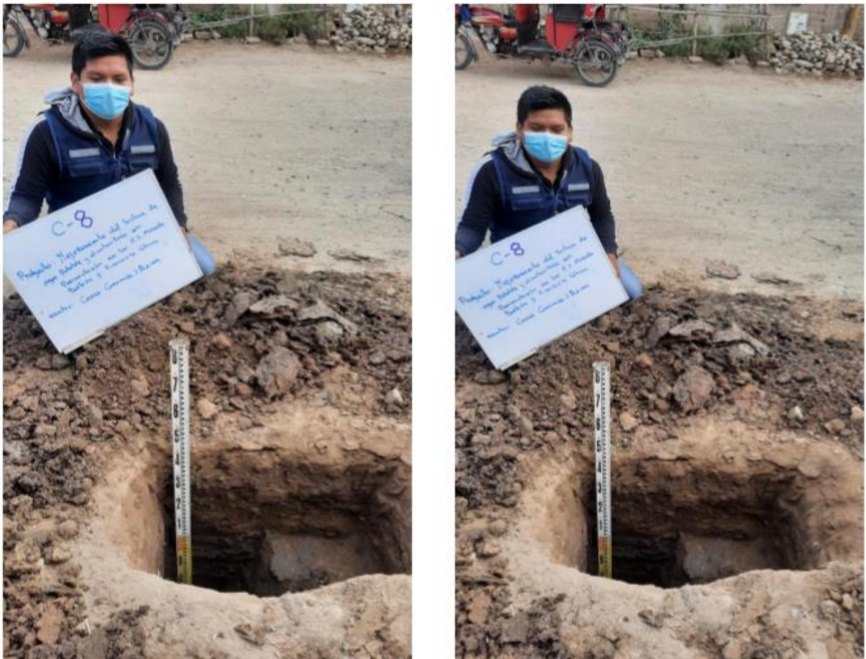
Foto 23:Excavación de la calicata C-8; Fuente: Propia
