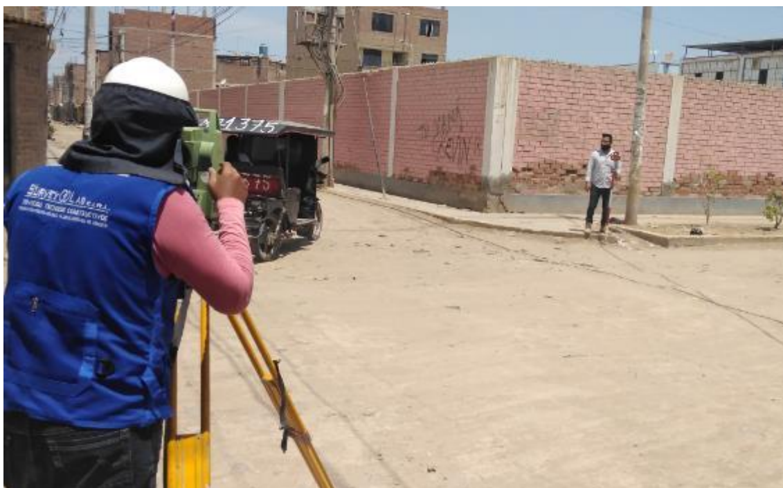
Foto 14:Toma de puntos en la Vereda – Calle Virrey Toledo; Fuente: Propia
