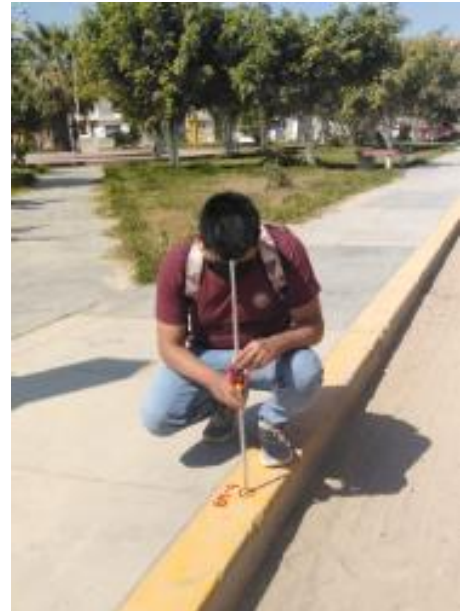
Foto 8: Punto BM-4 ubicado en la vereda del parque de Micaela Bastidas al frente de su respectiva losa deportiva con las coordenadas Norte: 9252710.484; Este: 629252.6617
