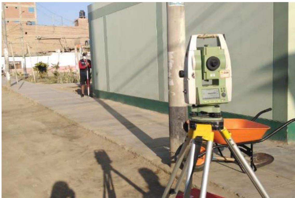
Foto 11:Toma de puntos en estructuras existente – Par -Fco. Cabrera; Fuente: Propia
