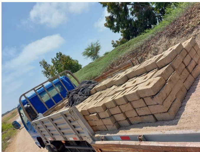
Figura 32. Transporte de las unidades de adobe
