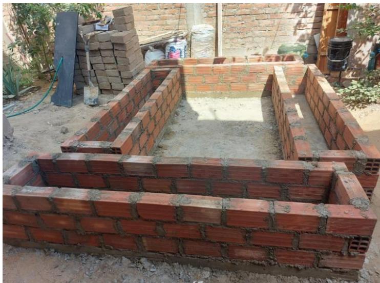
Figura 20. Elaboración de canales sin refuerzo
