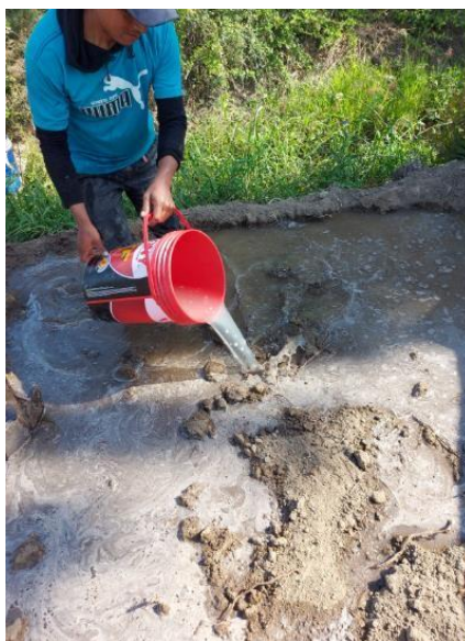
Figura 29. Proceso de elaboración del adobe adicionando mucílago del algarrobo
