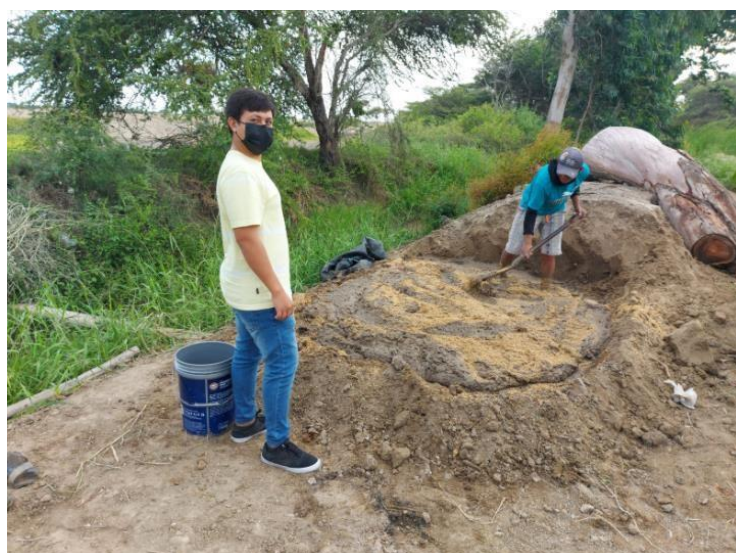
Figura 27. Proceso de elaboración del adobe
