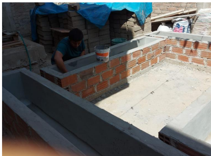
Figura 21. Impermeabilización de canales
