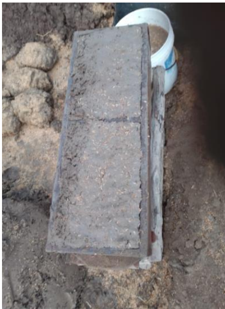
Figura 30. Colocación de adobe en gaveras
