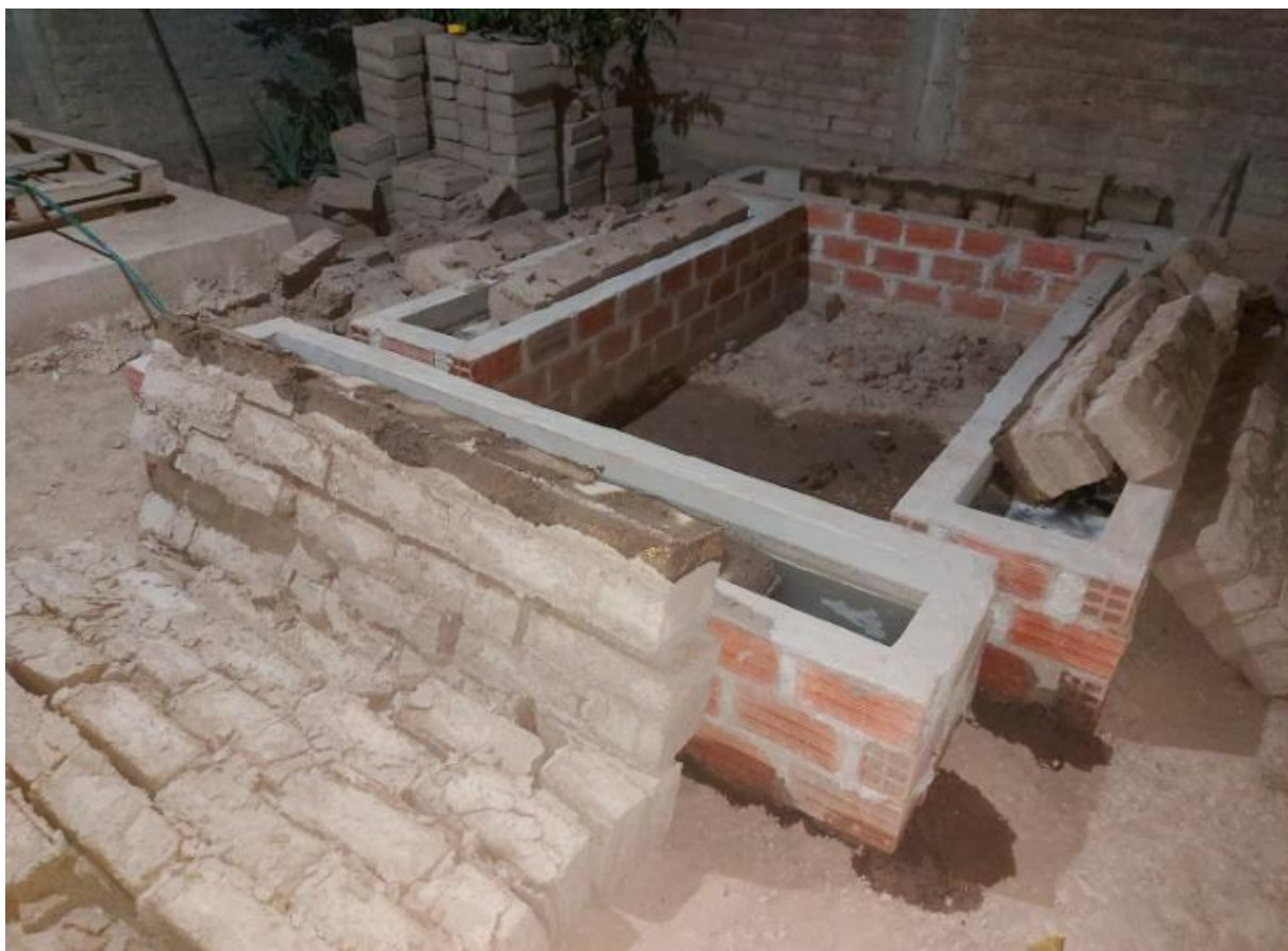
Figura 36. Volteo de muro de Adobe más 4% de mucílago de algarrobo
