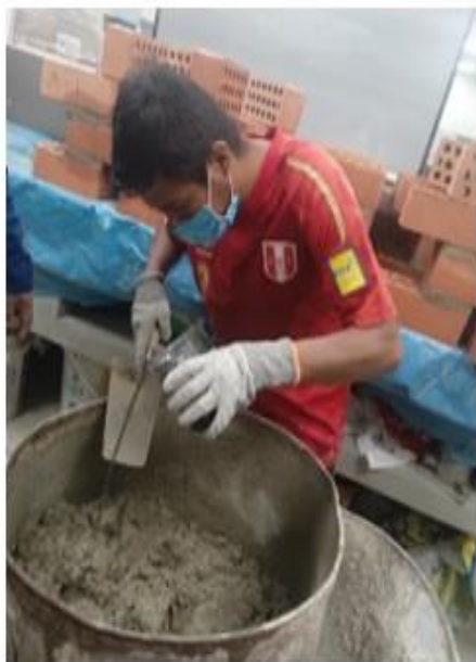
Imagen 51: Preparación de la mezcla con NPG para asentar pilas de albañilería
