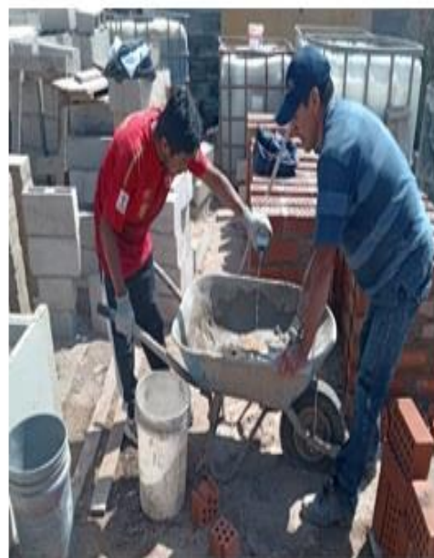
Imagen 56: Preparación de la mezcla con NPG para asentar muretes de albañilería
