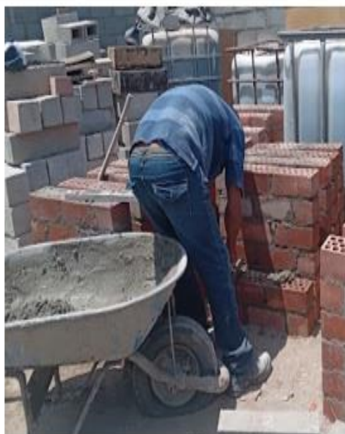
Imagen 57: Elaboración de los muretes de albañilería
