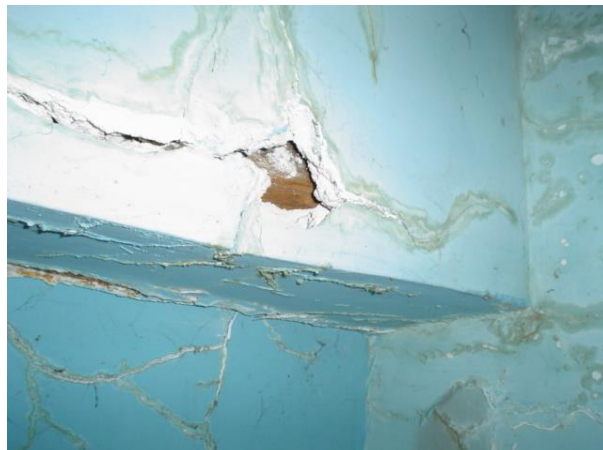
ENTREPISO CON VIGAS DE MADERA CON ENLUCIDO DE YESO
