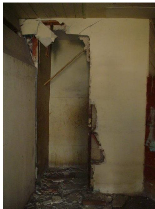
DETALLE DEL VANO DE LA PUERTA DEL BAÑO.
