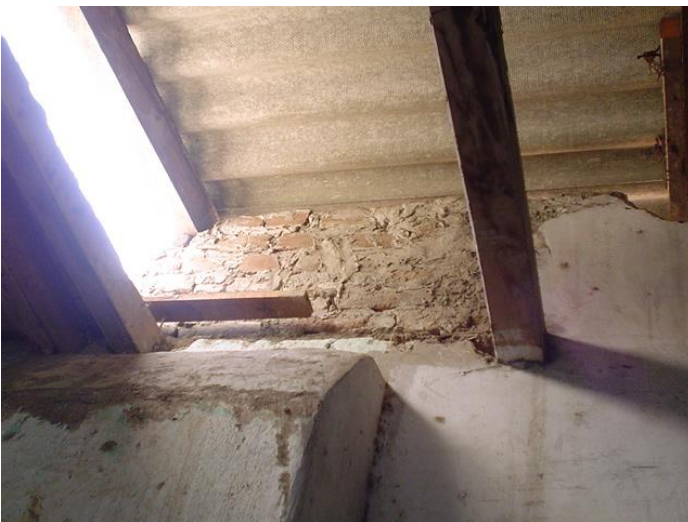
MOCHETA Y RELLENO DE LADRILLO
