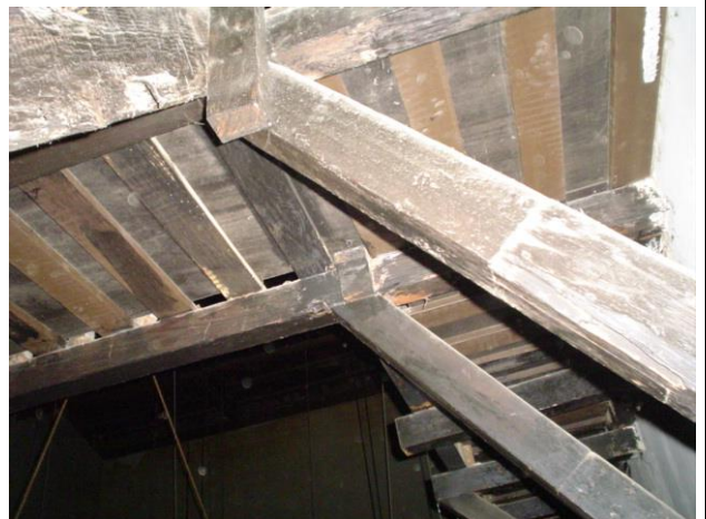
DETALLE DE EESTRUCTURA DE MADERA QUE SOSTIENE A LA TRMOYA
