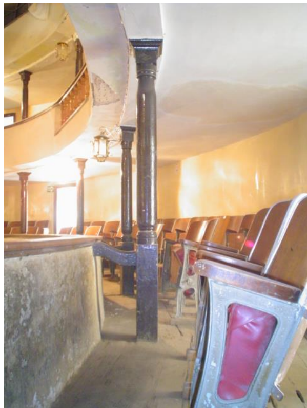
COLUMNA DE MADERA ESMALTADA COLOR CAOBA
