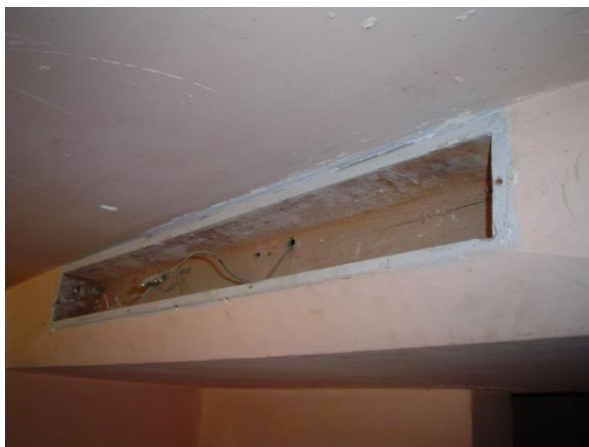
DETALLE DE LAS INSTALACIONES EMPOTRADAS DE MADERA.
