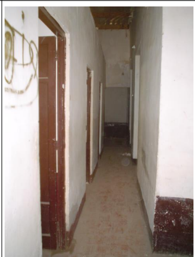
DETALLE DEL PASILLO, MUROS DE ADOBE (Derecha) Y DE LADRILLO (Izquierda)
