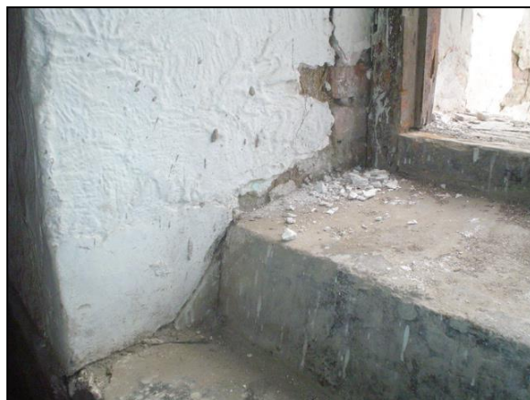
DETALLE DEL MURO DE ADOBE AL INTERIOR Y LADRILLO AL EXTERIOR.
