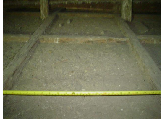
DETALLE DE LA ESTRUCTURA DEL CIELO RASO.
