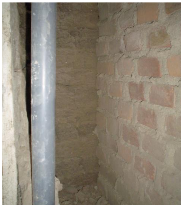
DIFERENCIA EN ANCHO DE MURO (ADOBE Y LADRILLO) SE APRECIA TAMBIEN LA TUBERÍA DE PVC
