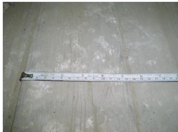
DETALLE DEL MACHIHEMBRADO DE MADERA DEL PISO.
