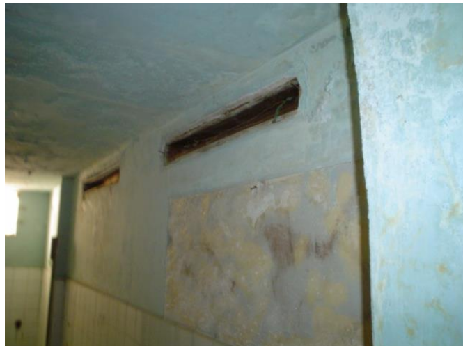
CAJAS DE MADERA EMPOTRADAS PARA FLUORESCENTE RECTANGULAR
