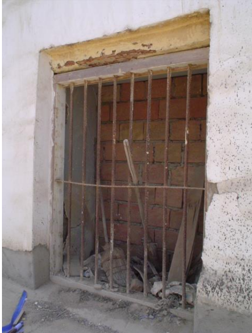
VISTA EXTERIOR DE LA VENTANA 35 (TAPIADA) DEL LADO IZQUIERDO DE LA CAZUELA.
