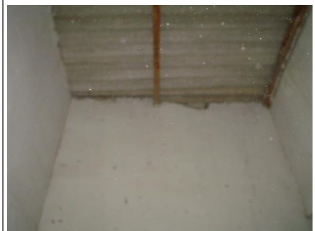
VIGUETAS Y COBERTURA
