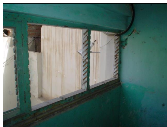
DETALLE DE LA VENTANA 17: BAJA, FIJA, DE MADERA TIPO APERSIANADA SIN QUELCOS.
