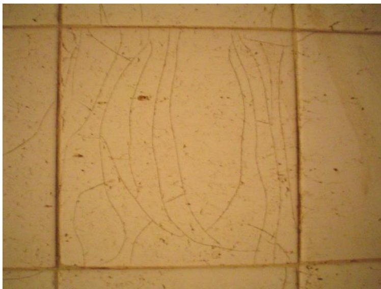
DETALLE DE MAYOLICA CUARTEADA, APARIENCIA SUCIA
