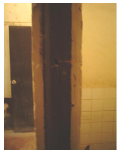
DETALLE EN PRIMER PLANO DE ANCHO DE MURO DE LADRILLO e = 15 cm.
