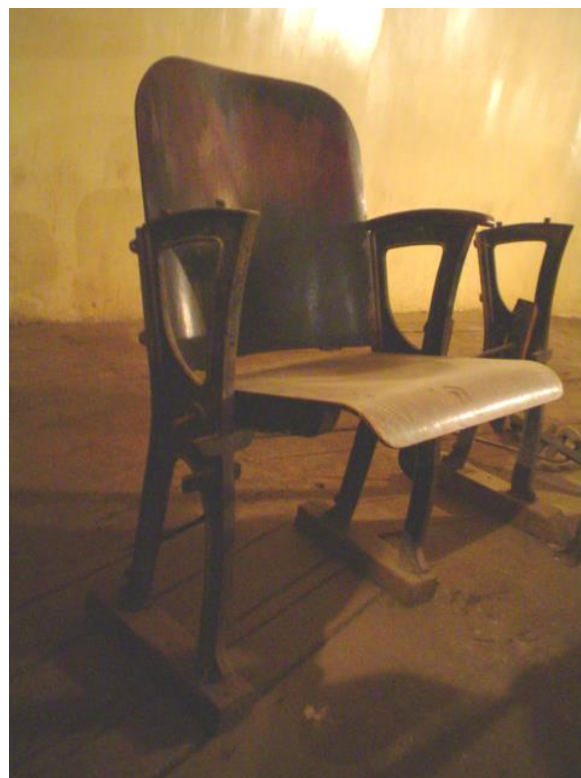
BUTACA ANTIGUA TOTALMENTE DE MADERA CON BRAZOS DE FIERRO, EMPERNADA EN EL PISO DE MADERA
