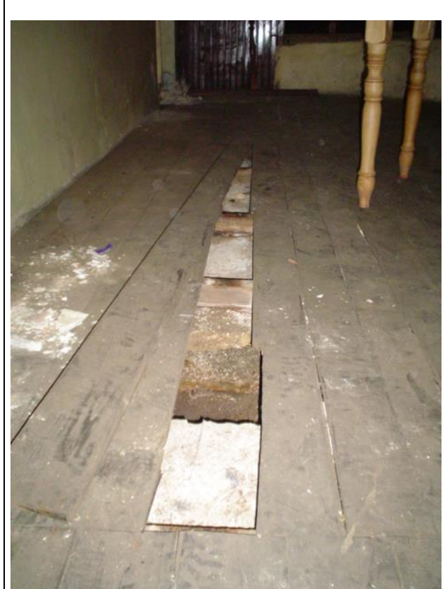
DETALLE DE LA ESTRUCTURA Y EL MACHIHEMBRADO DEL PISO
