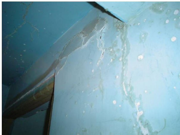
ENLUCIDO DE YESO CON ARIETAMIENTOS
