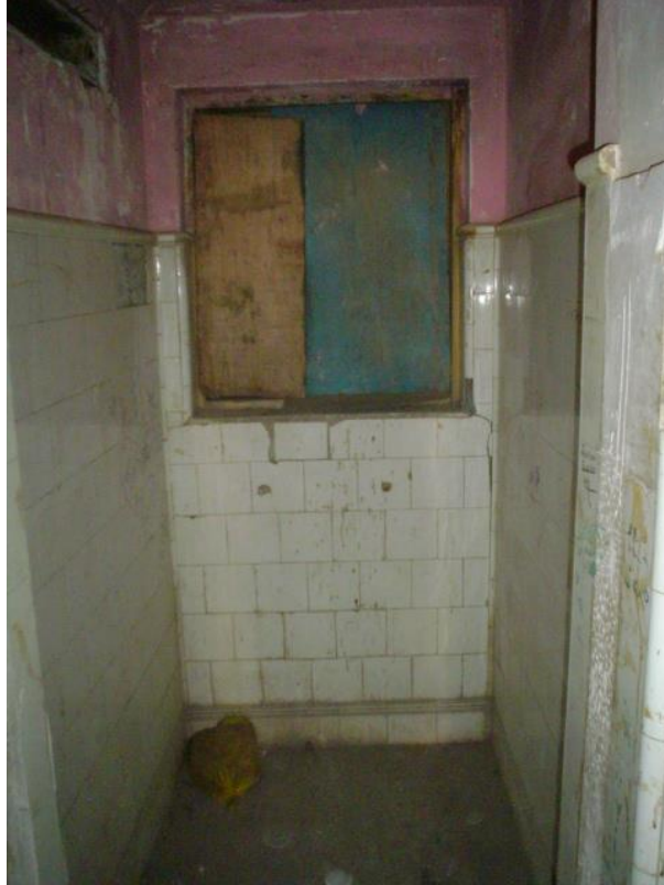
VENTANA TAPIADA CON TRIPLAY Y CARTON.
