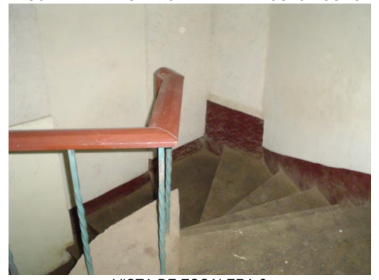
VISTA DE ESCALERA 2
