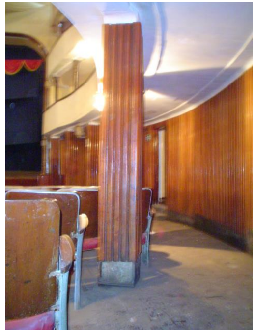
VISTA DE COLUMNA, CIELORAZO Y MACHIEMBRADO SOBRE MUROS Y COLUMNAS
