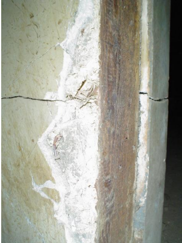
DETALLE DE ENCUENTRO DE MURO Y VANO DE LA PUERTA.
