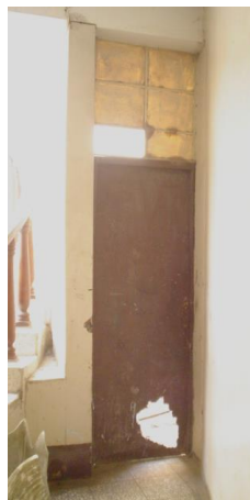
PUERTA P19 ACCESO A PATIO
