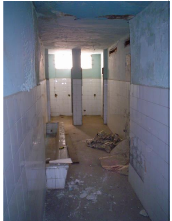
URINARIO DE OBRA ENCHAPADO CON MAYOLICA BLANCA E INSTALACIONES PARA 3 INODOROS Y 2 LAVATORIOS
