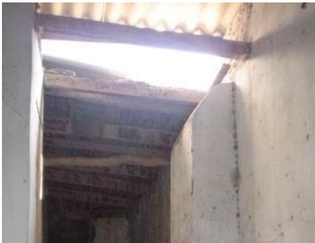
PARTE DE CIELO RASO EXISTENTE
