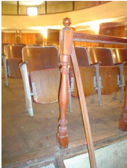
BARANDA Y FINAL DE RAMPA DE AREA DE BUTACAS
