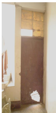
PUERTA P19 ACCESO A PATIO
