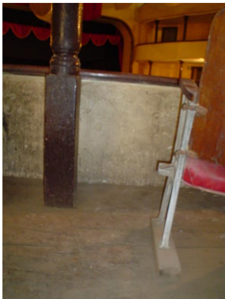
BARANDA RECUBIERTA CON SPANDEX METAL, CAÑA BRAVA, YESO Y TARRAJEO DE CEMENTO. CON PASAMANOS DE MADERA COLOR CAOBA
