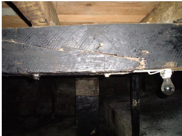
ENSAMBLE TIPO RAYO DE JUPITER E INSTALACION ELECTRICA
