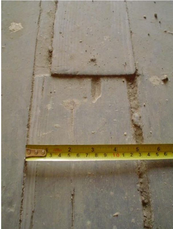
DETALLE DE PISO MACHIHEMRADO DE MADERA.
