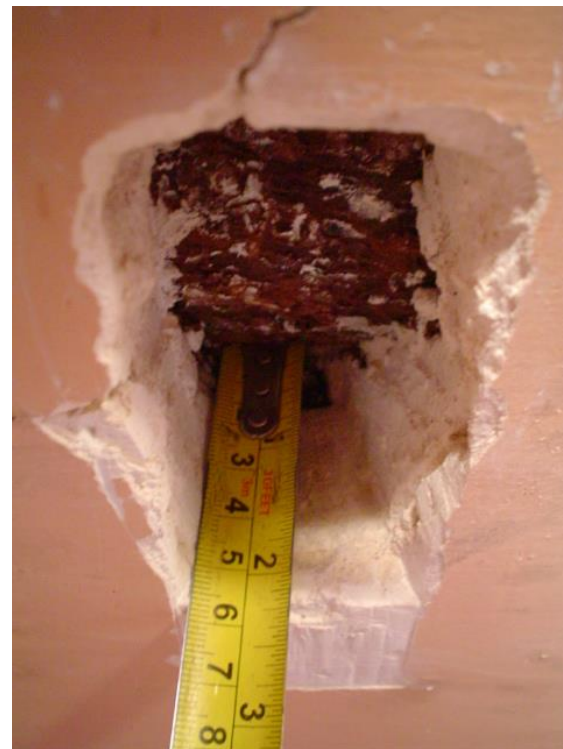
DETALLE DEL ENLUCIDO DE YESO DE e = 6 cm.
