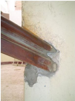
DETALLE DE ENCUENTRO BARANDA - COLUMNA – SIMPLE EMPOTRAMIENTO
