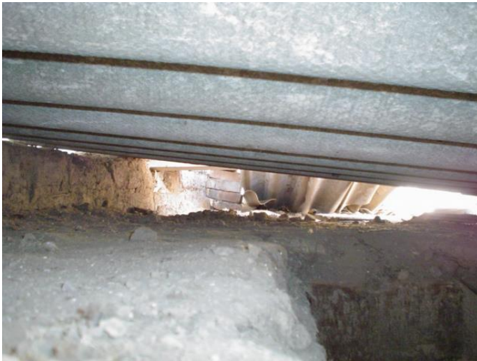
VISTA POR DEBAJO DE COBERTURA DE CALAMINA
