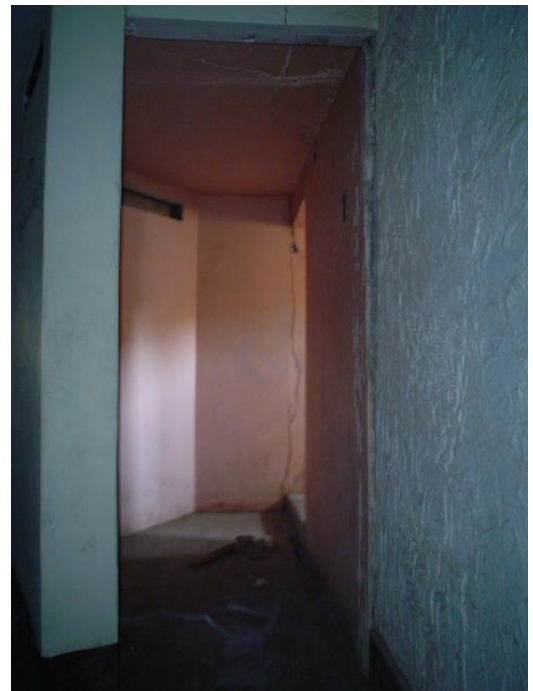
DETALLE DE LA PUERTA 39, QUE DA HACIA EL PASILLO NO PRESENTA HOJA, SOLO MARCO DE MADERA.
