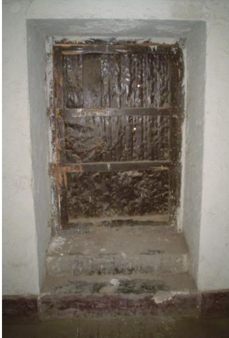
DETALLE DE PUERTA DE MADERA Y LATON CON MARCO DE MADERA .
