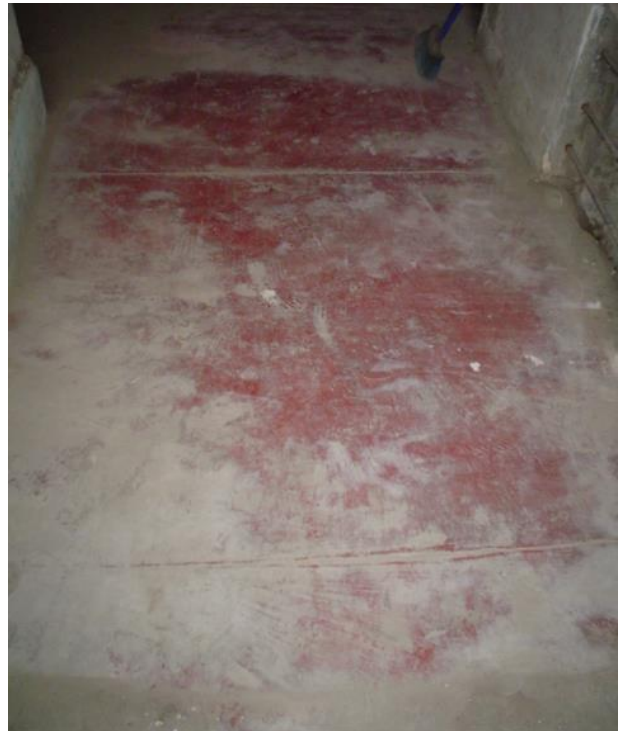
ESTADO DEL PISO TERMINADO DE CEMENTO PULIDO OCRE
