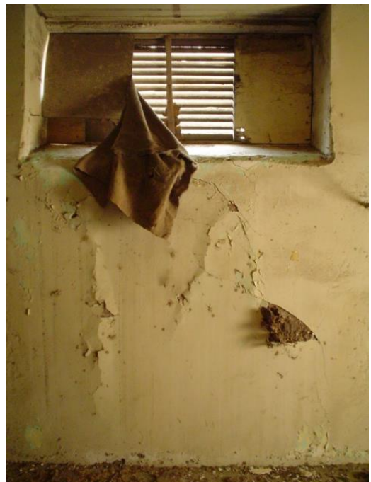
DETALLE DE LA VENTANA 38.
