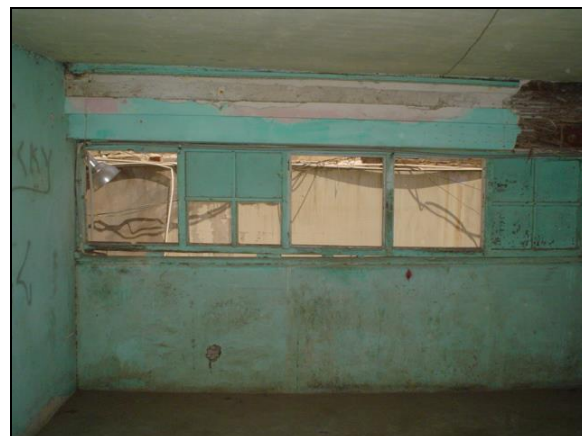
DETALLE DE LA VENTANA 15: BAJA, BATIENTE DE MADERA Y VIDRIO CON MARCO DE MADERA Y SIN VDRIO.
