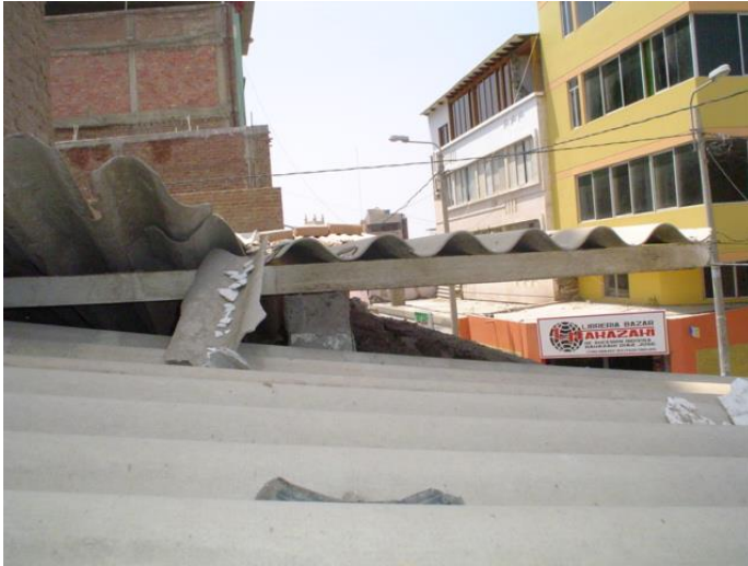
VISTA POR ENCIMA DE COBERTURA DE CALAMINA
