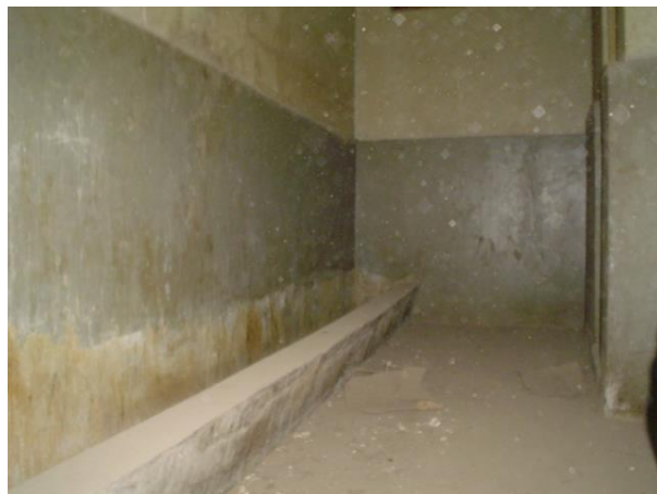
DETALLE DE URINARI HECHO EN OBRA DE CEMENTO PULIDO.
