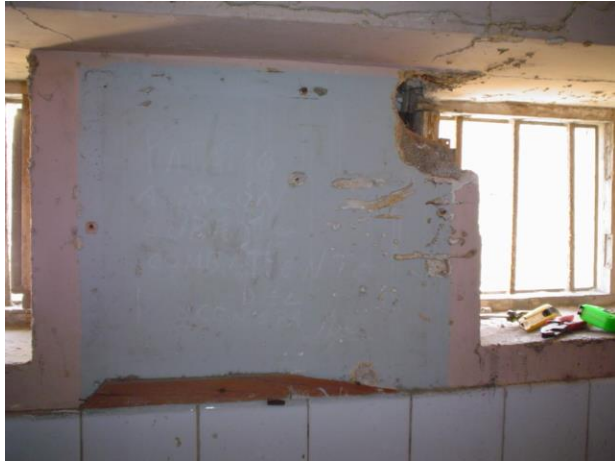
DETALLE DE LA PINTURA ACTUAL (ROSADO) Y LA PINTURA ANTERIOR (GRIS).
