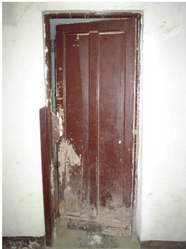
PUERTA DE MADERA BATIENTE CON MARCO DE MADERA ESMALTADA COLOR CAOBA.
