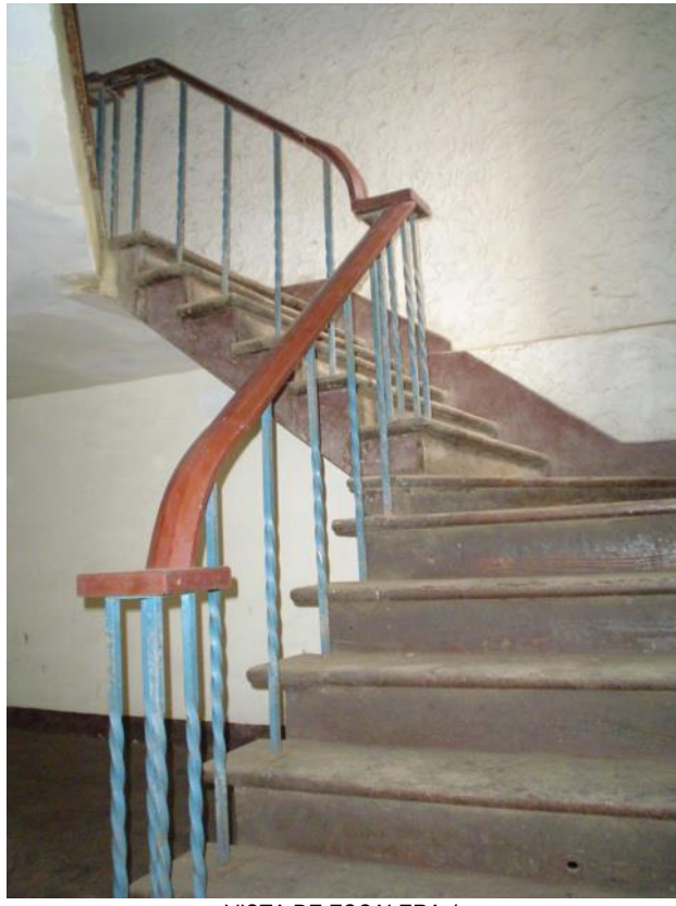
VISTA DE ESCALERA 1
