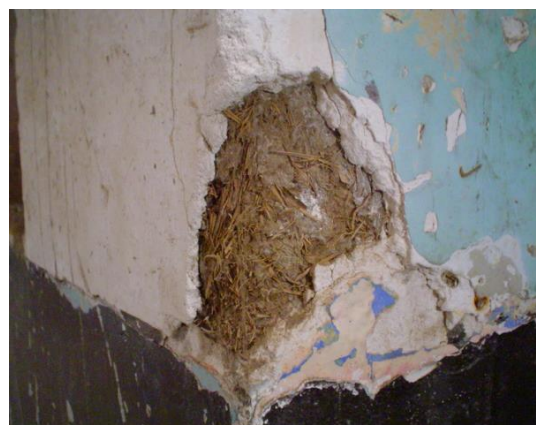
DETALLE DE ENLUCIDO DE YESO SOBRE MURO DE ADOBE
