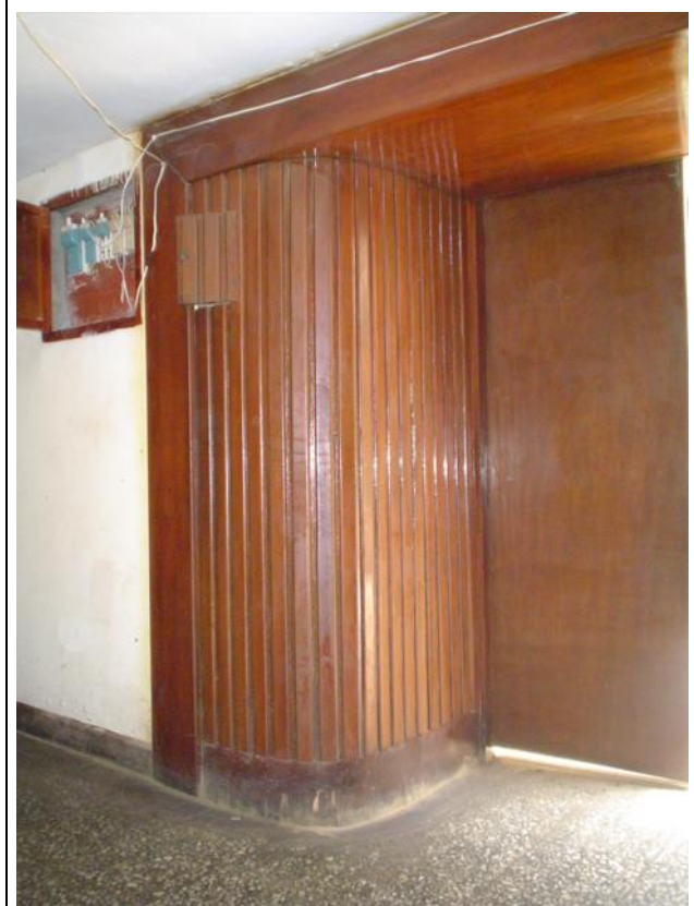
VISTA DEL MACHIEMBRADO DEL MARCO DE PUERTA DE INGRESO P08
