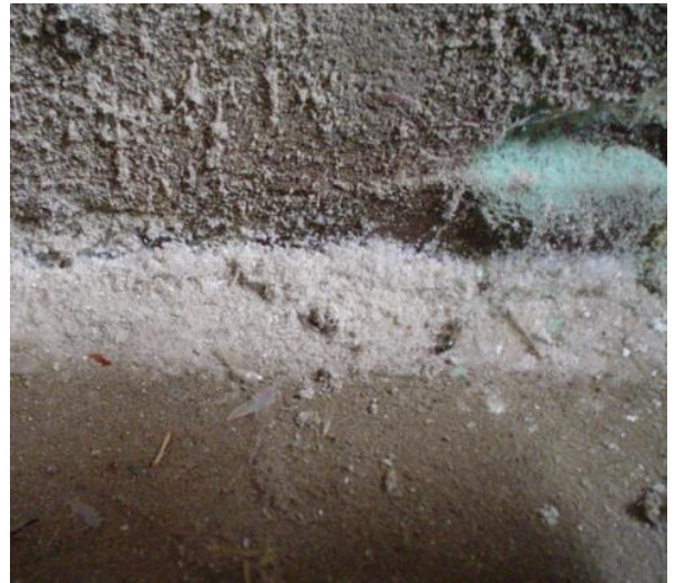
DETALLE DE SALINIDAD QUE MUESTRAN LOS MUROS COLINDANTES CON EL ESCENARIO
