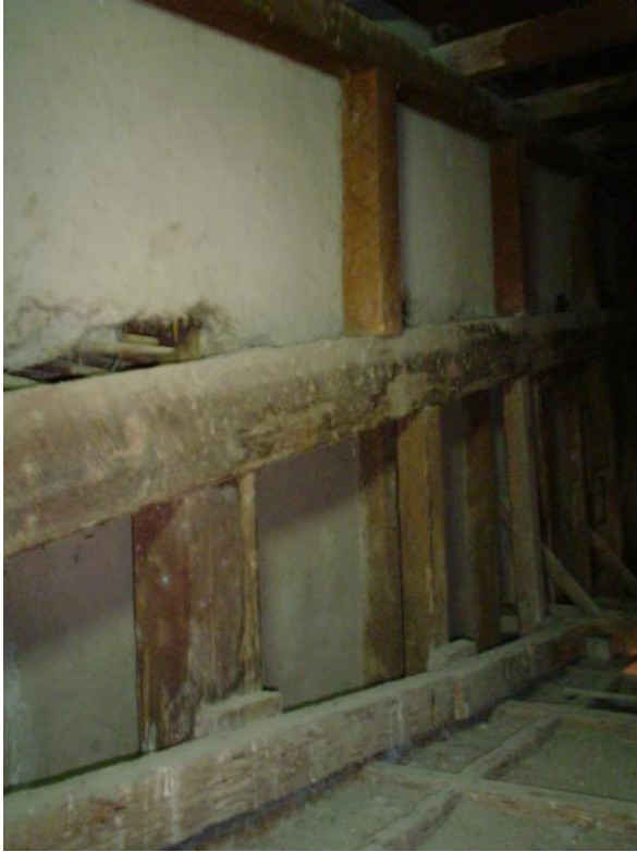
DETALLE DE ESTRUCTURA DE TIJERAL QUE PRESENTA EL TECHO DEL TEATRO.
