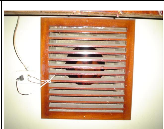
DETALLE DE LA VENTANA DE MADERA BARNIZADA QUE COMUNICA LA FOSA CON EL SOTA ESCENARIO.
