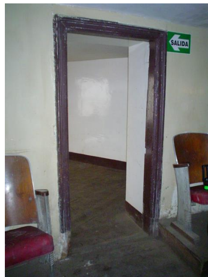
P2b SIN HOJA Y CON MARCO DE MADERA ESMALTADO COLOR CAOIBA PICADO
