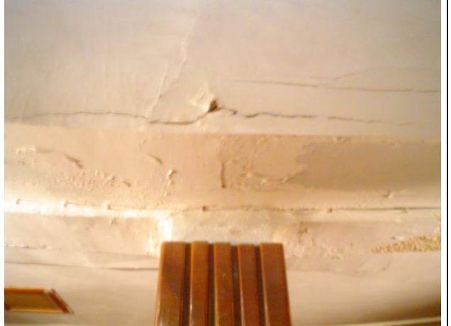
FALLA POR HUNDIMIENTO DE COLUMNA
