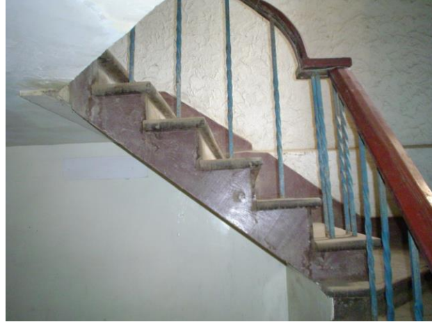
ESCALERA 1 CON DETALLE DE BALAUSTRES DE FIERRO Y PASAMANO DE MADERA
