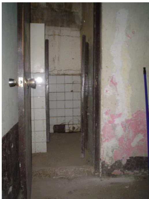
VISTA DONDE SE APRECIA EL BAÑO DE VESTUARIOS
