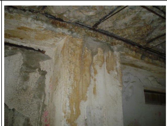
ENCUENTRO COLUMNA Y VIGA DE TECHO
