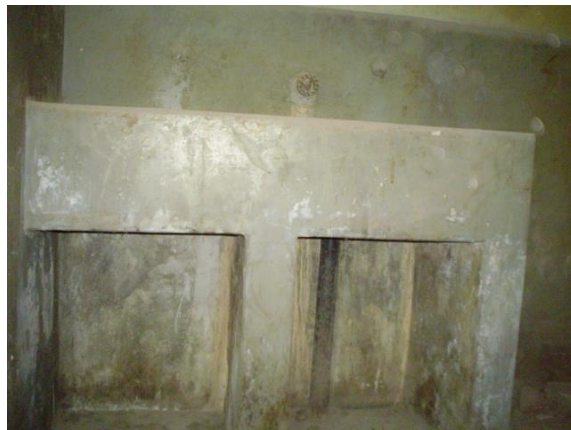
DETALLE DE LAVATORIO HECHO EN OBRA DE CEMENTO PULIDO.
