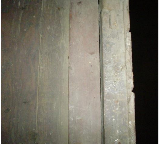
DETALLE DE PISO DE MADERA MACHIEMBRADA
