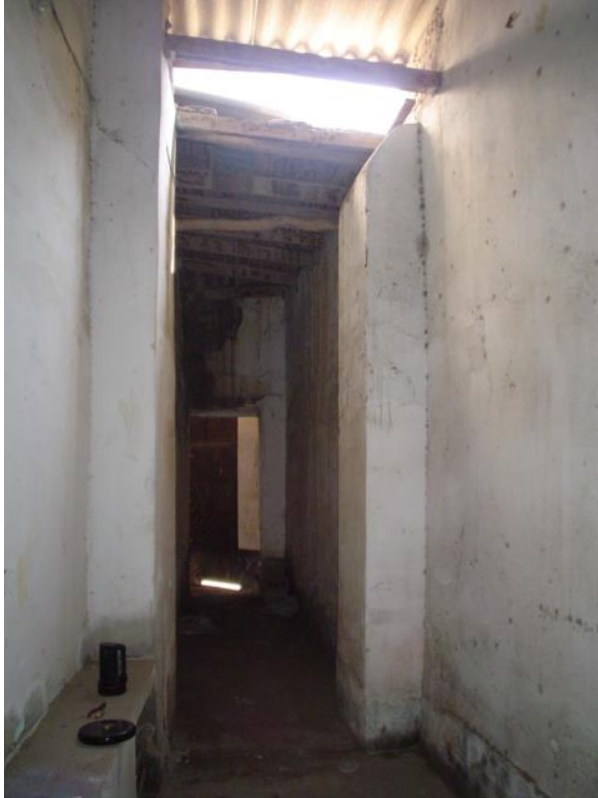
DETALLE DE MACHONES EN MUROS DE ADOBE
