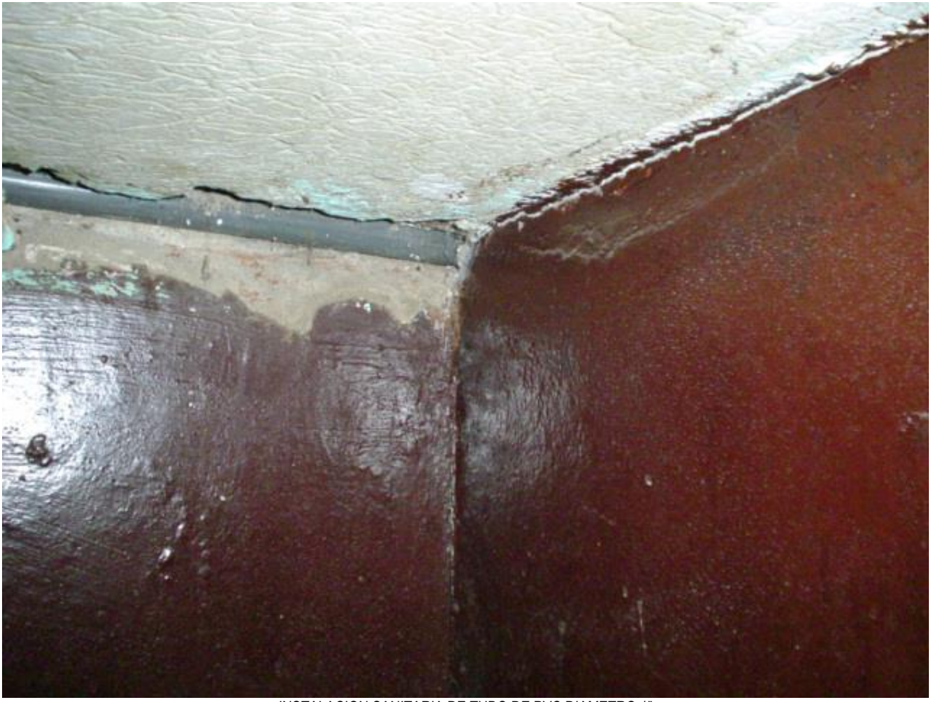
INSTALACION SANITARIA DE TUBO DE PVC DIAMETRO 1"
