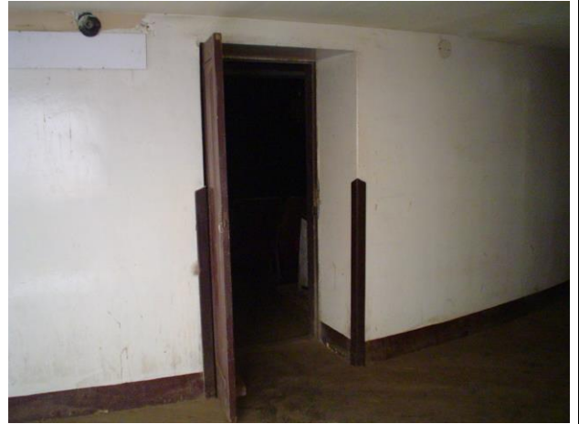
PUERTA CON FILOS DE MADERA SOBRE MURO DE ADOBE TIPO P22
