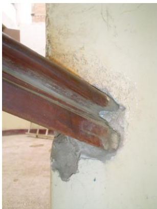
DETALLE DE ENCUENTRO BARANDA - COLUMNA - SIMPLE EMPOTRAMIENTO
