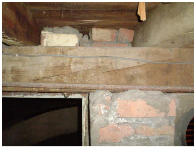
ENSAMBLE TIPO RAYO DE JUPITER Y TIRANTE DE FIERRO
