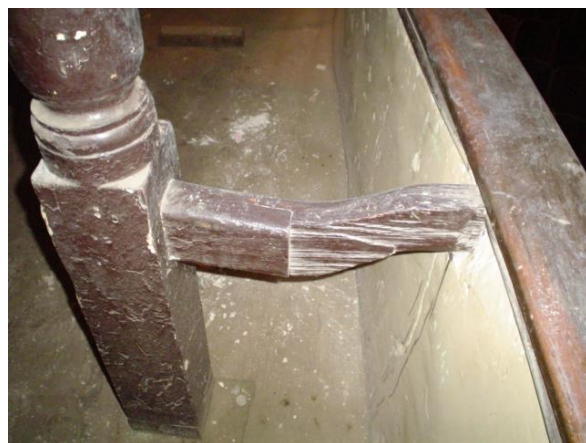
ARRRIOSTRE DE MADERA EN FORMA DE Z COLOR CAOBA
