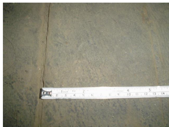
DETALLE DEL PISO DE MADERA MACHIEMBRADO TRASLAPADO.
