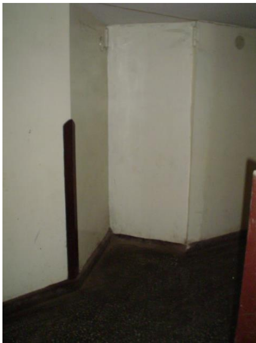
VISTA DE PUERTA TAPIADA CON LADRILLO
