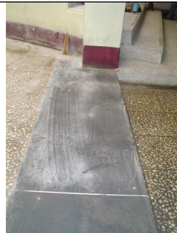
DETALLE DE DESNIVEL CON CEMENTO PULIDO CON BRUÑAS DE ALUMINIO
