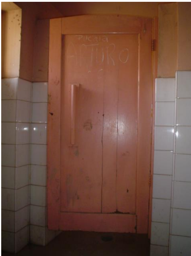
DETALLE DE LA PUERTA 38: BATIENTE DE MADERA Y CON MARCO DE MADERA. PINTADA CON ESMALTE COLOR ROSADO.
