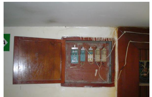
DETALLE DE CAJA DE LLAVES CUCHILLAS (CINCO)
