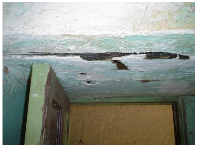
UMBRAL DE PUERTA DE INGRESO AL AMBIENTE
