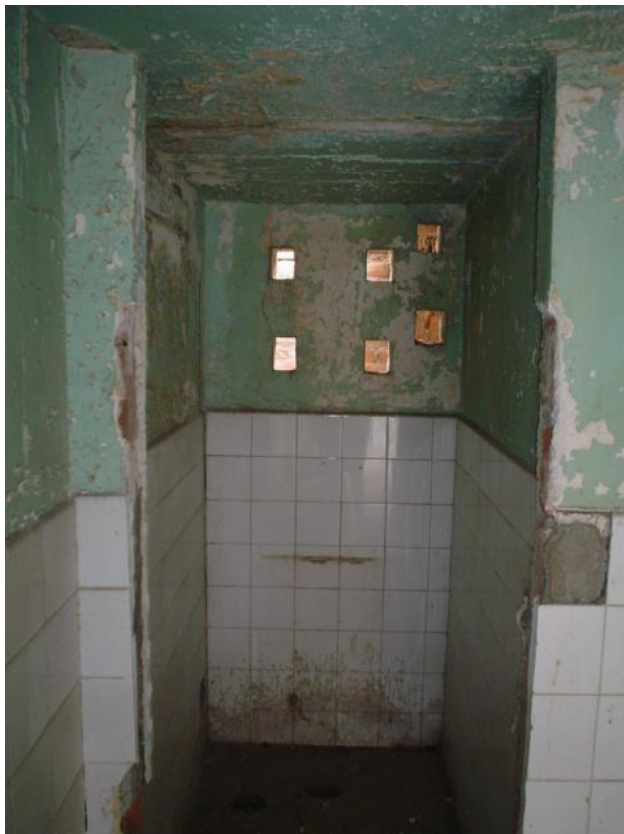
VENTANA V9, TAPIADA CON ORIFICIOS PARA VENTILACION
