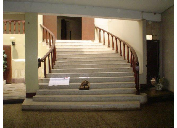
ESCALERA DE CONCRETO CON BALAUSTRADA DE MADERA
