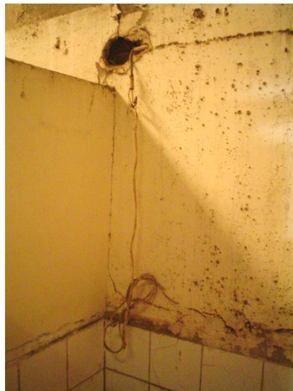
INSTALACION ELECTRICA, EN BAÑO
