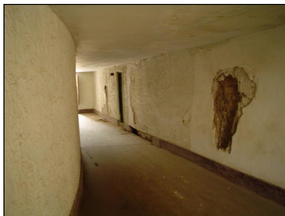
VISTA DEL PASILLO DERECHO DEL TERCER NIVEL.
