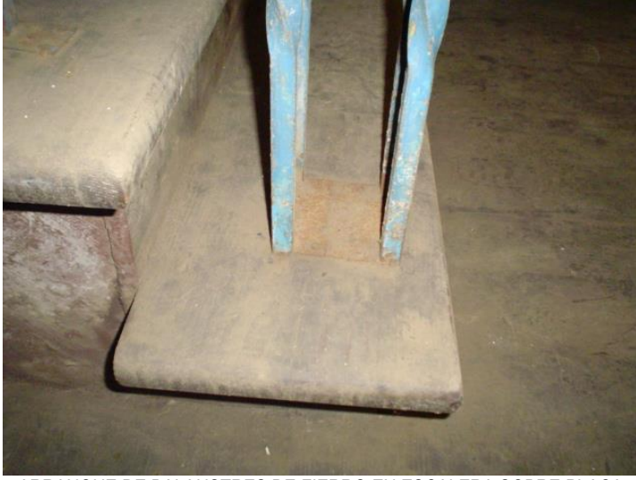
ARRANQUE DE BALAUSTRAS DE FIERRO EN ESCALERA SOBRE PLACA CUADRADA DE FIERRO.
