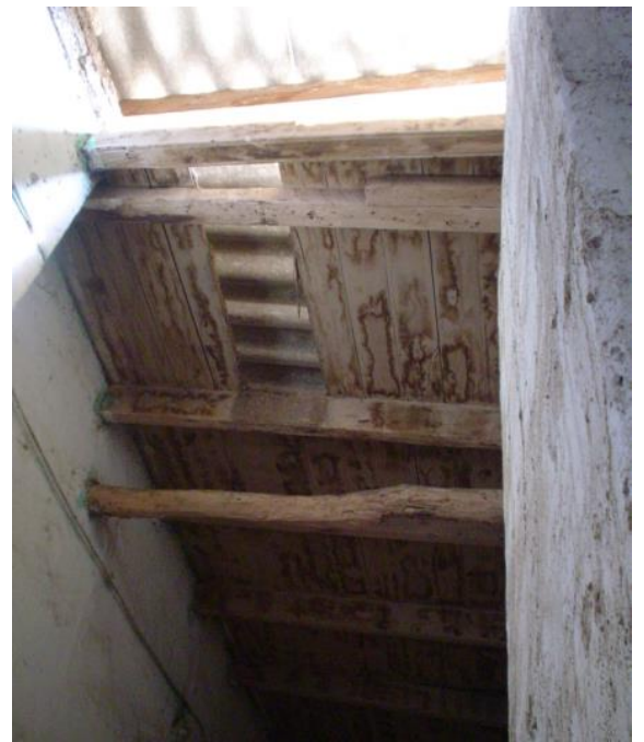
DETALLE DE CIELO RAZO Y COBERTURA DE ETERNIT
