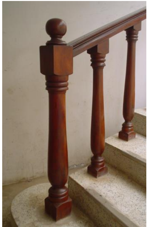
DETALLE ARRANQUE DE BARANDA DE ESCALERAS, CON BALAUSTRÉS TORNEADOS, DE RECIENTE FACTURA
