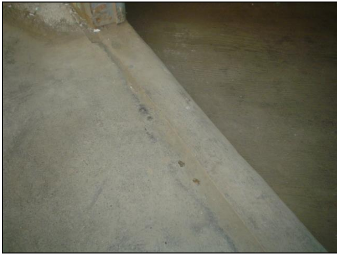
DETALLE DEL PISO DE CEMENTO PULIDO CON CANTONERA DE MADERA.-
