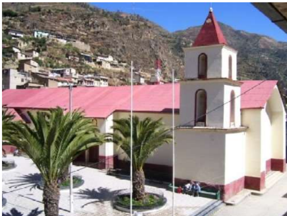
Figura 50. Iglesia San Juan Bautista de Huasahuasi.
