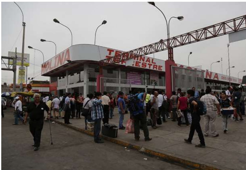
Figura 29. Terminal de Yerbateros – Lima.
