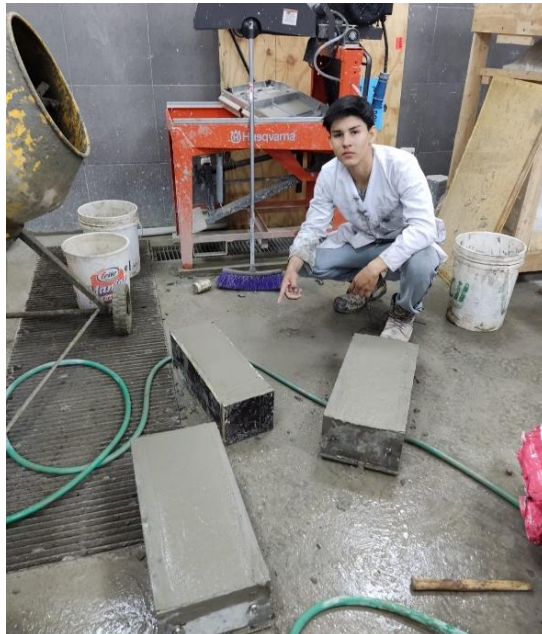
Ilustración 21. Vaciado de concreto para vigas
