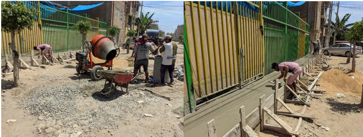
Ilustración 24. Vaciado de concreto para la evaluación de fisuras con retracción plástica
