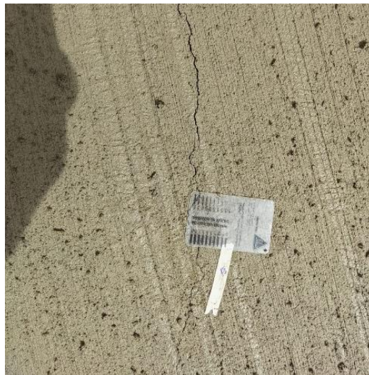
Ilustración 30. Tarjeta de medición de fisuras y grietas
