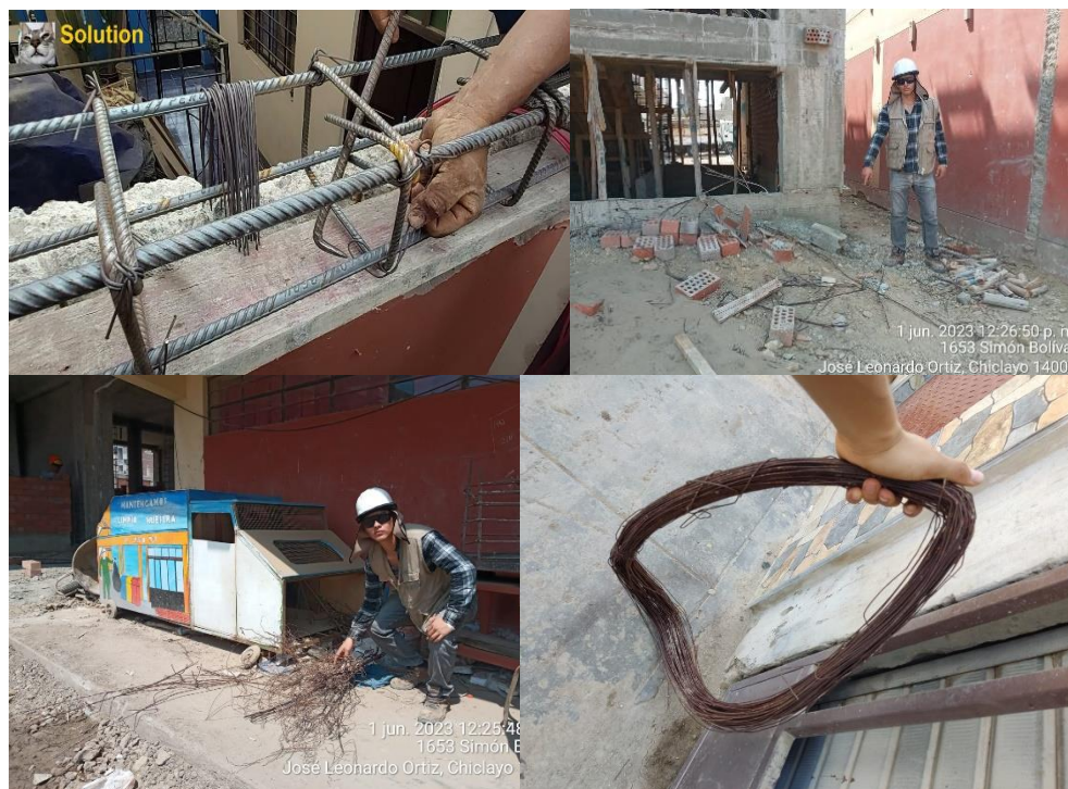
Ilustración 10. Extracción de alambre reciclado N° 16
