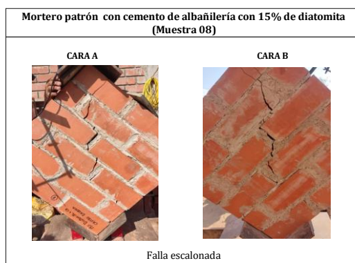
Ilustración 37: Falla N°08 Mortero con 85% cemento de albañilería + 15% de diatomita
