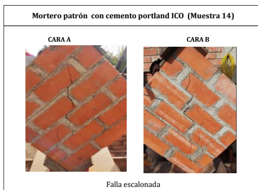
Ilustración 43: Falla del murete N°14 Mortero con cemento portland ICO
