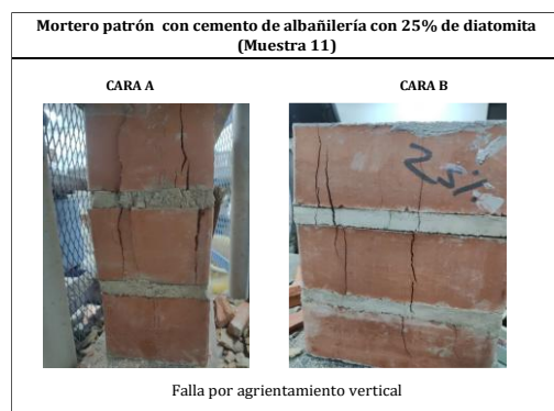
Ilustración 24: Falla N°11 Mortero con 75% cemento de albañilería + 25% de diatomita
