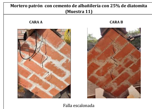
Ilustración 40: Falla N°11 Mortero con 75% cemento de albañilería + 25% de diatomita
