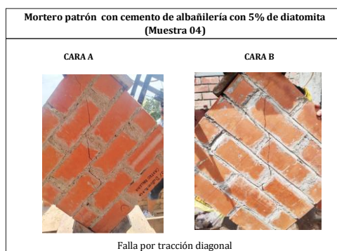
Ilustración 33: Falla N°04 Mortero con 95% cemento de albañilería + 5% de diatomita
