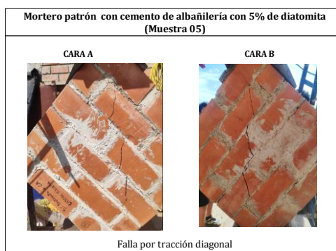
Ilustración 34: Falla N°05 Mortero con 95% cemento de albañilería + 5% de diatomita
