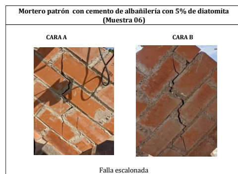
Ilustración 35: Falla N°06 Mortero con 95% cemento de albañilería + 5% de diatomita
